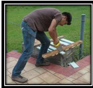
Imagen 8, "Corte de las tablas para silo compostador"
