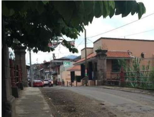
Ilustración 195. Puente Peatonal y Vehicular. (GARCÍA CHÁVEZ, 2016)
