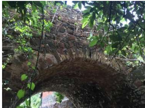
Ilustración 162. Juntas de los arcos cerradas con hormigón. (GARCÍA CHÁVEZ, 2016)
