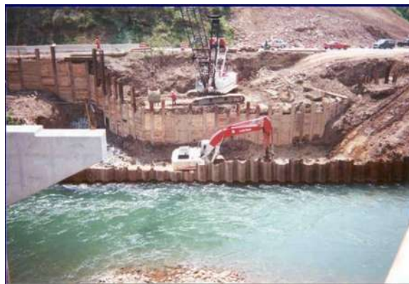
Ilustración 44. Obras de desvío. (SCT e Imcyc, pág. 16)
