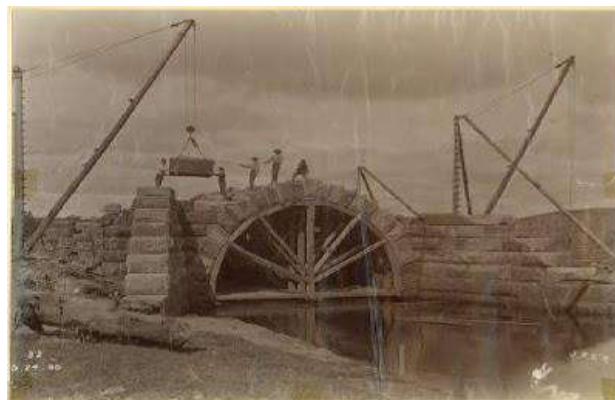
Ilustración 49. Colocación de dovelas y piezas para muros laterales. ( arcos25.blogspot, 2011 )
