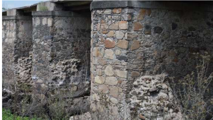
Ilustración 224. Pilares del puente con recubrimiento de concreto. (GARCÍA CHÁVEZ, 2016)
