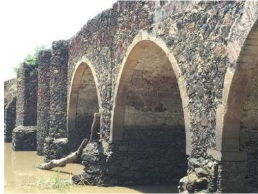
Ilustración 140. Características principales del puente y arrastre de material granular de tajamares. (GARCÍA CHÁVEZ, 2016)
