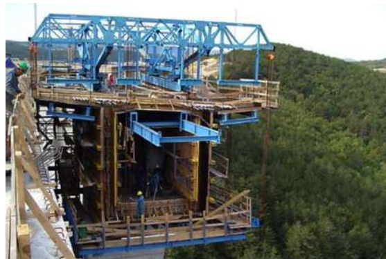
Ilustración 290. Avance en Voladizo por medio de un carro de avance. (Puente Chilina, 2013)
