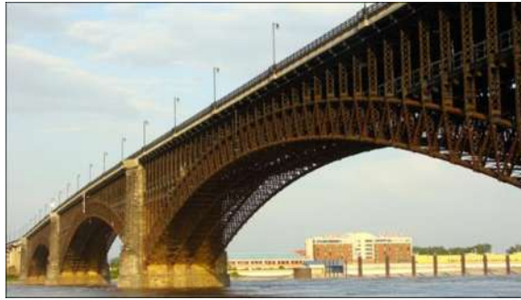
Ilustración 255. Puente EADS BRIDGE. Saint-Louis, EEUU, (siglo XIX), (PUENTEMANIA, 2011)
