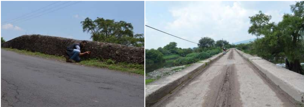
Ilustración 131. Levantamiento del puente en planta por medio de los aparatos de medición antes mencionados. (GARCÍA CHÁVEZ, 2016)
