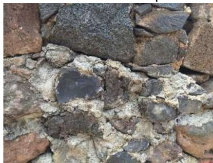
Ilustración 158. Restauraciones realizadas al puente por los habitantes de la zona. (GARCÍA CHÁVEZ, 2016)
