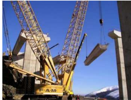
Ilustración 282. Empleo de Grúas en puentes tipo viga. (ocw, s.f., pág. 27)
