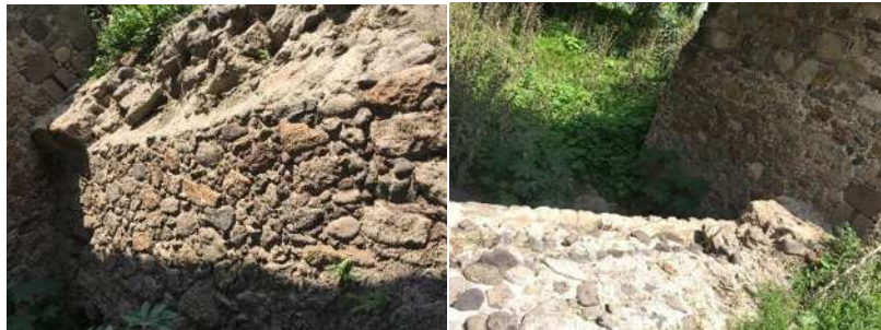
Ilustración 223. Guarniciones elaboradas con mampostería en los extremos del puente. (GARCÍA CHÁVEZ, 2016)
