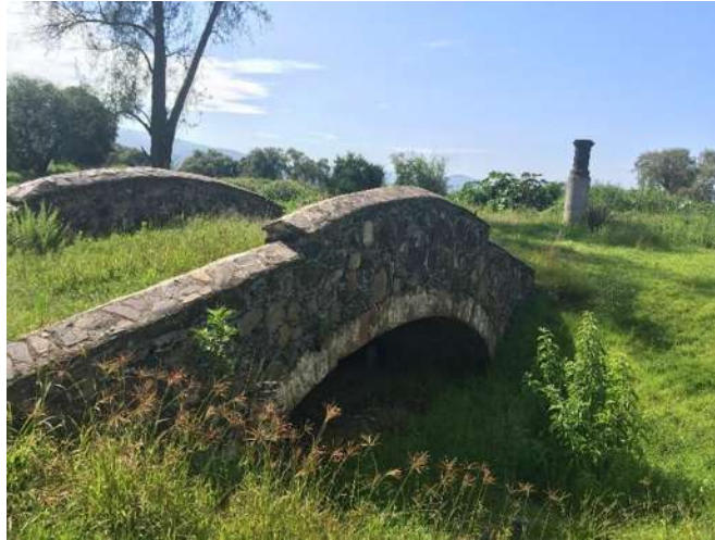
Ilustración 164. Puente Ubicado en la localidad de Tiripetío, en el Mpio. De Morelia, Mich. (GARCÍA CHÁVEZ, 2016)
