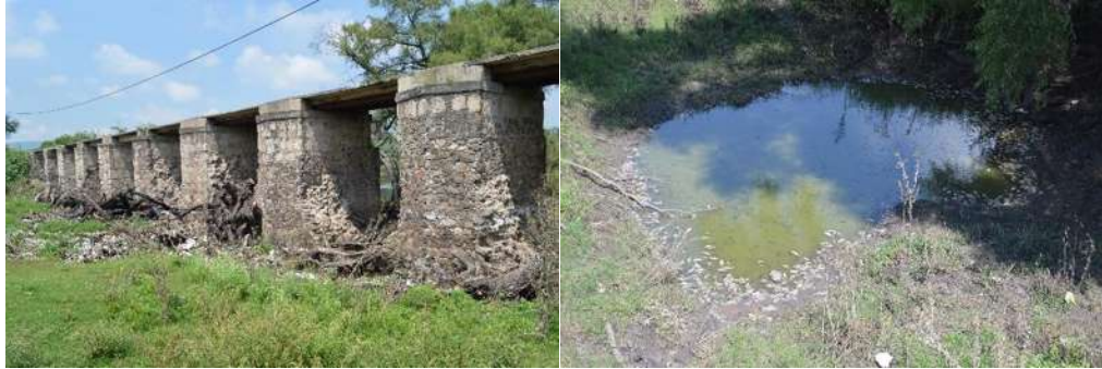
Ilustración 214. Condiciones del Puente y Fauna que habita en el Río Lerma cerca del Puente. (GARCÍA CHÁVEZ, 2016)
