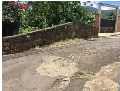
Ilustración 159. Capa de asfalto colocada sobre la calzada de material granular. (GARCÍA CHÁVEZ, 2016)
