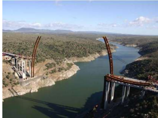
Ilustración 271. Ejecución del puente Arcos de Alconétar, Cáceres, España. (TESIS-YULIA DEMNCHENK.pdf, s.f., pág. 22)
