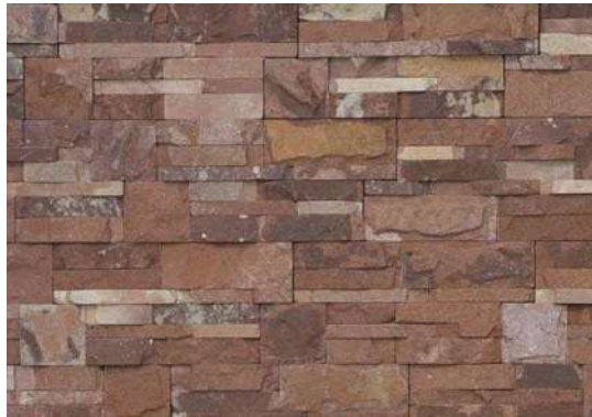
Ilustración 98. Sillería de Ladrillo a hueso. (Sogestone, 2011)
