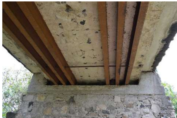
Ilustración 220. Viguetas de acero que conforman la estructura del Puente. (GARCÍA CHÁVEZ, 2016)
