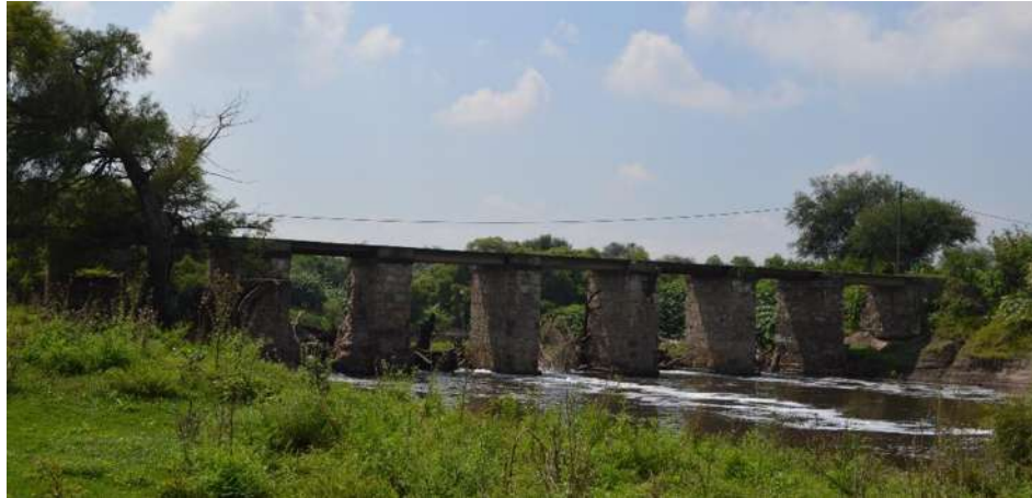
Ilustración 210. Puente ubicado en el Mpio. De Penjamillo, Mich. (GARCÍA CHÁVEZ, 2016)
