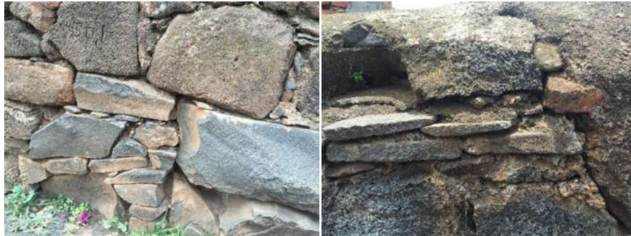
Ilustración 163. Restauración del Muro del Pretil con lajas de basalto y mortero. (GARCÍA CHÁVEZ, 2016)
