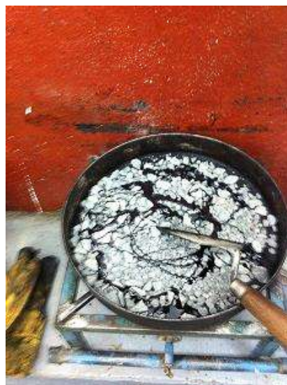
Fig.- 8.2.5 – Vertido de cemento asfáltico
