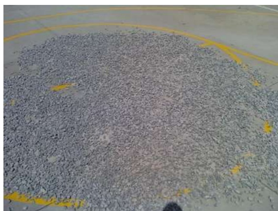
FIGURA 6.1.5 Extendido de Material
