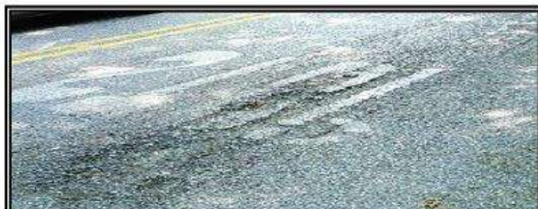
Ilustración 3.2.4: Desintegración de la carpeta
