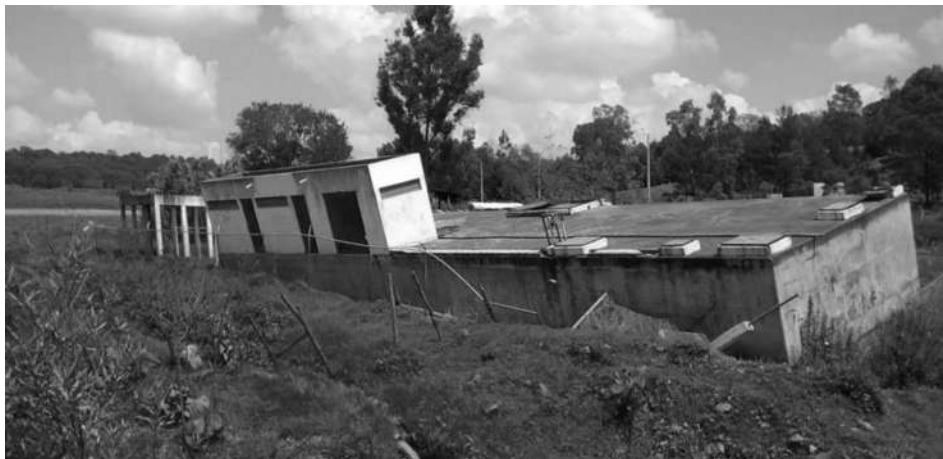
Figura 6. Planta de tratamiento de Jesús del Monte
