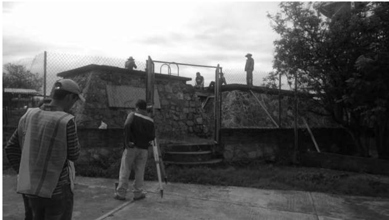
Figura 11. Tanques de almacenamiento
