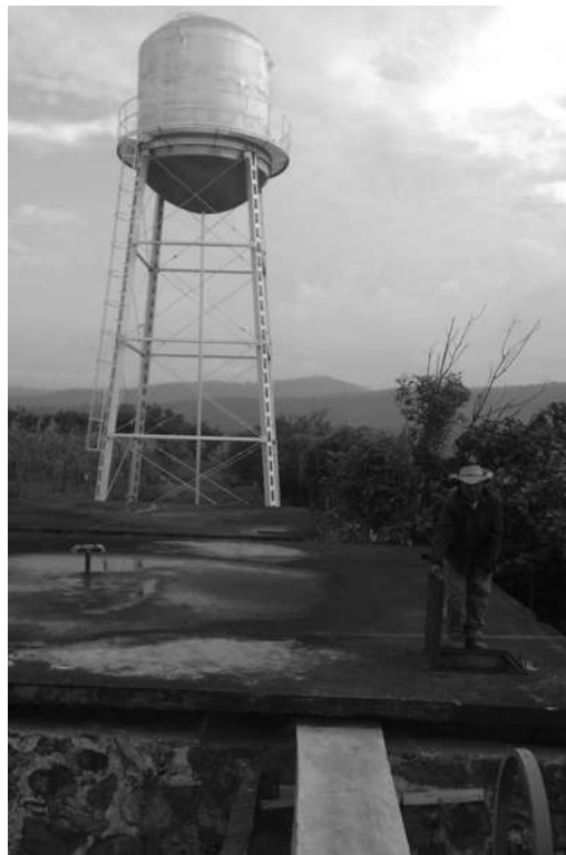
Figura 12. Tanque elevado en construcción
