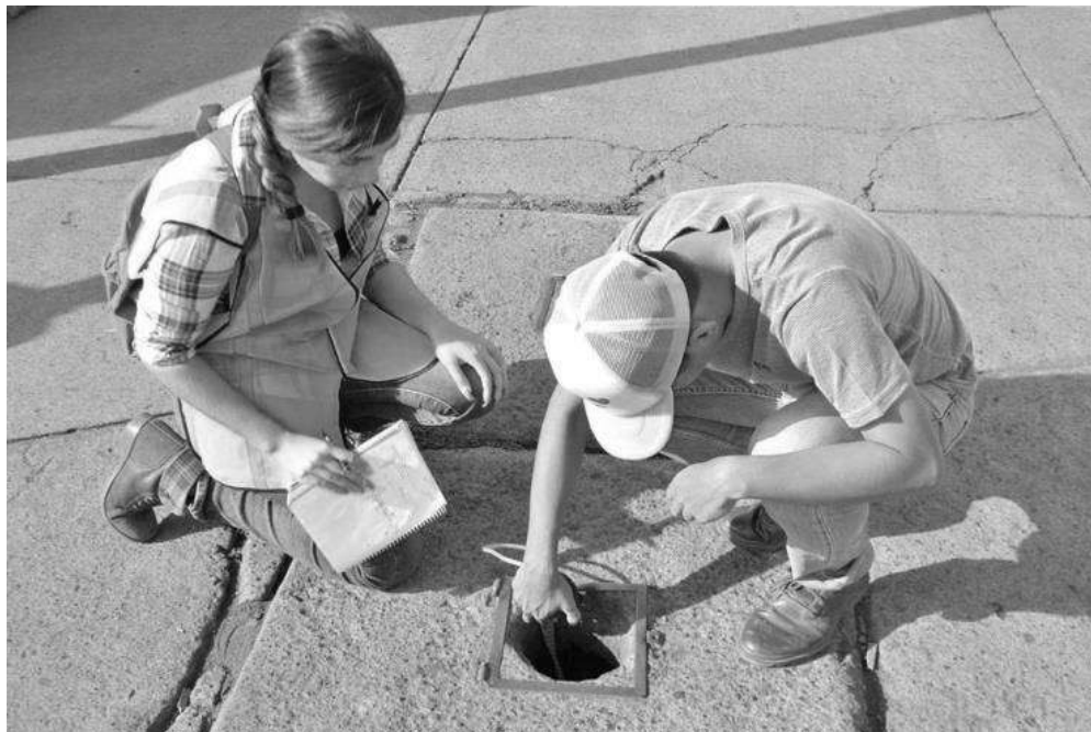
Figura 16. Levantamiento de válvulas e identificación de diámetros
