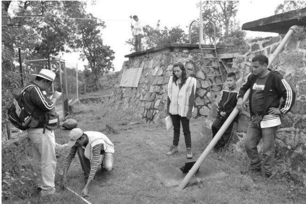
Figura 15. Levantamiento topográfico de los tanques de almacenamiento
