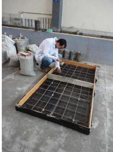
**Figura 3. 52.** Colocación de malla electrosoldada. (V. H. Blancas Herrera, 2017).
