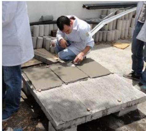
**Figura 3. 54.** Colocación de capa de mortero (V. H. Blancas Herrera, 2017).
