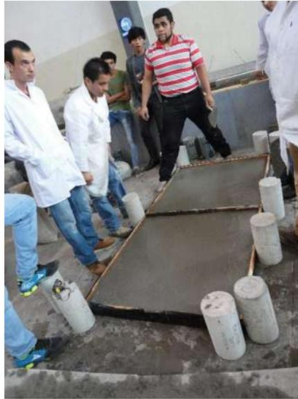
**Figura 3. 53.** Vaciado y enrazado del concreto (V. H. Blancas Herrera, 2017).
