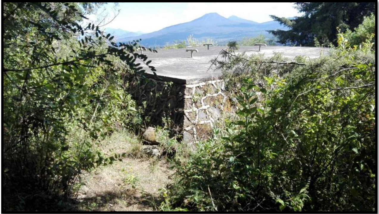
Figura 4.17. Tanque de mampostería con capacidad de 200m 3
