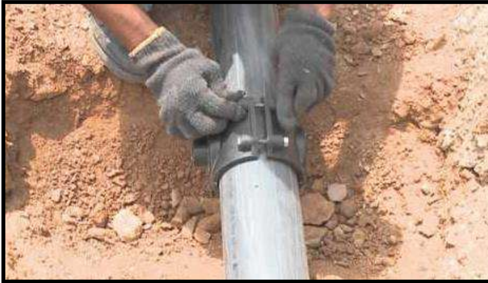
Figura 4.23 instalación de tubería.
