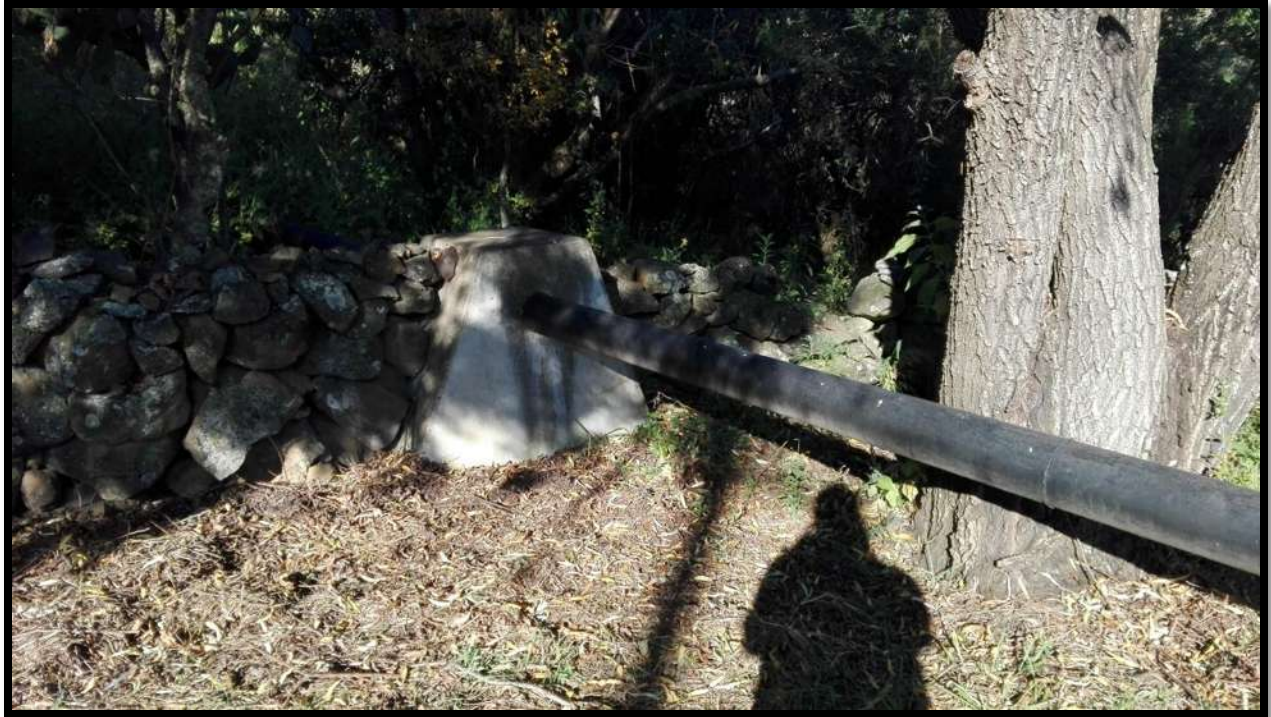
Figura 4.15. Tubo de fierro fundido (Fo. Fo.) de 6 pulgadas.
