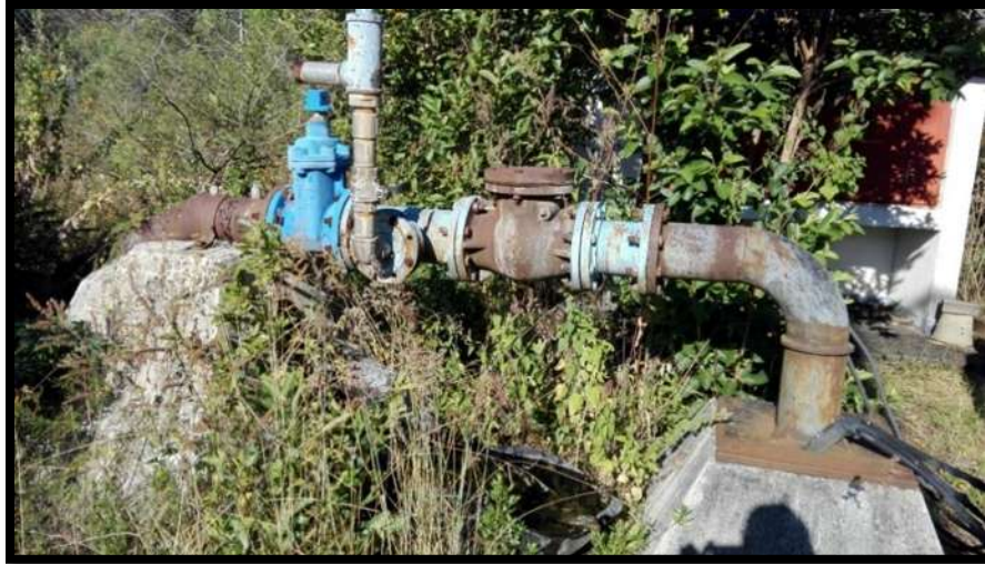
Figura 4.6.- Tren de descarga del pozo.
