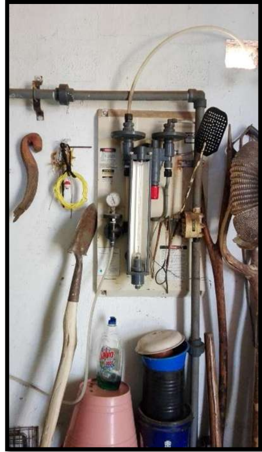
Figura 4.4 y 4.5. Equipos utilizados para la cloración del agua.
