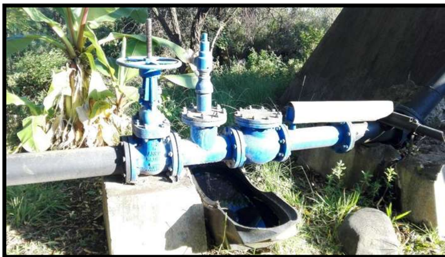
Figura 4.7 Tren de descarga para el rebombeo.
