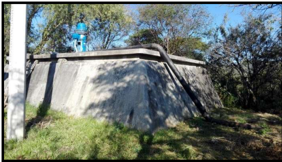
Figura 4.16. Tanque superficial de concreto armado con capacidad de 120 m 3
