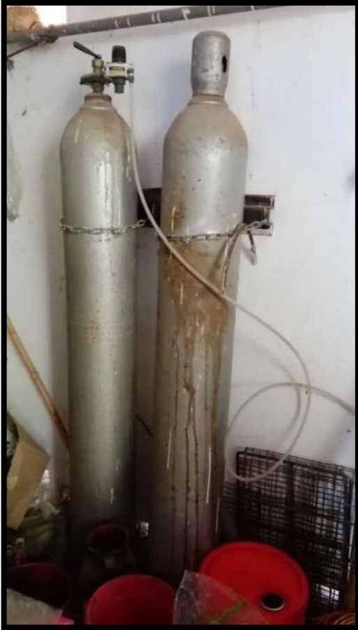
Figura 4.4 y 4.5. Equipos utilizados para la cloración del agua.
