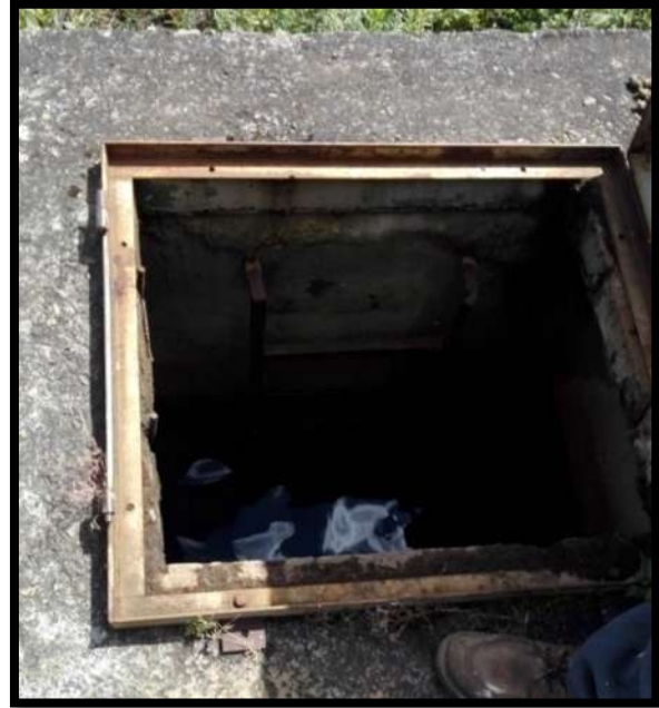
Figura 4.19 y 4.20. Entrada de agua al tanque y compuerta para inspección.
