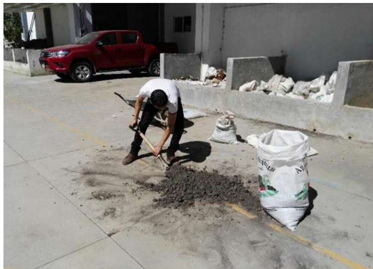
Fig. 9 Eliminación de materia vegetal
