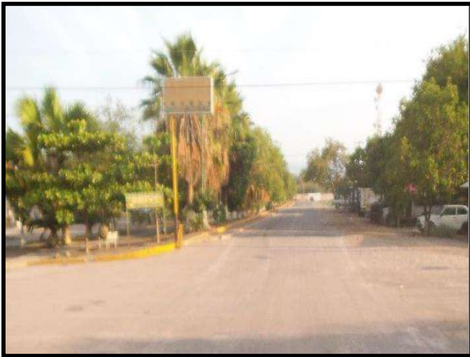
Perdida de agregado fino. KM 1+800
