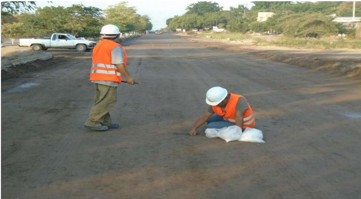
Verificación de espesor de capa de base hidráulica.
