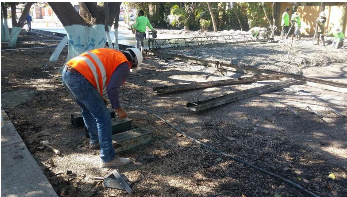
Toma de muestras de concreto para la verificación de su resistencia.
