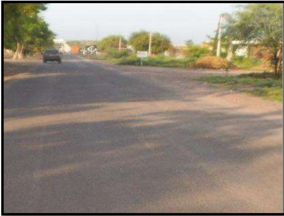
Agrietamiento ligero de mapa. VISTA ATRÁS KM 2+30 Agrietamiento ligero de mapa, pérdida de agregado fino KM 2+800.
