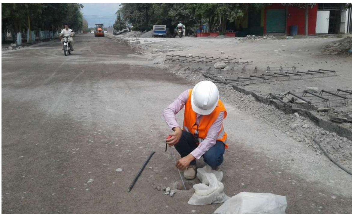
Verificando espesores capa de base hidráulica.
