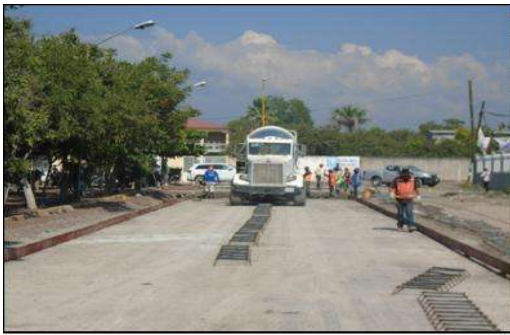
INICIO DE COLADO DE CONCRETO
