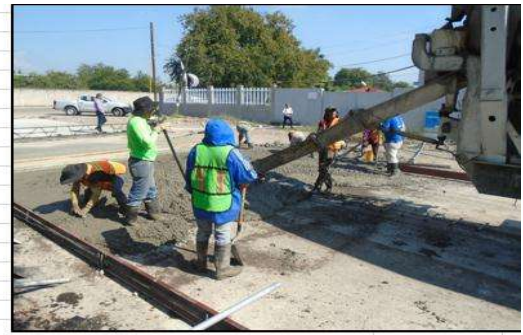
SUMINISTRO Y EXTENDIDO DEL CONCRETO
