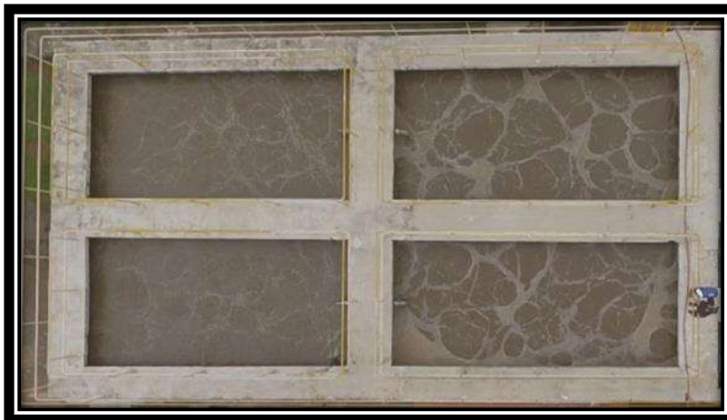
Ilustración 40. Reactor biológico visto desde planta (EAST)
