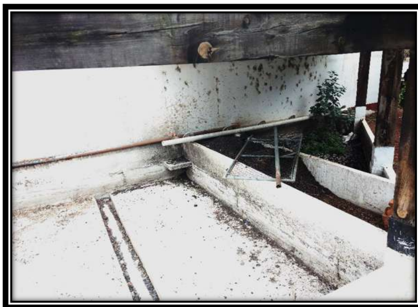
Ilustración 42. Estado actual de los lechos de secado (EAST)
