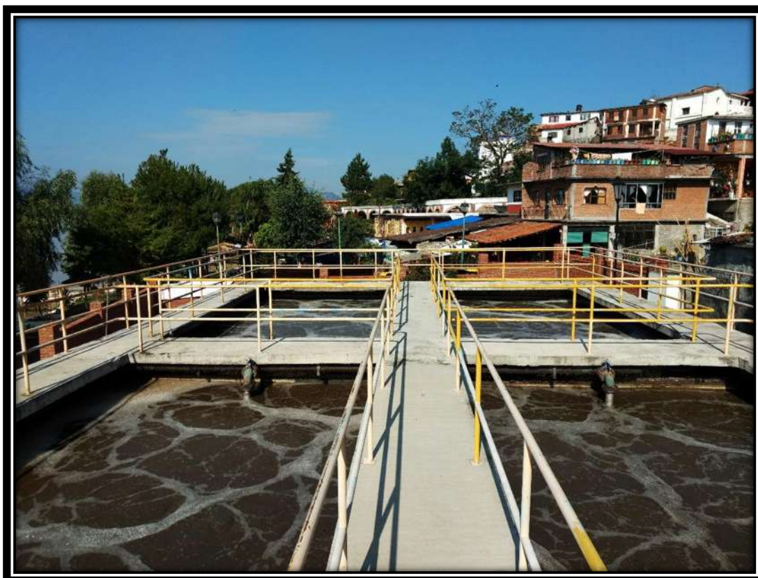
Ilustración 22. Planta de Tratamiento de Aguas Residuales de la isla de Janitzio, proceso de lodos activados (EAST)
