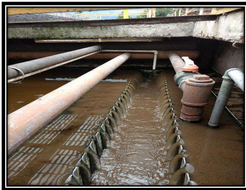
Ilustración 47. Vertedor donde se le agrega la dosis de cloro al efluente
