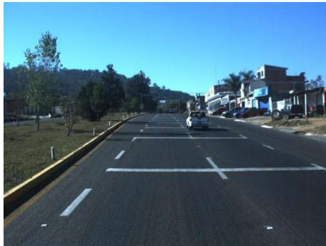
Ilustración 43 Rayas con espaciamiento logarítmico sin botones.
