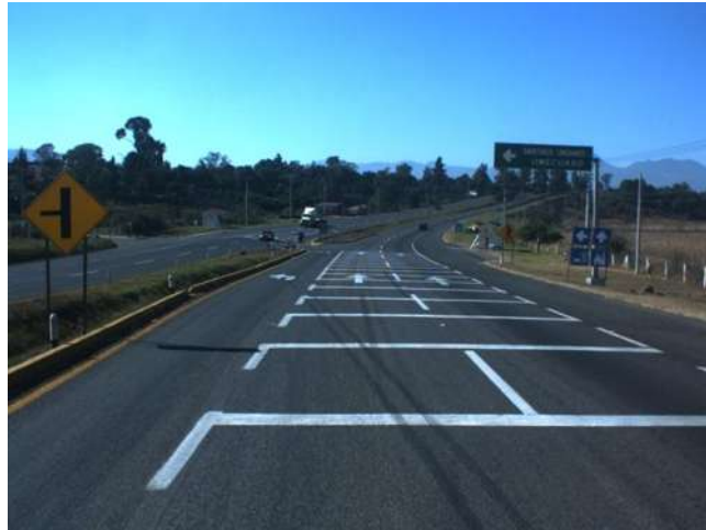
Ilustración 38 Rayas con espaciamiento logarítmico en el tramo (sentido 1)
