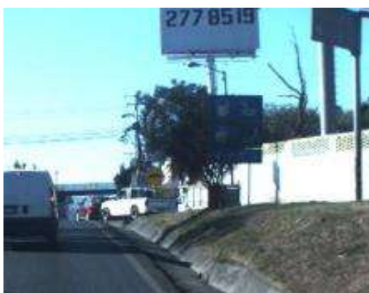
Ilustración 35 Señalamiento en mal estado
