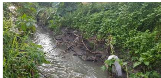
Figura 37. Rivera del dren Arroyo de Tierras
