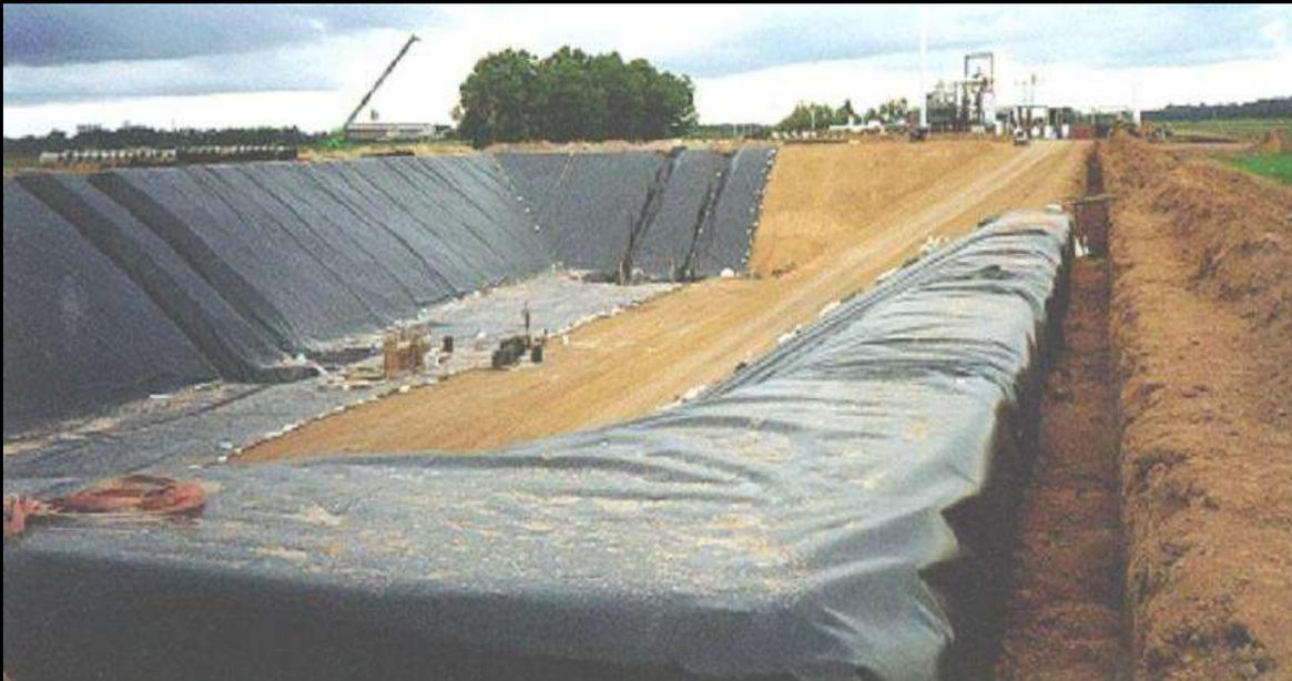
Figura 42. Relleno Sanitario Según el Método de Trinchera.
