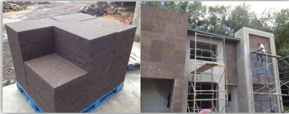
Figura 2.12. Material “laminado” después de proceso de corte y colocado en obra arquitectónica, Fotografía: J.C. García Perdomo, 2018.
