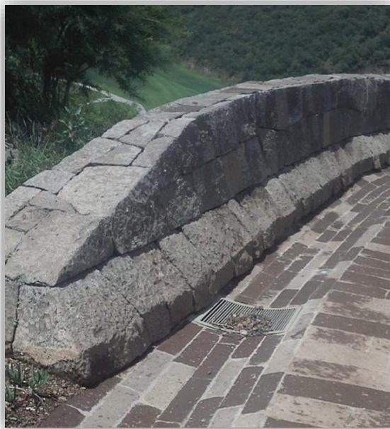
Figura 2.9. Muro de contención en función estructural y arquitectónico (J.C. García Perdomo, 2018).
