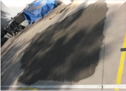
Ilustración 19. Extensión de arena para su secado.
