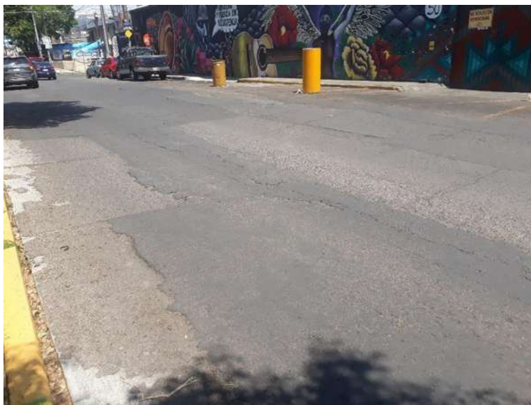
Figura 6.20 Avenida Solidaridad, metros antes del cruce con la calle Virrey de Mendoza.
