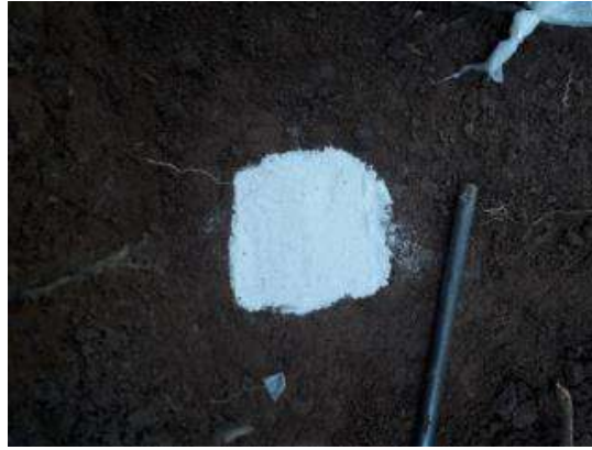
Figura 5.33 Llenado de la excavación con marmolina.
