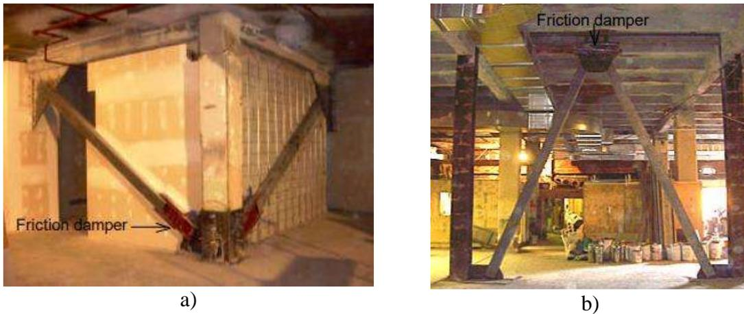
Figura 1.9 a) Amortiguador colocado en un contraventeo chevrón b) Amortiguador colocado en una diagonal simple (Pasquin et al. 2004)
