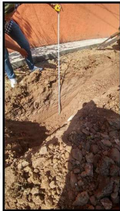
Ilustración 18 No se detectó nivel freático
