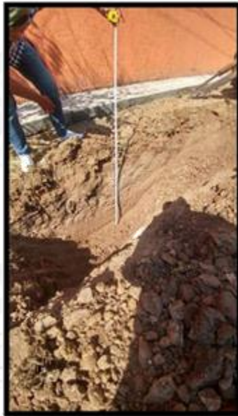
Foto 3.- Toma de estratigrafía en el pozo a cielo abierto.
