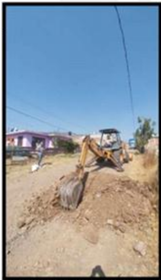
Foto 5.- Elaboración y ubicación del pozo a cielo abierto No. 2
