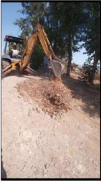
Foto 8.- Elaboración y ubicación del pozo a cielo abierto No. 3
