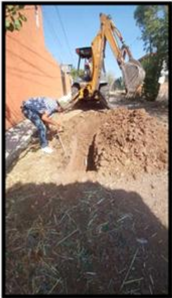
Foto 2.- Elaboración y ubicación del pozo a cielo abierto No. 1
