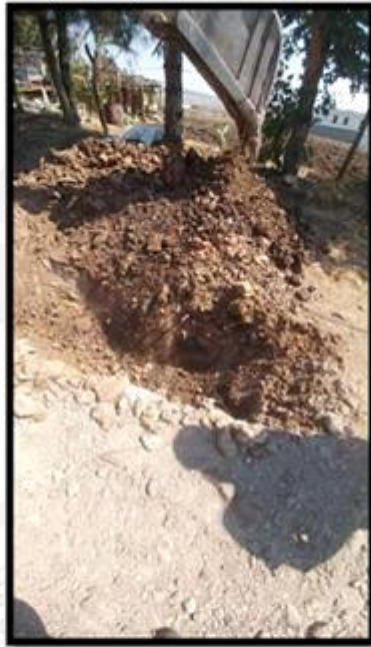
Foto 9.- Toma de estratigrafía en el pozo a cielo abierto.
