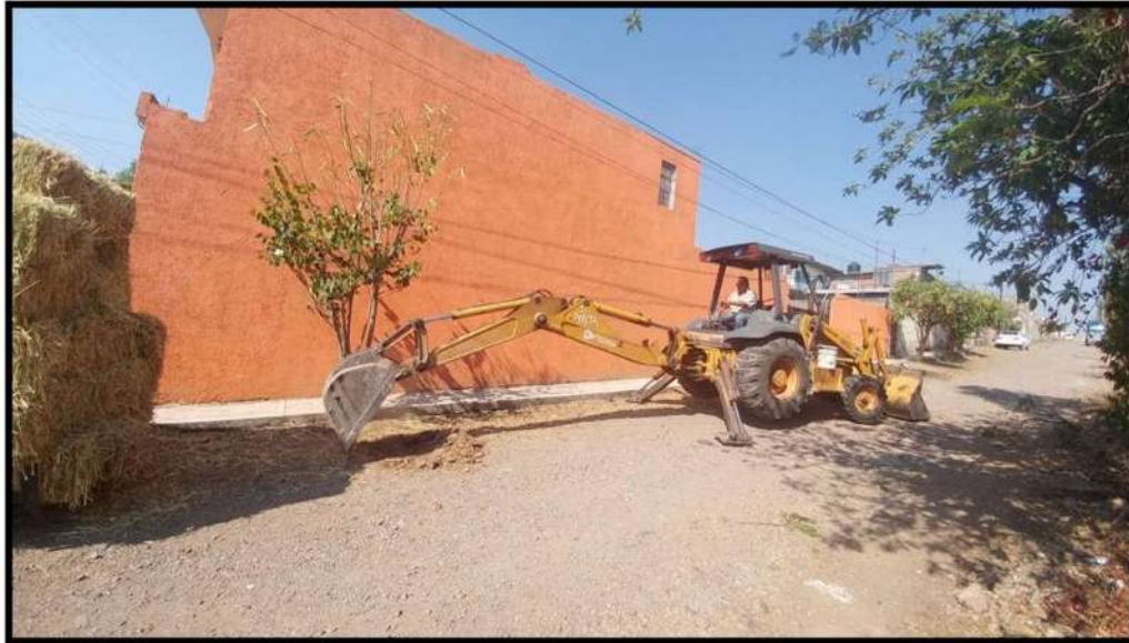
Ilustración 17 Perforación se llevó a cabo mediante la ayuda de una máquina retroexcavadora
