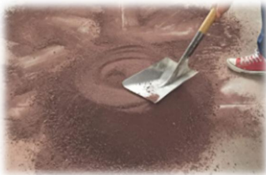
Figura 23.- Aplanado de la parte superior del montículo de arena, por medio de la pala. (Contreras, 2019)
