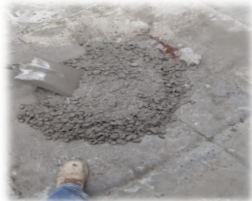
Figura 84.- Concreto fresco con la consistencia deseada (Contreras, 2019)
