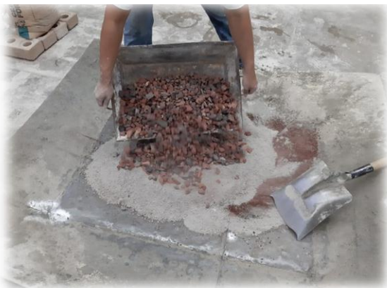
Figura 83.- Cemento y agregado fino combinados para posteriormente adicionar el agregado grueso. (Contreras, 2019)
