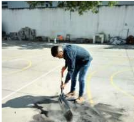
Ilustración 9. Colocación del agregado en una superficie limpia (Fotografía Antonio M).
