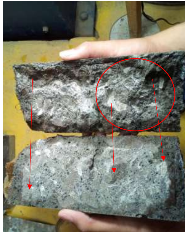
Ilustración 43. Desprendimiento de la pasta-agregado lo que provoca falla y colapso del espécimen en las mezclas que contienen sílice a temprana edad. (Fuente Antonio M)
