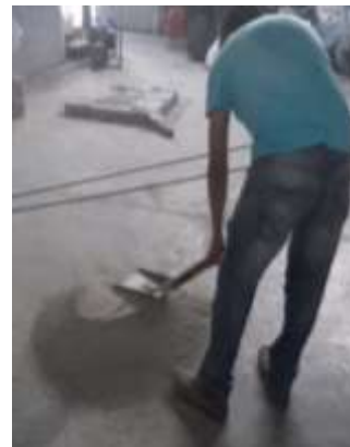
Ilustración 11. Aplanado de la parte superior del material (Fotografía Florentino M).
