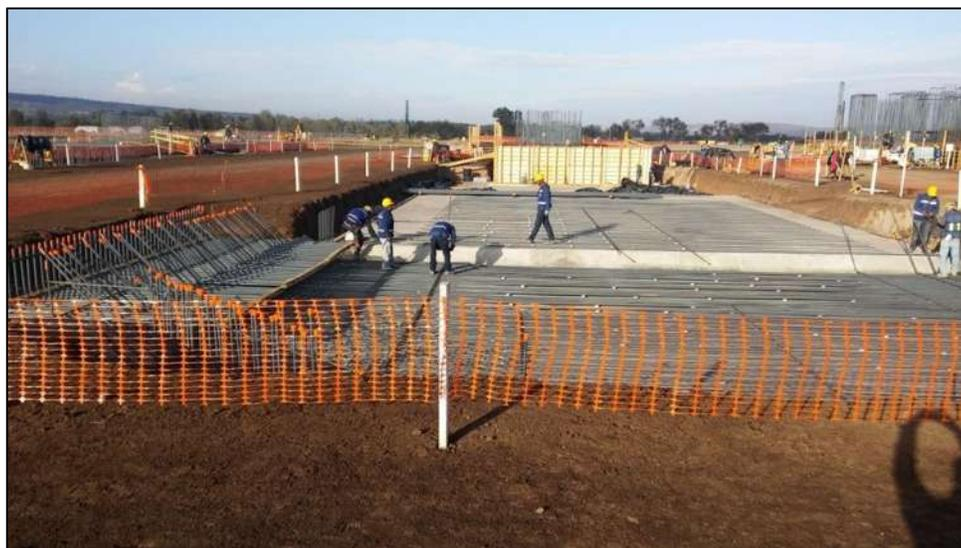
*Figura 9. Armado de lecho inferior de losa*
