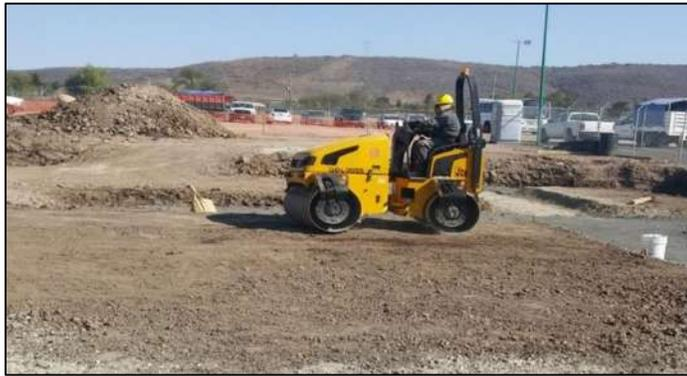
*Figura 3. Compactación del terreno con vibrocompactador*
