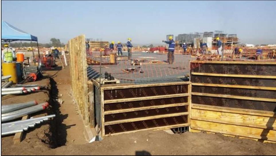
*Figura 12 Cimbrado perimetral y colocación de anclajes embebidos*
