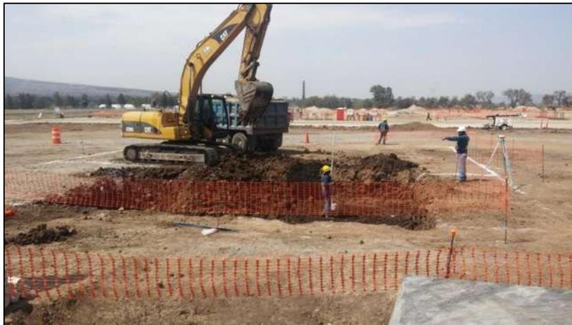
*Figura 2. Excavación con excavadora*
