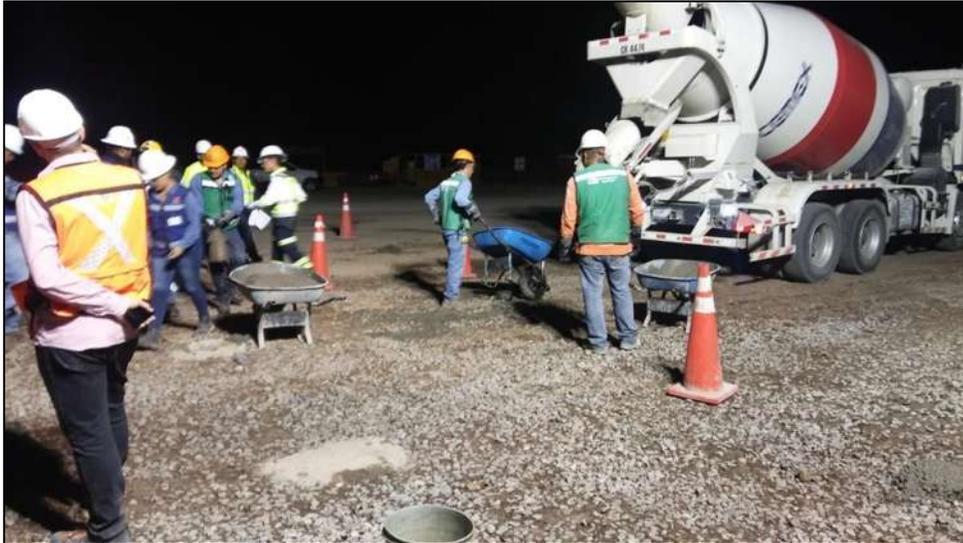
*Figura 13. Recepción de concreto por laboratorio en sitio*
