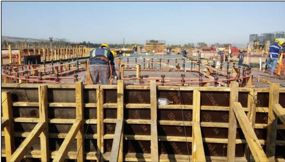
*Figura 7. Colocación de anclajes para recibir equipo de mucha altura*
