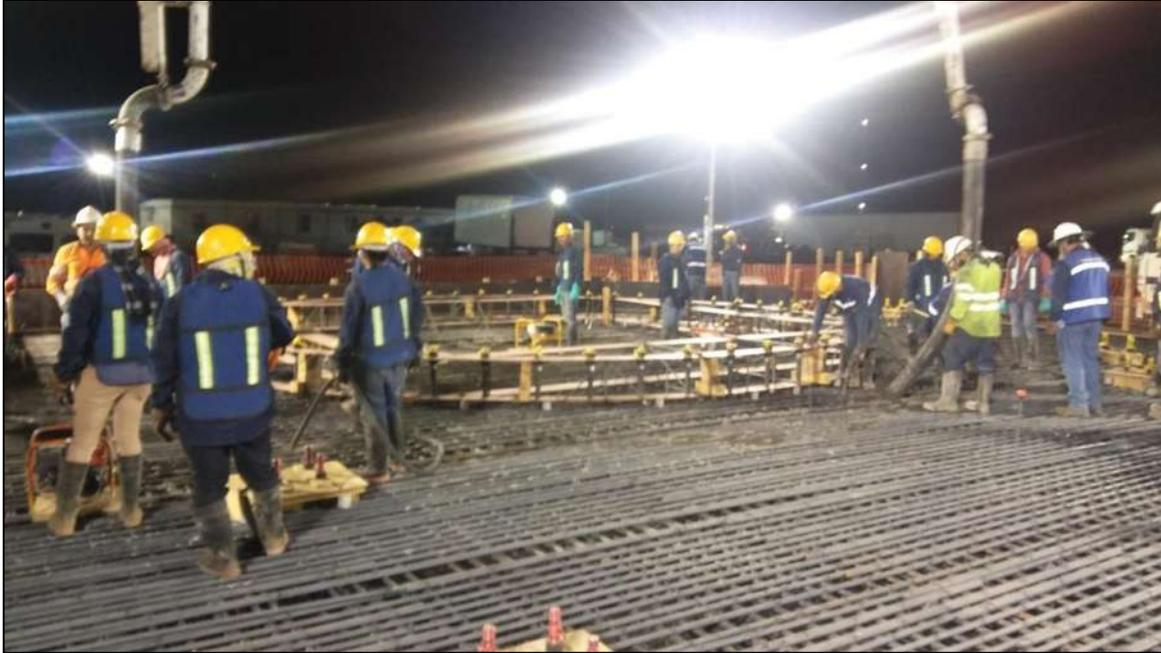
*Figura 15.- un grupo de personas capacitadas para vaciar el concreto en capas de 40 cms por cada bomba*
