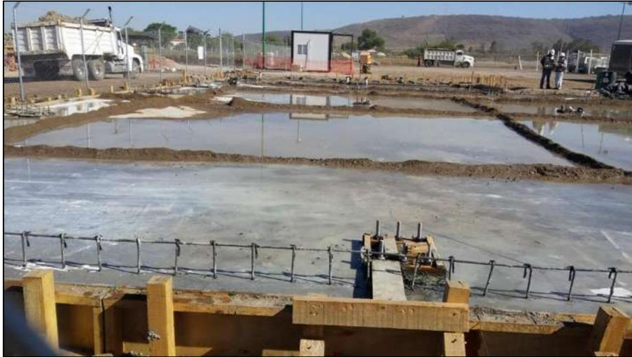
*Figura 17. Curado por inundación de la superficie usando barreras de retención de arena*
