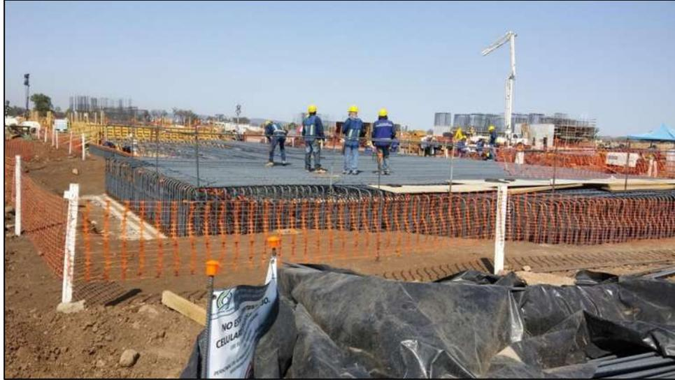
*Figura 10. Armado de lecho superior de losa*
