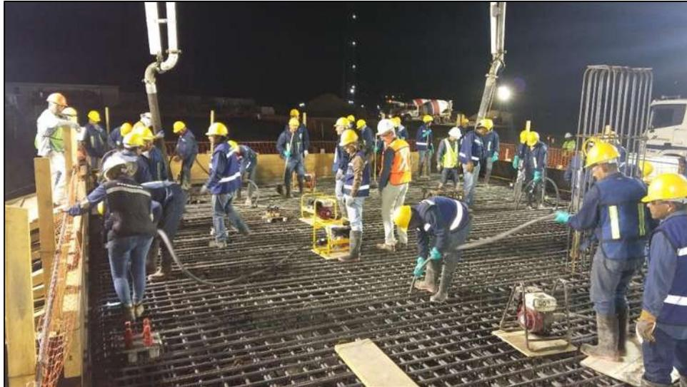
*Figura 16. Concreto compactado con vibradores de 1 1/2" de diámetro*
