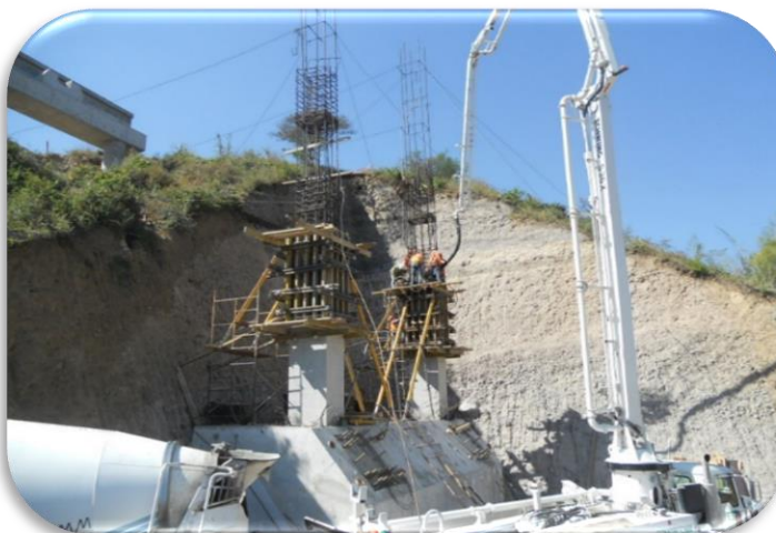
Imagen 24 Colado de columnas.
