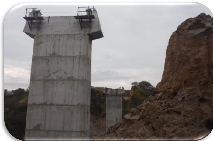
Imagen 39 Cabezales de pilas.
