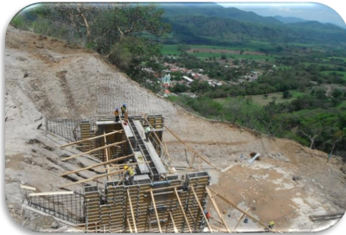
Imagen 21 Colado de estribos.
