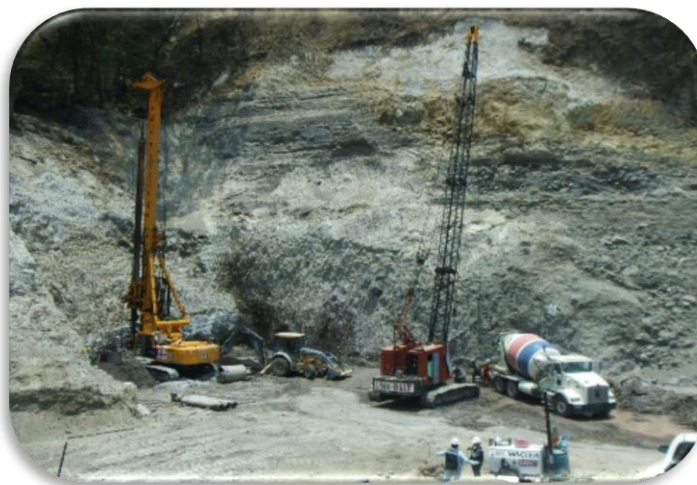
Imagen 3 Perforación para pilotes o pilastrones.
