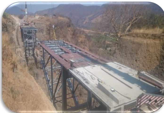
Imagen 30 Montaje de traves dovela D-4.
