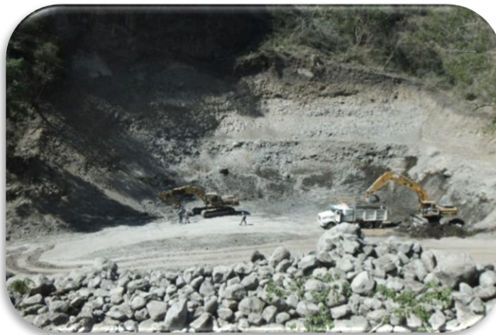
Imagen 2 Excavación para desplante de cimentación.
