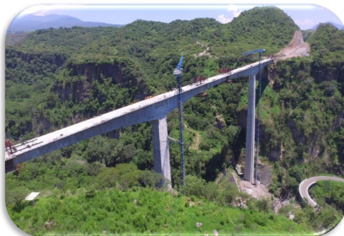
Imagen 16 Vista del doble volado terminado.
