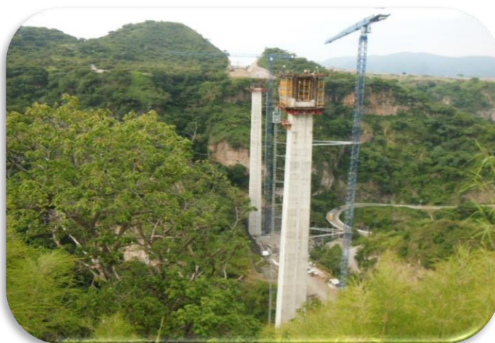
Imagen 11 Cimbra y colado de dovela sobre pila (DSP).
