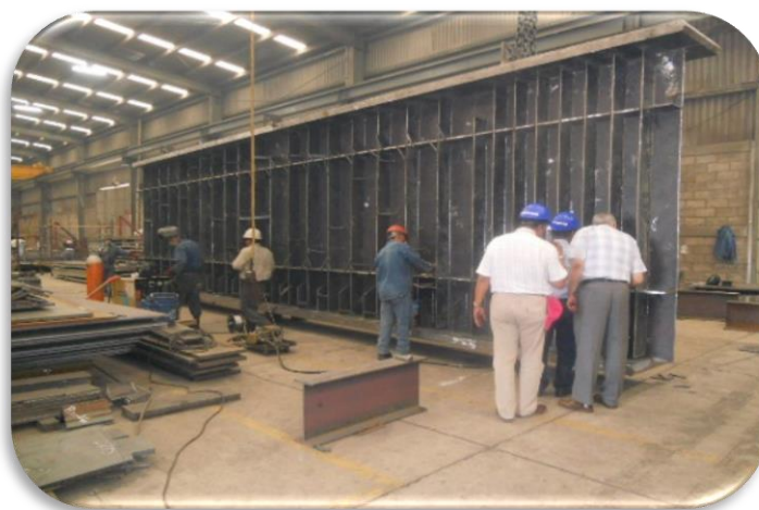
Imagen 41 Fabricación de la estructura metálica.
