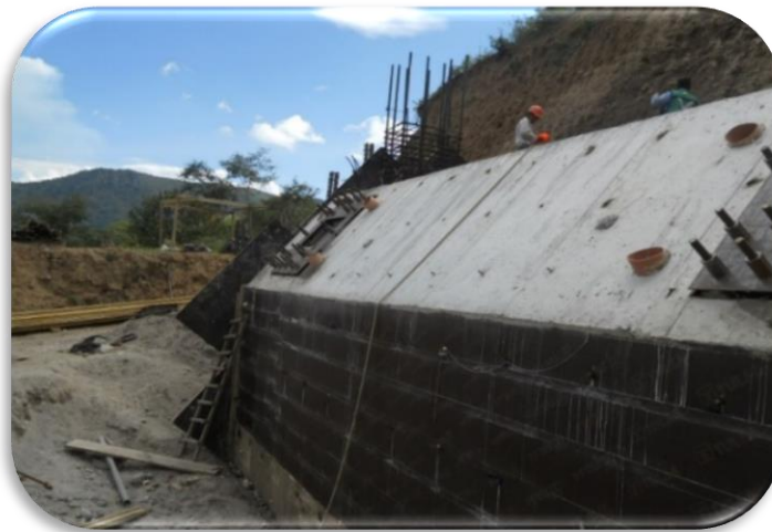
Imagen 23 Zapatas de pilas con anclas tensadas.
