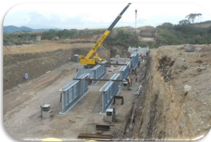
Imagen 42 Armado de nariz y dovelas D-1, D-2 y D-3.
