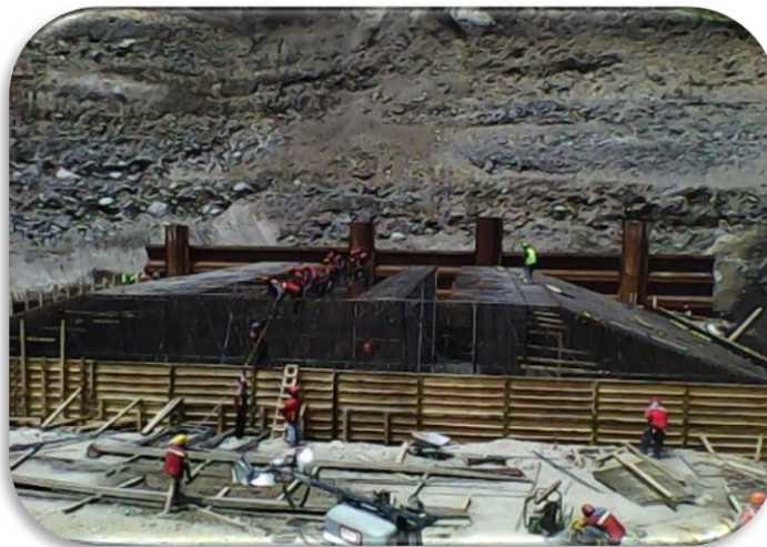
Imagen 6 Cimbra en zapata.
