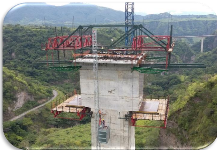
Imagen 12 Armado de carros de colados.
