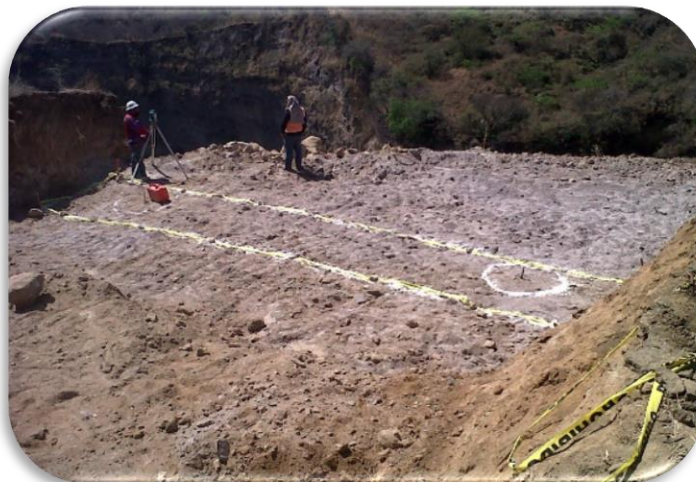
Imagen 19 Trazo para pilotes de cimentación.
