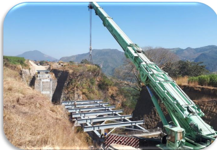
Imagen 28 Montaje de traveses dovelas D-1 y D-2
