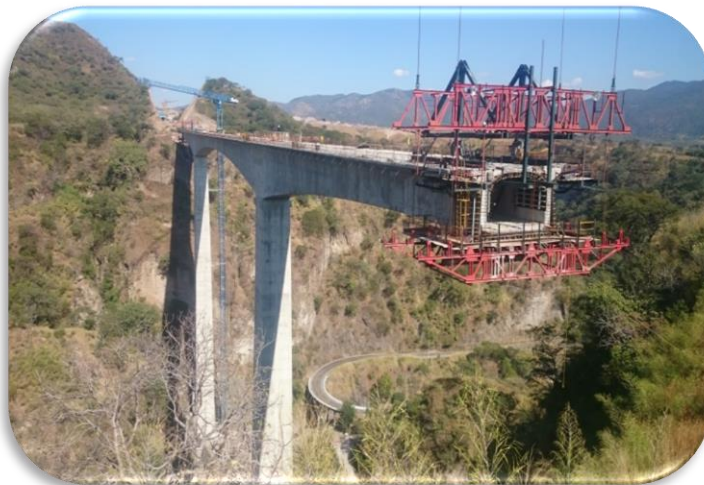
Imagen 15 Evolución de colados en doble volado.
