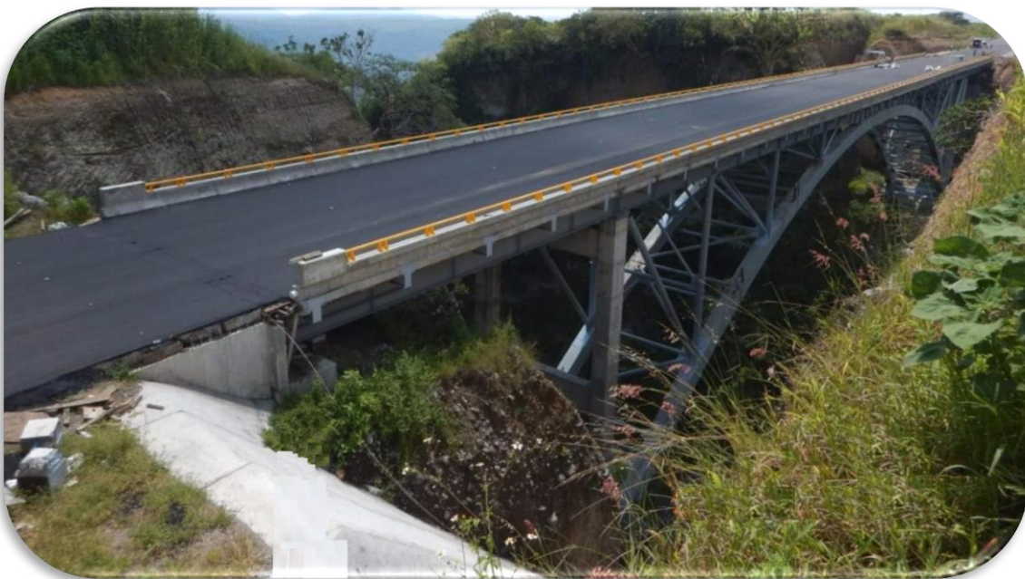
Imagen 34 Panorámica “Puente Platanar II”.
