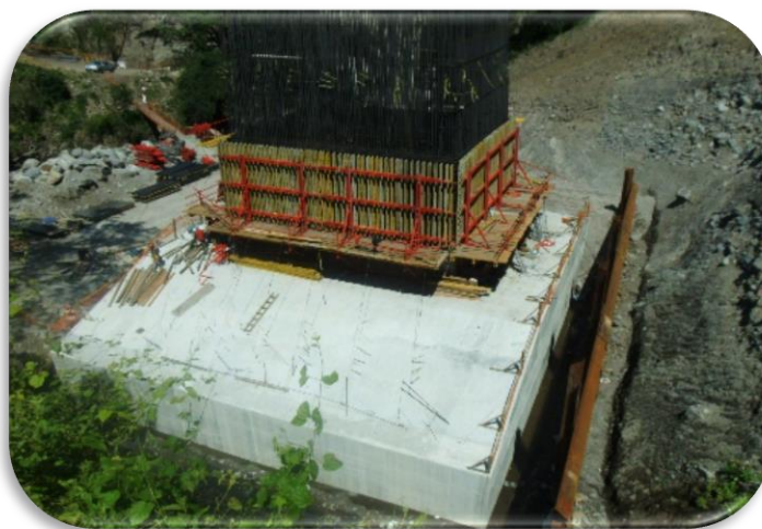
Imagen 8 Cimbra deslizante en columna de pila.
