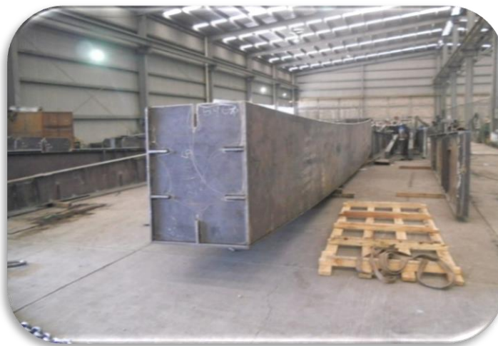
Imagen 26 Fabricación estructura metálica.
