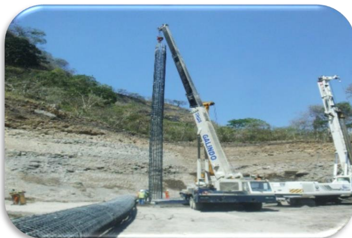
Imagen 4 Acero para pilas de cimentación.
