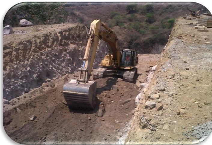
Imagen 18 Excavación para desplante de cimentación.
