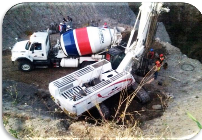
Imagen 20 Colado de pilotes.
