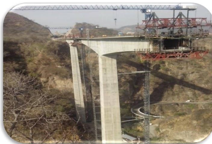
Imagen 14 Colado de dovelas en doble volado.
