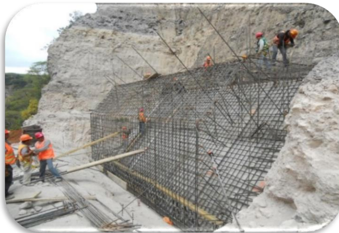
Imagen 22 Acero de refuerzo en zapata de pila.
