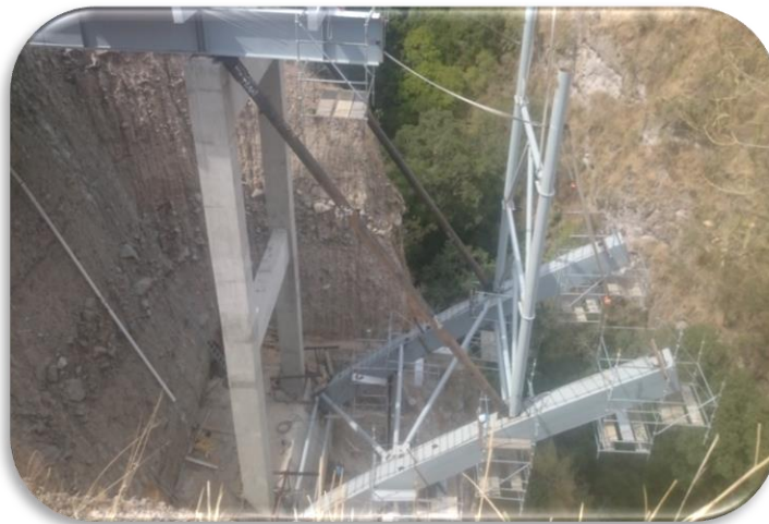
Imagen 29 Montaje de columna en dovela DA-2.
