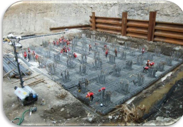
Imagen 5 Acero de refuerzo en zapata.
