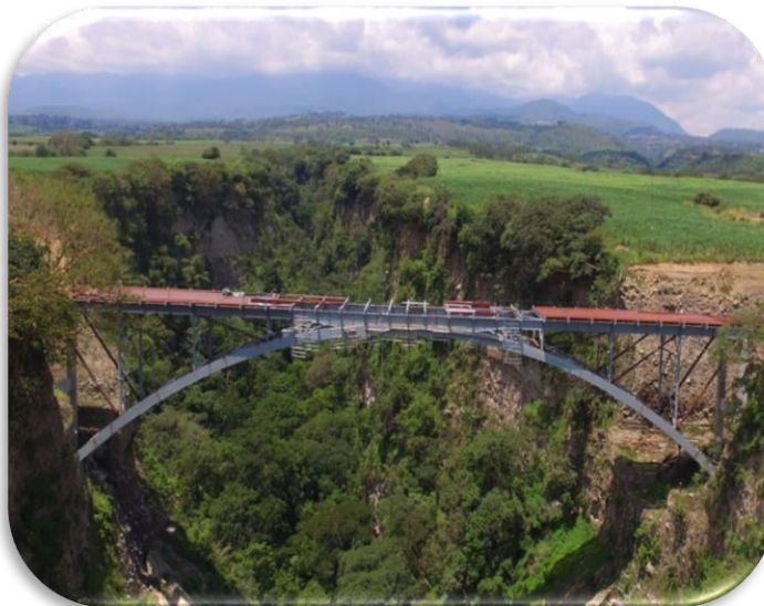
Imagen 33 Cierre de estructura y colocación de montén.
