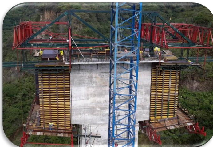
Imagen 13 Colado de dovelas D-1.
