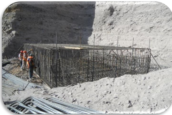
Imagen 36 Acero de refuerzo en zapata.
