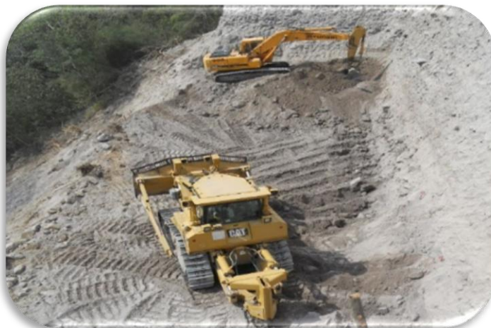
Imagen 35 Excavación para desplante de cimentación.
