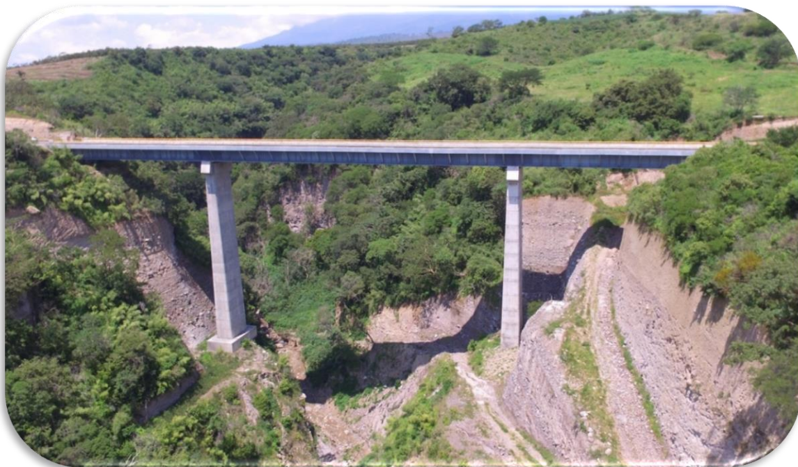
Imagen 48 Panorámica “Puente La Clavelina km 11+620”.
