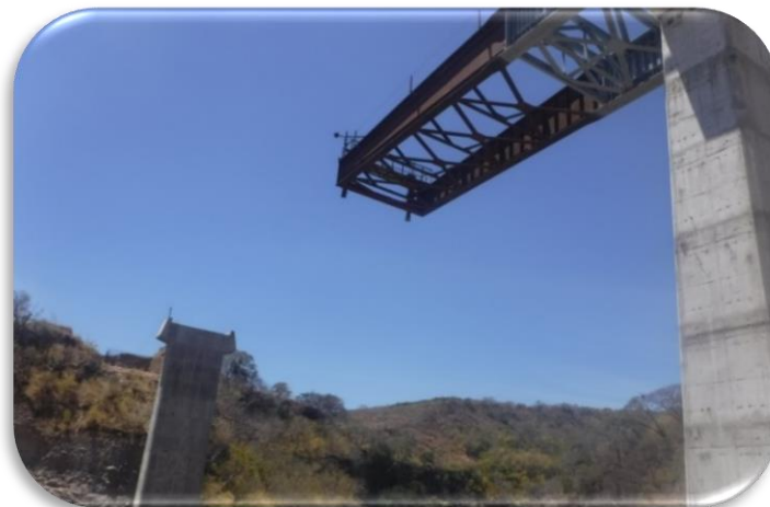
Imagen 44 Estructura sobre Pila N° 2.
