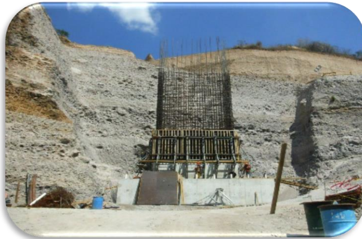
Imagen 37 Cimbra deslizante en columna de pila.
