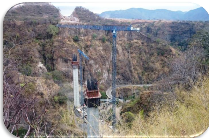
Imagen 9 Colados de columnas de pilas.
