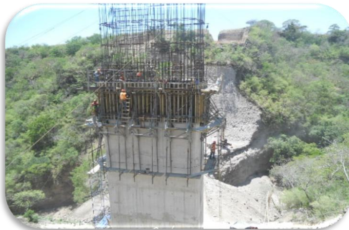
Imagen 38 Colado de columna de pila.
