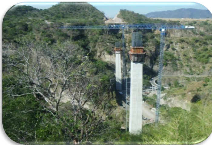
Imagen 10 Evolución de colados en columnas.
