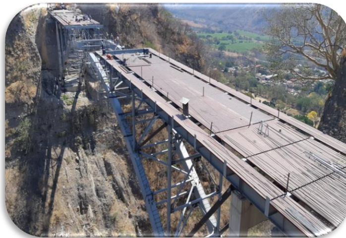
Imagen 31 Montaje de traveses dovela D-5 y montes.
