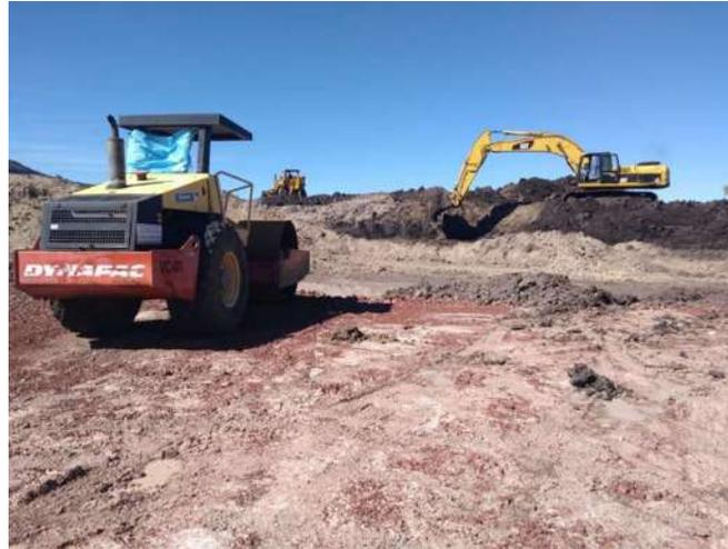
*Fig. 10 Compactación con Vibro compactador de tambor mejorando el terreno natural*
