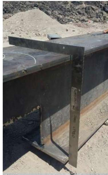
*Fig. 26 Conformación de Vigas proceso de alineación y escuadra de piezas*
