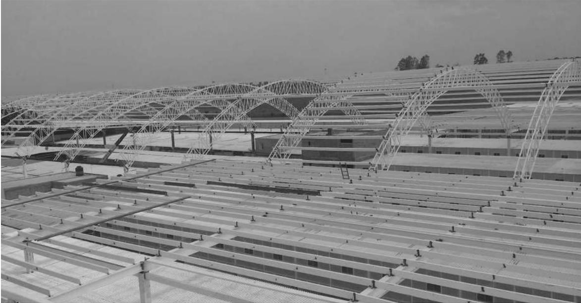
*Fig. 36 Colocación de largueros en vigas principales.*
