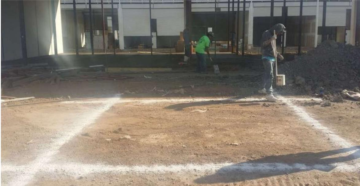
*Fig. 17 Trazo del área de excavación*
