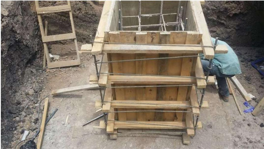
*Fig. 21 Cimbra en dados empleando grapas con varillas.*
