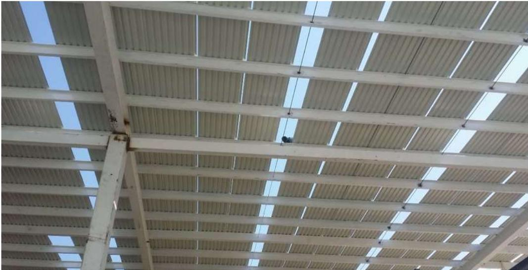
*Fig. 40 Tendido de lámina pinto de 38 metros de longitud*
