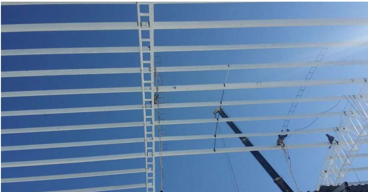
*Fig. 37 Colocación de flambeos en arco*
