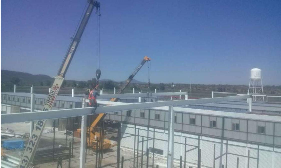
*Fig. 32 Montaje de vigas principales con grúa titán*
