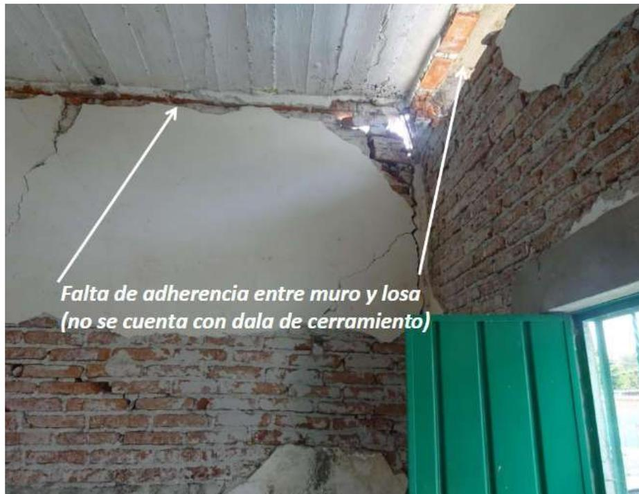
Fig. 1. Deficiencia en el proceso constructivo de losa maciza. Nuñez G. A., Ruiz G. J. (2017)
