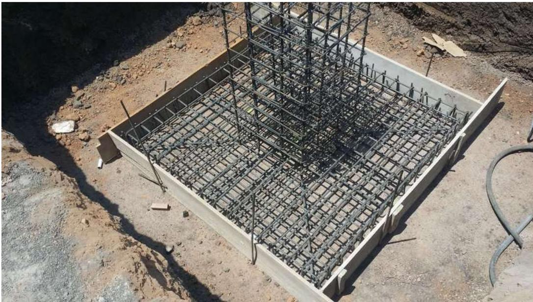
*Fig. 12 Zapata aislada en proceso de armado y cimbrado*
