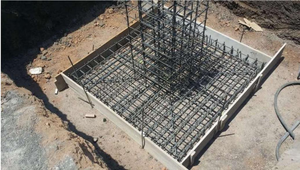
*Fig. 19 Habilitado de acero en zapata aislada y cimbrado de frontera*
