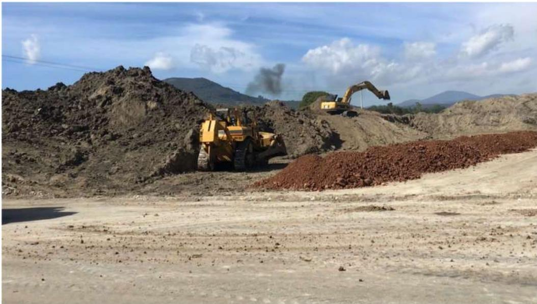
*Fig. 13 Maniobra de desmonte, excavación (Excavadora 330 y Tractor D8R)*
