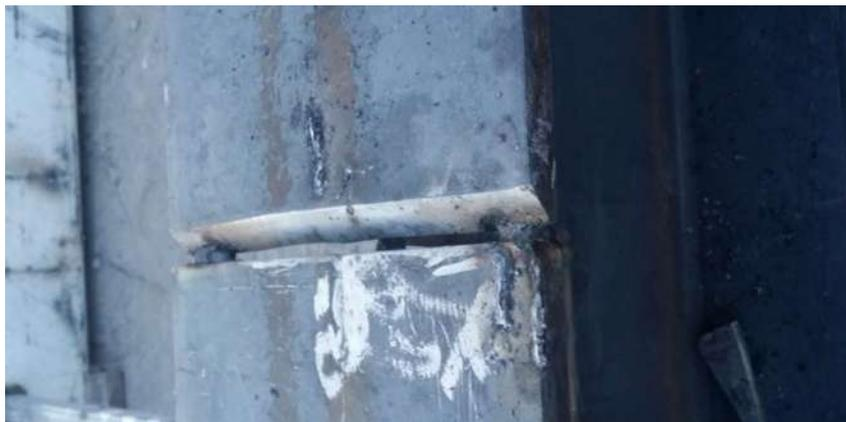
*Fig. 27 Biselado a  $45^\circ$  en empate de vigas.*
