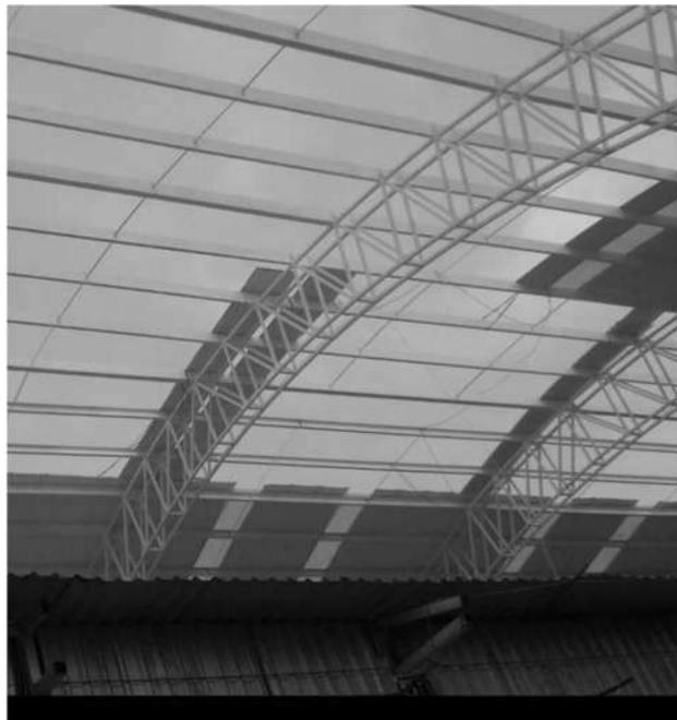
*Fig. 41 Colocación de lámina en el arcotecho.*
