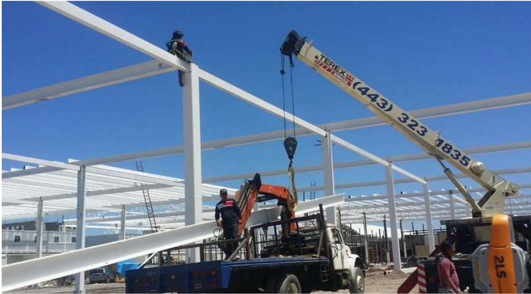
*Fig. 30 Traslado de vigas principales y previa colocación en columnas.*
