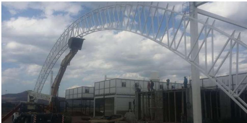
*Fig. 31 Traslado de armadura con excavadora 330 CAT.*
