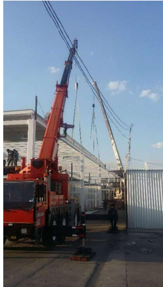
*Fig. 39 Izaje de láminas empleando dos grúas*
