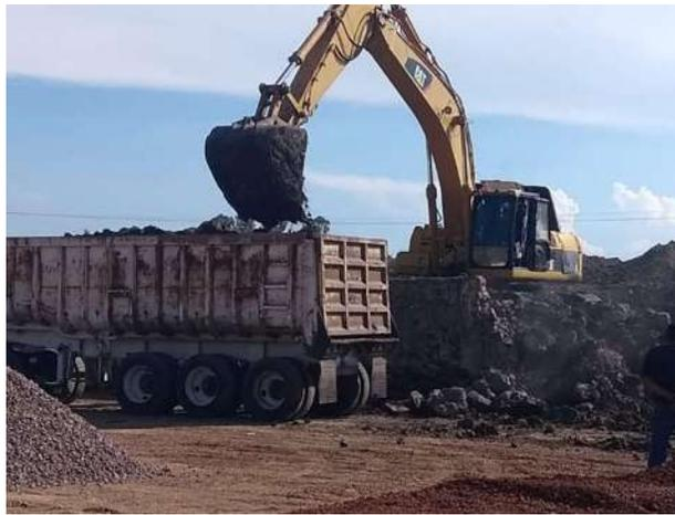
*Fig. 9 Excavación, carga y acarreo con excavadora 330 CAT y góndola.*
