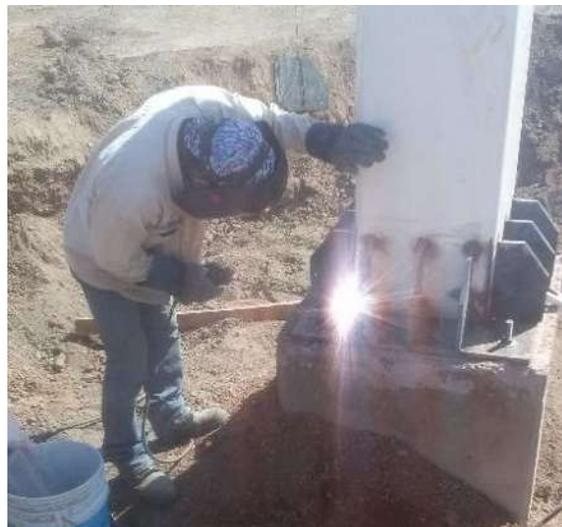
*Fig. 25 Conformación de cartabones en placa base.*
