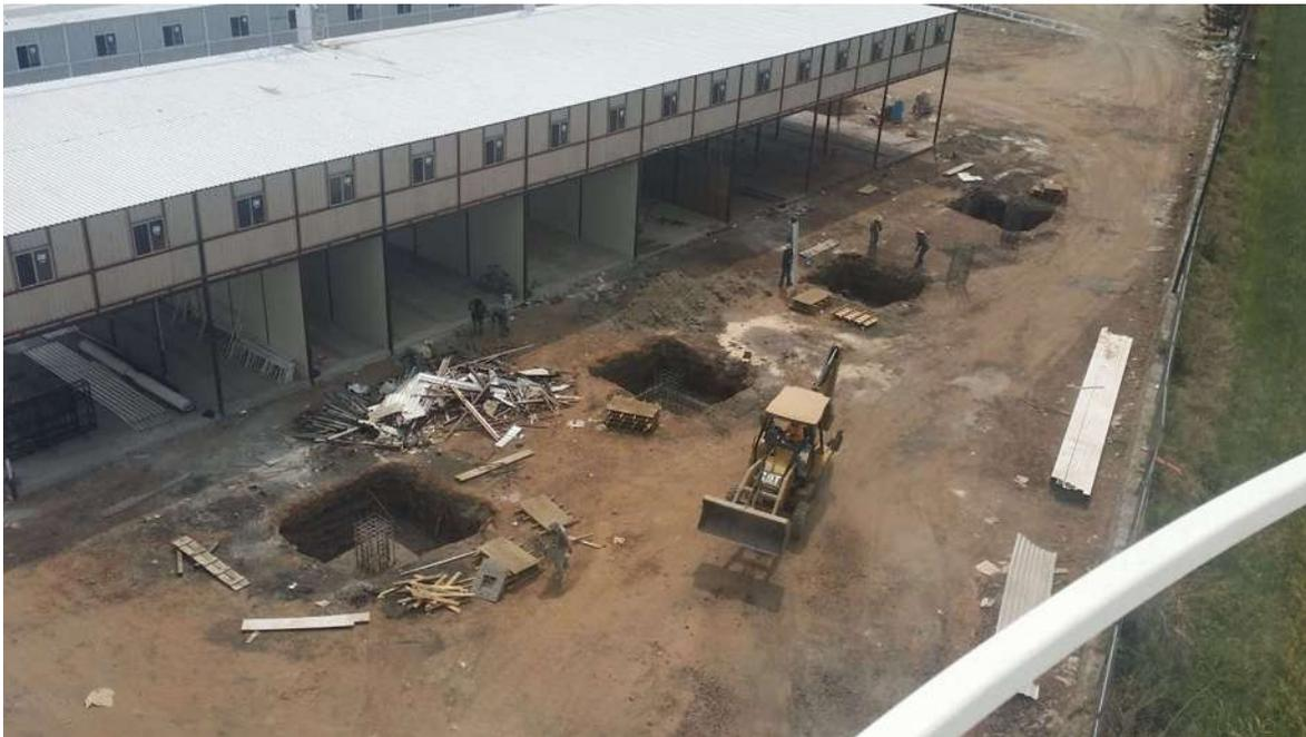
*Fig. 23 Perspectiva general del proceso de 4 zapatas aisladas.*
