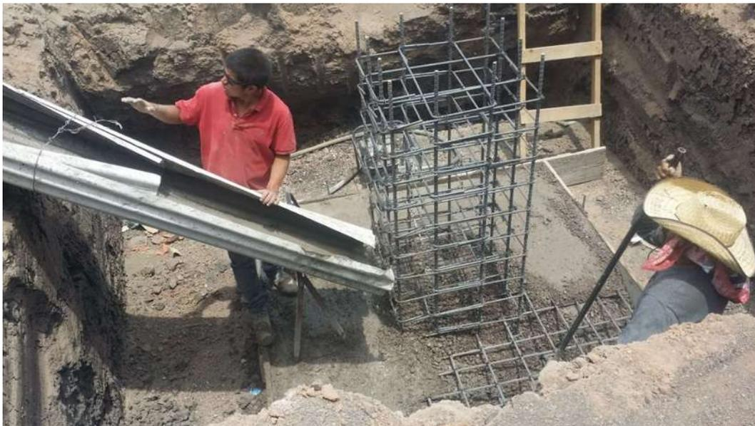
*Fig. 20 Colado de Zapata Aislada con canaleta.*
