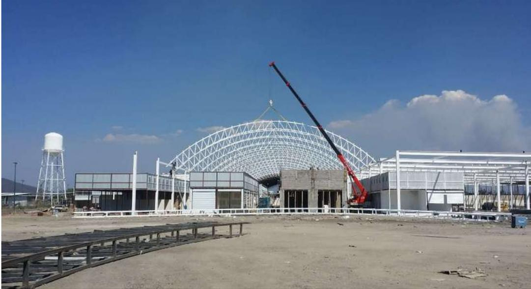
*Fig. 35 Perspectiva Frontal poniente en montaje al 85% del montaje del arco.*
