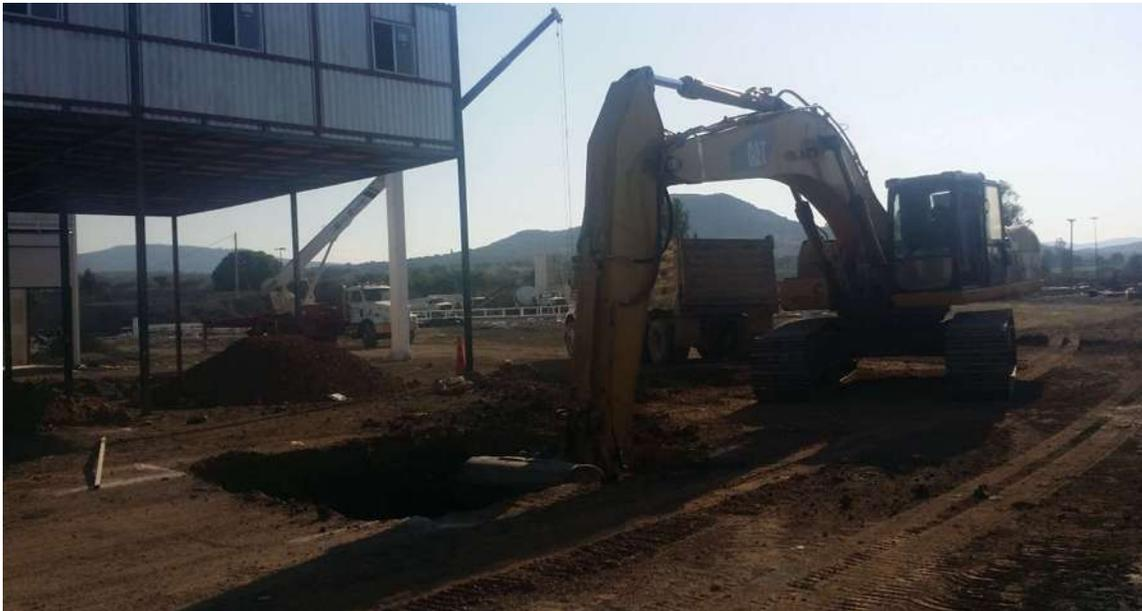
*Fig. 18 Excavación para zapatas aisladas por medios mecánicos.*
