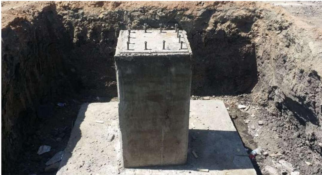
*Fig. 22 Zapata Aislada terminada*
