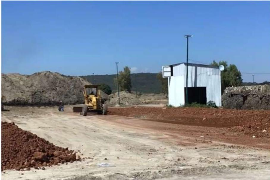
*Fig. 15 Mejoramiento con base, tendido con motoconformadora*
