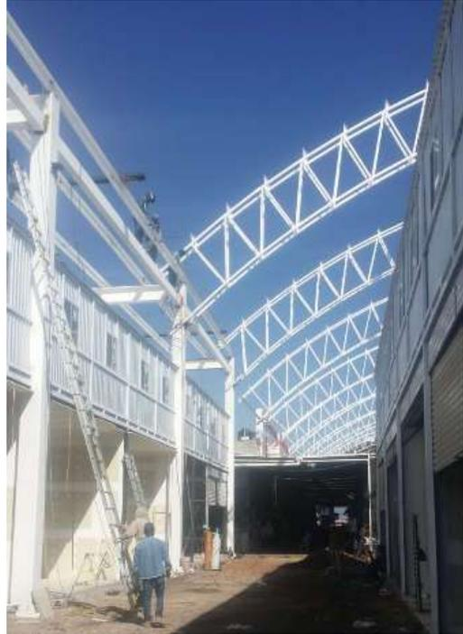
*Fig. 4 Columnas en Nave Industrial*
