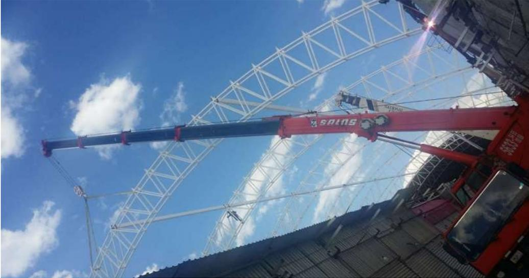
*Fig. 33 Montaje de arco en columnas con grúa Liebherr*
