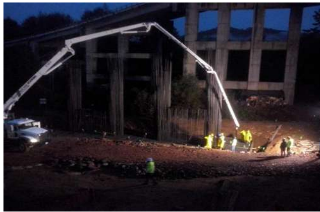
IMAGEN 26. COLADO DE ZAPATA APOYO 4, FUENTE: ALEJANDRO CORTÉS CRUZ
