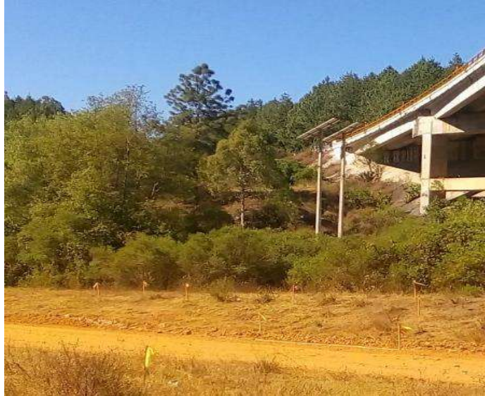
IMAGEN 14. REPLANTEO DE ZAPATAS, FUENTE: ALEJANDRO CORTÉS CRUZ
