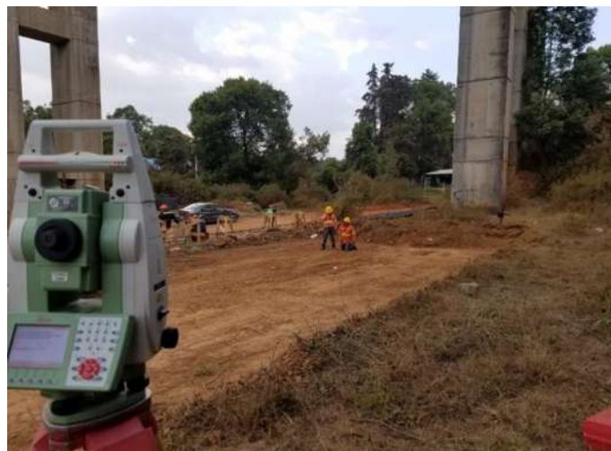
IMAGEN 17. MARCADO DE CENTRO DE PILOTE, FUENTE: ALEJANDRO CORTÉS CRUZ
