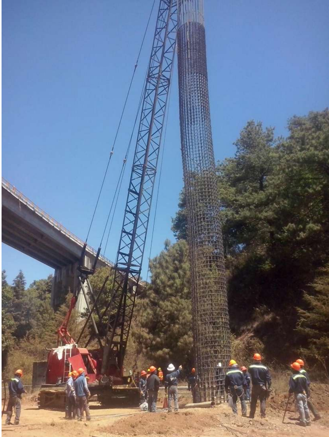
IMAGEN 22. COLOCACIÓN DE ACERO DE REFUERZO EN PILOTES, FUENTE: ALEJANDRO CORTÉS CRUZ
