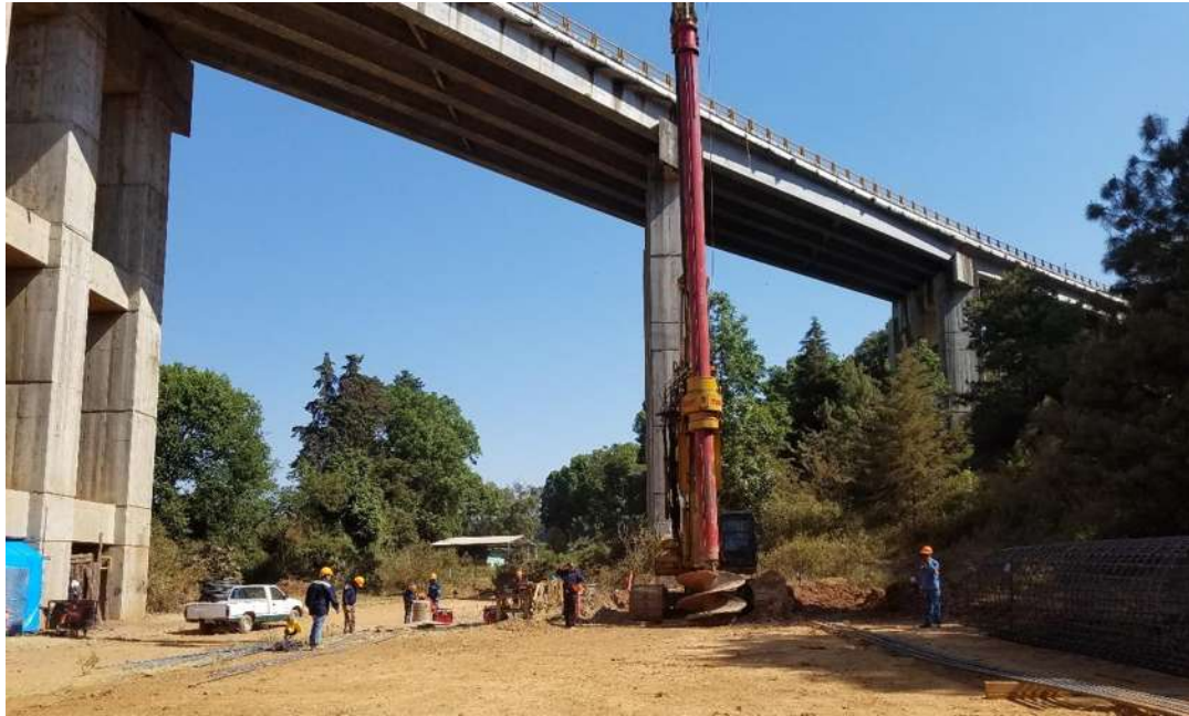
IMAGEN 18. PILOTEADORA PARA EXCAVACIÓN DE PILOTES, FUENTE: ALEJANDRO CORTÉS CRUZ.
