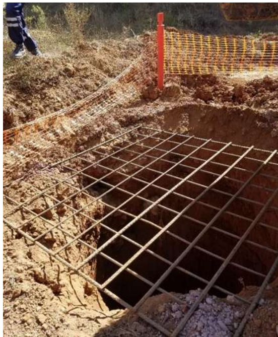
IMAGEN 19. PILOTE EXCAVADO, FUENTE: ALEJANDRO CORTÉS CRUZ.
