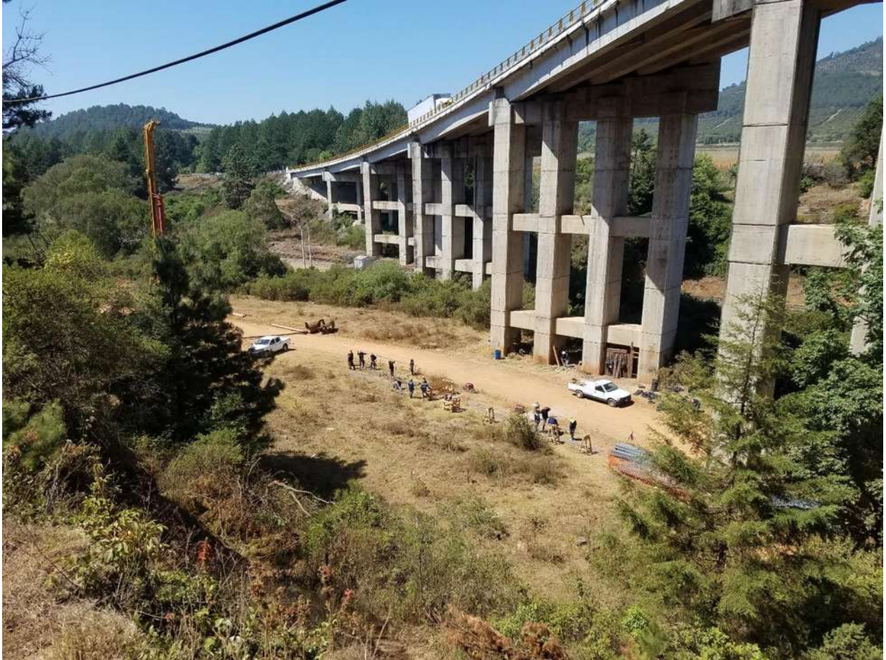
IMAGEN 30. VIADUCTO ZIRAHÚEN EXISTENTE, FUENTE: ALEJANDRO CORTÉS CRUZ
