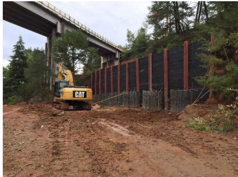
IMAGEN 30. TABLA ESTACADO APOYO 2, FUENTE: ALEJANDRO CORTÉS CRUZ
