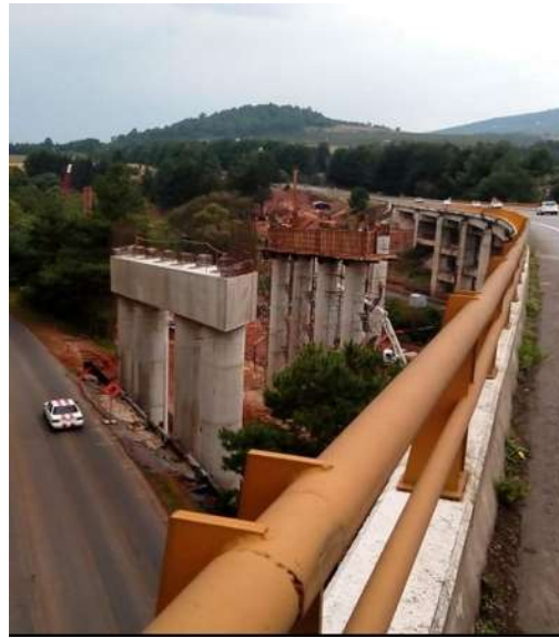
IMAGEN 31. CABEZAL APOYO 2 Y 3. FUENTE: ALEJANDRO CORTÉS CRUZ
