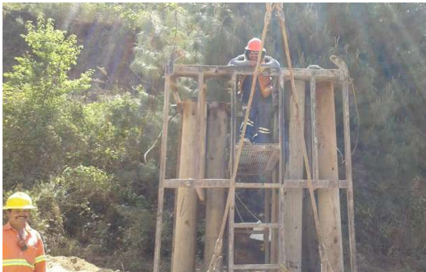
IMAGEN 23. TOLVA DE ACERO PARA COLADO DE PILOTES, FUENTE: ALEJANDRO CORTÉS CRUZ
