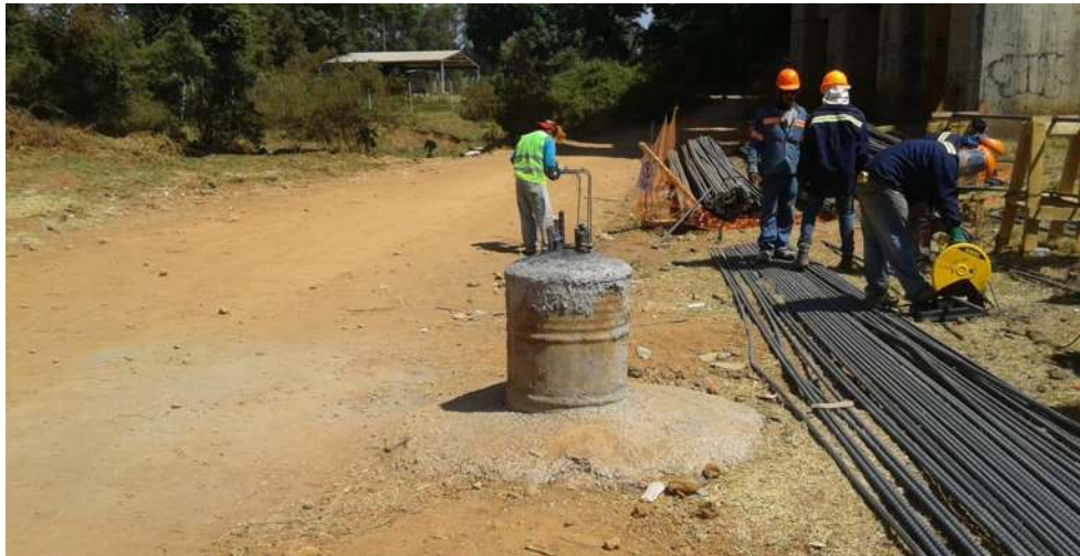
IMAGEN 20. HABILITADO DE ACERO DE REFUERZO PARA PILOTES, FUENTE: ALEJANDRO CORTÉS CRUZ.
