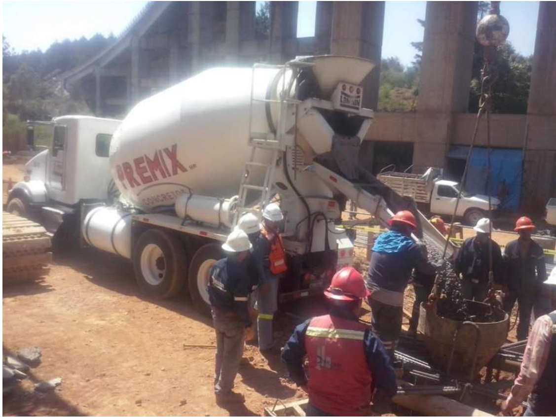
IMAGEN 25. COLADO DE PILOTES, FUENTE: ALEJANDRO CORTÉS CRUZ.
