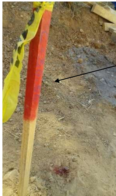
IMAGEN 16. REPLANTEO DE PILOTES, FUENTE: ALEJANDRO CORTÉS CRUZ.
