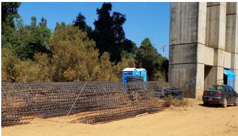
IMAGEN 21. ACERO DE REFUERZO PARA PILOTES, FUENTE: ALEJANDRO CORTÉS CRUZ
