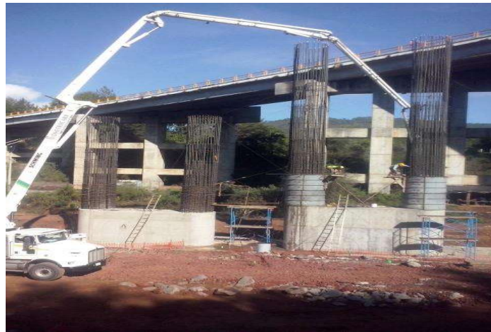
IMAGEN 28, COLADO DE TREPADO DE PILA APOYO 4, FUENTE: ALEJANDRO CORTÉS CRUZ
