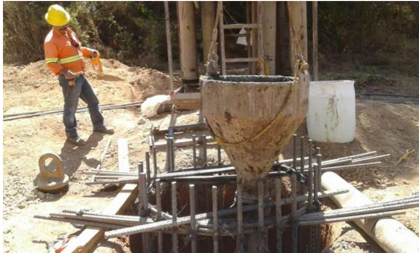
IMAGEN 23. TOLVA DE ACERO PARA COLADO DE PILOTES, FUENTE: ALEJANDRO CORTÉS CRUZ
