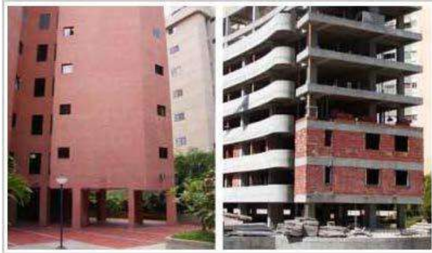
Figura 1.2 Ejemplo de edificio que presenta planta baja débil (Tomado de: http://www.ingcivil.org )
