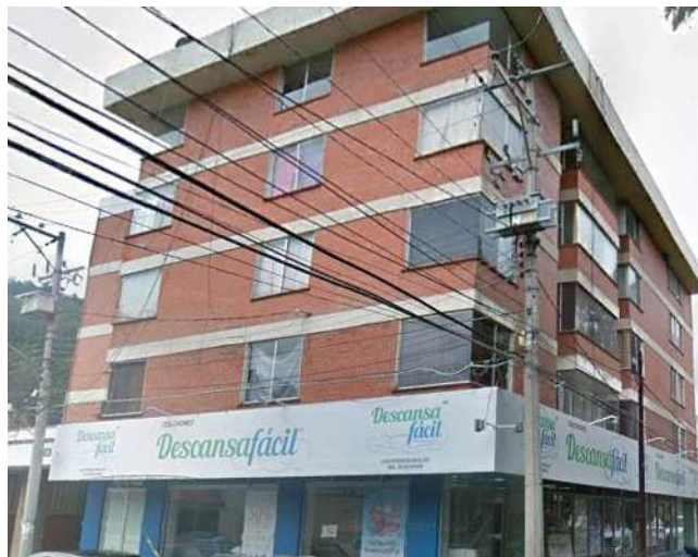
Figura 1.1 Ejemplo de edificio que presenta planta baja débil ubicado en la ciudad de Morelia, Michoacán (foto del autor)
