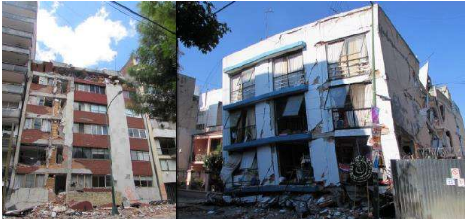
Figura 1.3 Edificios que colapsaron durante el sismo del 19 de septiembre de 2017 en la ciudad de México, los cuales exhibían planta baja débil (fotos de: Jorge Ruiz-García)
