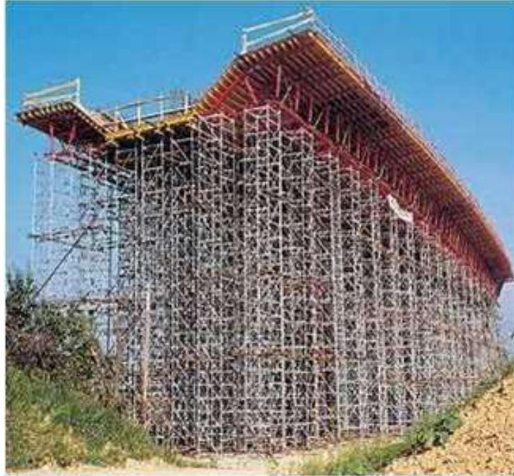
**Figura 22.** Ejemplo de cimbra apoyada sobre el terreno (Yepes, 2015).
