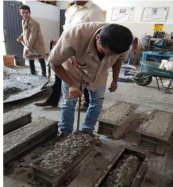
*Ilustración 73 Nivel de llenado de la última capa de concreto en vigas (Fotografía Víctor Ramírez).*
