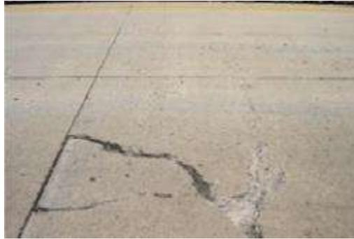
*Ilustración 5 Falla de agrietamiento de esquina en pavimentos rígidos.*
