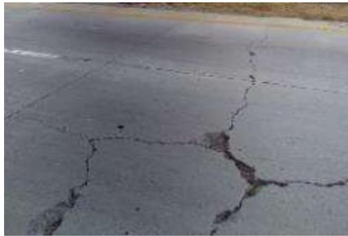
*Ilustración 6 Falla de agrietamientos transversales y longitudinales en pavimentos rígidos.*
