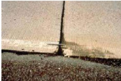
*Ilustración 4 Falla de escalonamiento en pavimento rígido.*
