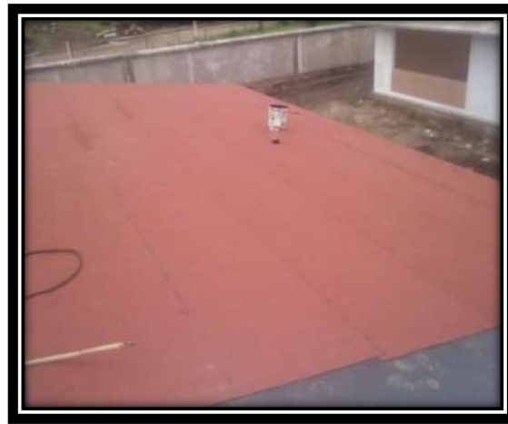
Figura V.84 acabado final del trabajo Fuente: Propia
