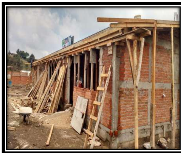
Figura V.40 Cimbra base de madera en elementos de trabes y losa.
