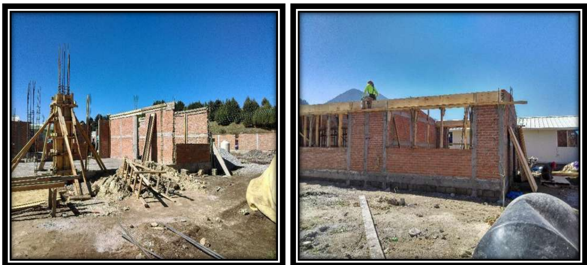
Figura V.40 Cimbra base de madera en elementos de trabes y columnas
