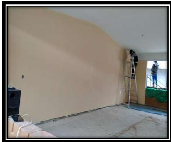
Figura V.82 pintura en muros boquillas y plafones. Fuente: Propia
