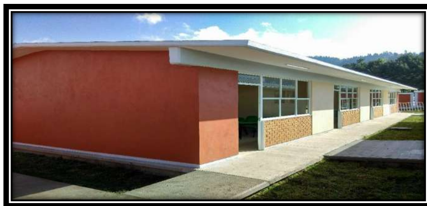
Figura V.95 limpieza de vidrios y tabletas. Fuente: Propia
