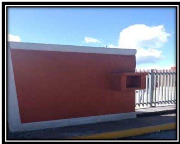
Figura V.47. Muro de acometida. Fuente: propia
