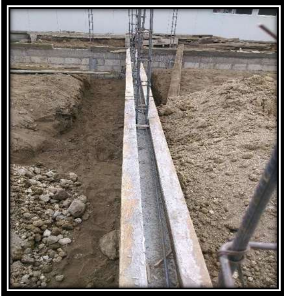
Figura V.29 Cimbrado para colado de zoclo. Fuente: Propia
