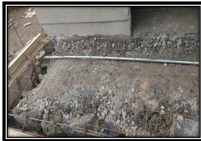
Figura V.34 Compactación del relleno, preparación del paso de tuberías. Fuente: Propia
