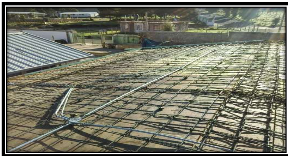
Figura V.42 colocación y verificación de tubería tipo conduit para paso de cableado eléctrico en losa. Fuente: propia
