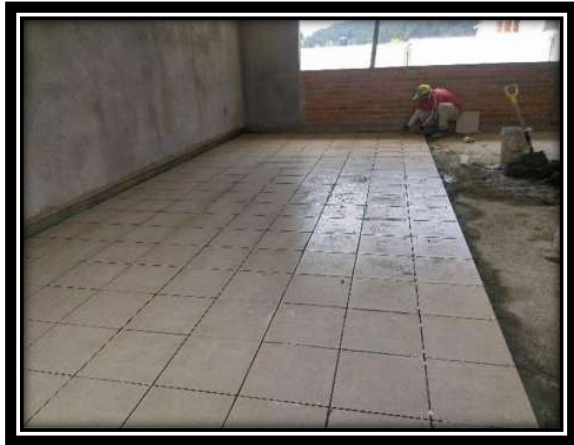
Figura V.85 colocación de loseta. Fuente: Propia
