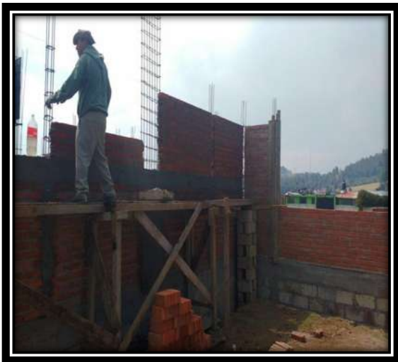
Figura V.31 Muros de tabique. Fuente: Propia
