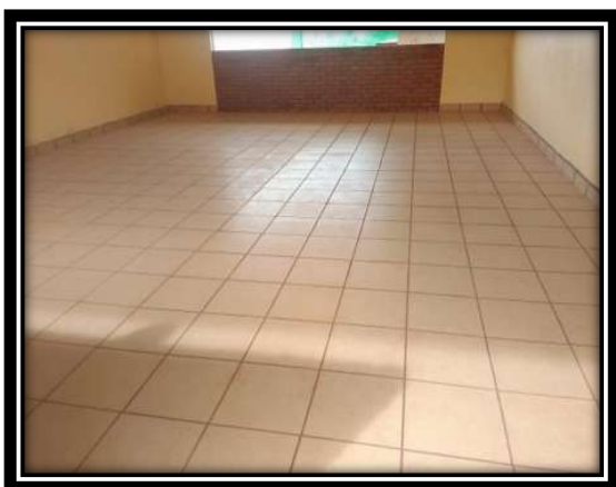
Figura V.93 limpieza de pisos de cerámica. Fuente: Propia
