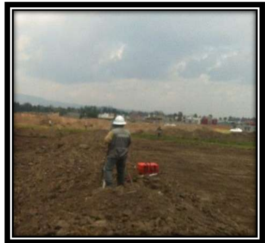
Figura V.14 y V.15 Trazo a base de cal, estacas e hilo, así como nivelación con nivel y estatal. Fuente: Propia.
