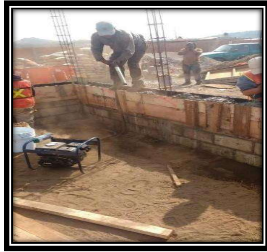
Figura V.25 Armado de contratrabe, (se verifico la altura y el armado) cimbrado y colado de la misma. Fuente: Propia
