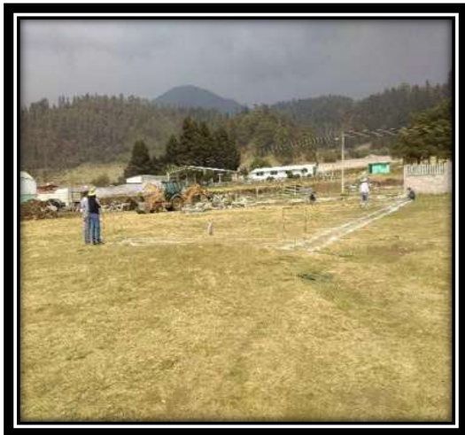
Figura V.14 y V.15 Trazo a base de cal, estacas e hilo, así como nivelación con nivel y estatal. Fuente: Propia.
