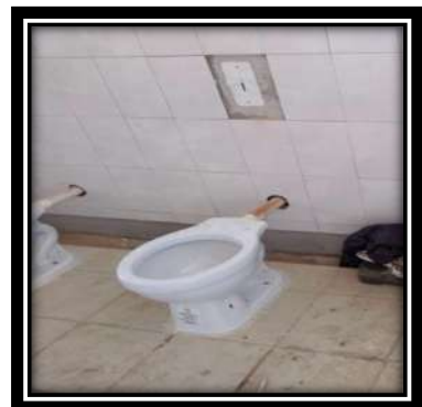
Figura V.68 colocación de W.C. tanque bajo y codo extensión. Fuente:
