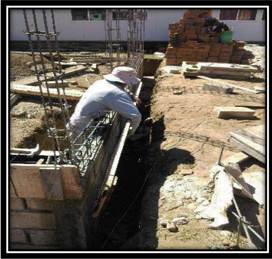
Figura V.25 Armado de contratrabe, (se verifico la altura y el armado) cimbrado y colado de la misma. Fuente: Propia
