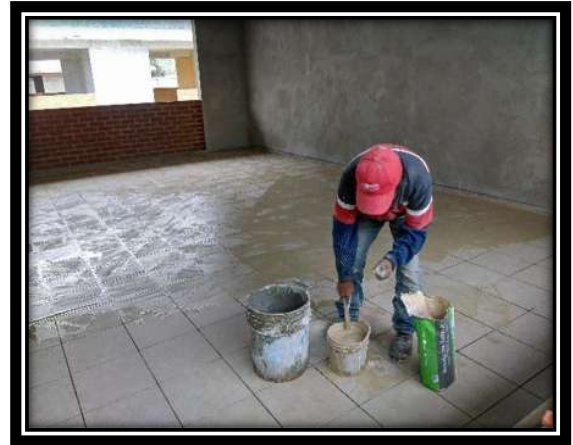
Figura V.86 trabajo de tiro de boquilla. Fuente: Propia
