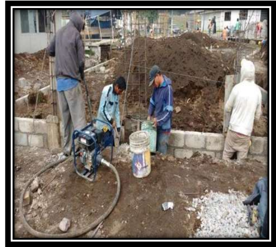
Figura V.24 Junteado de muros de enrase y colado de dados obsérvese en la figura el vibrado del elemento. Fuente: Propia
