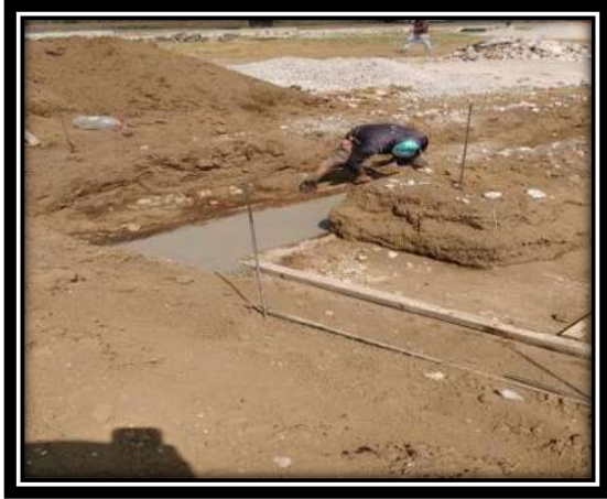
Figura V.22 Afine de excavación y tendido de cama o pedraplén y plantilla. Fuente: Propia
