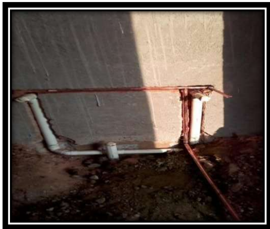
Figura V.74 sustitución de tubería de cobre. Fuente: Propia
