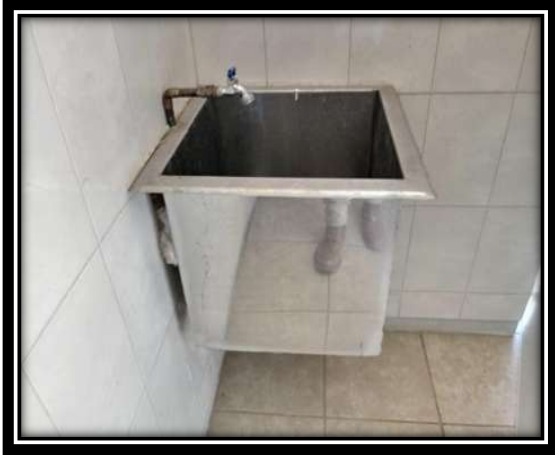
Figura V.69 colocación de vertedero en baños de hombres y mujeres. Fuente: Propia.
