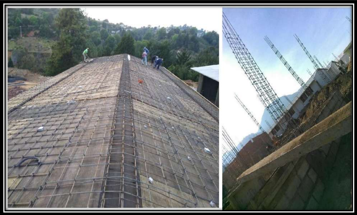
Figura V.39 Armado de acero de refuerzo. Fuente: propia.
