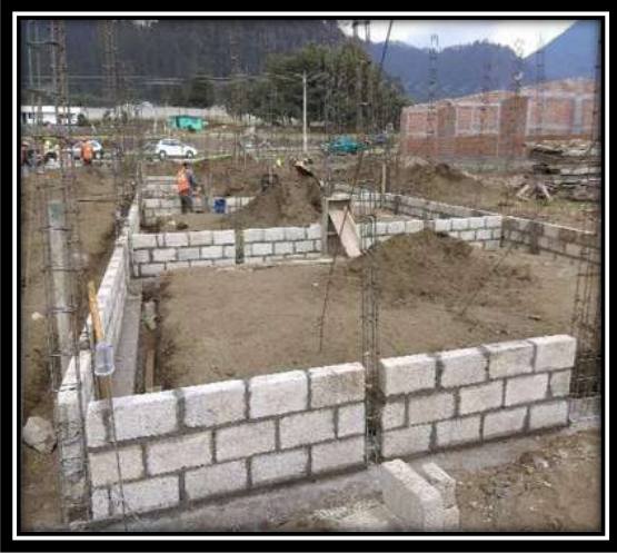
Figura V.24 Junteado de muros de enrase y colado de dados obsérvese en la figura el vibrado del elemento. Fuente: Propia
