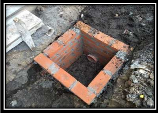
Figura V.59 elaboración de registro sanitario de 40x60 cm. Fuente: Propia
