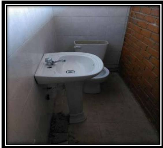
Figura V.65 colocación de lavabo marca Helvex. Fuente: Propia
