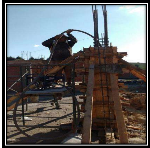
Figura 5.44 Vaciado de concreto y vibrado en columnas. Fuente: propia
