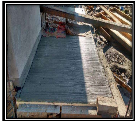
Figura V.33 Colado de banqueta y guarnición. Fuente: Propia
