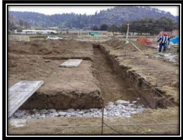
Figura V.22 Afine de excavación y tendido de cama o pedraplén y plantilla. Fuente: Propia
