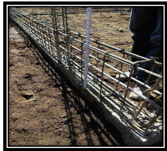
Figura V.25 Armado de contratrase, (se verifico la altura y el armado) cimbrado y colado de la misma. Fuente: Propia
