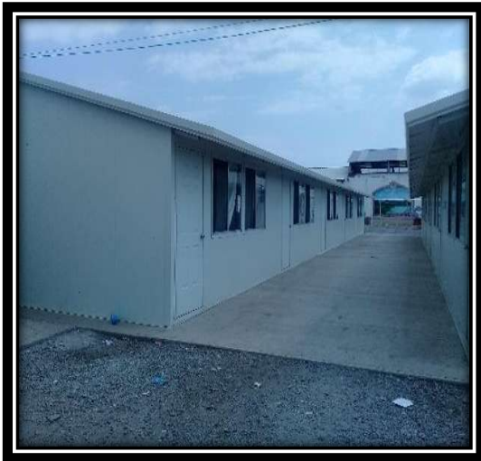
Figura I.3 Aula provisional en escuela afectada por el sismo. Fuente: Propia
