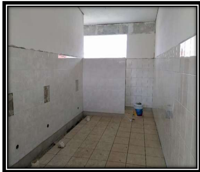
Figura: V.87 y V.88 colocación y limpieza de lambrín a base de azulejo. Fuente: Propia
