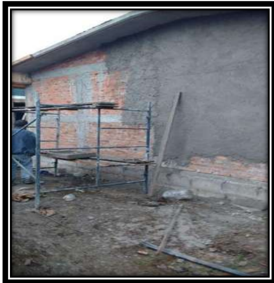
Figura V.79 Aplanado repellado en muros a reventon. Fuente: Propia
