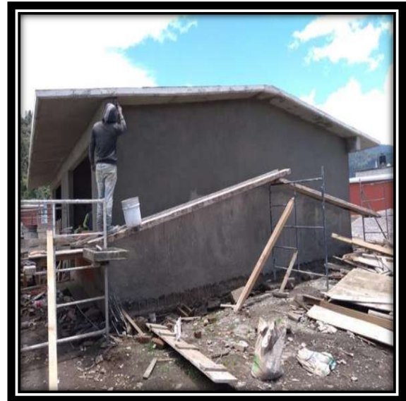
Figura V.80 colocación de pasta fina de cemento mortero arena sobre repellado. Fuente: Propia
