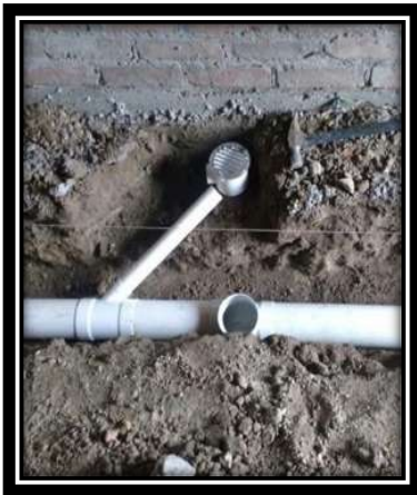
Figura V.71 colocación de coladera con rejilla redonda. Fuente: Propia
