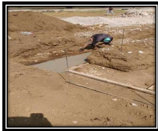
Figura V.20 Afine de excavación y plantilla. Fuente: Propia
