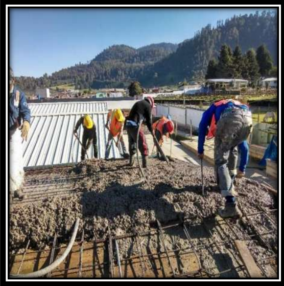
Figura 5.43 Colocación y vibrado de concreto en losa de azotea. Fuente: propia
