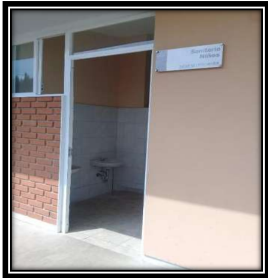
Figura:V.89 puerta metálica y ventana tipo E. Fuente: Propia
