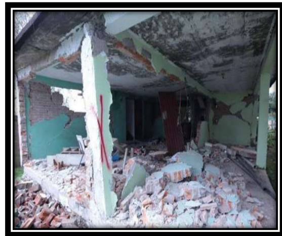
Figura I.6 Demolición de elementos dañados estructuralmente. Fuente: Propia
