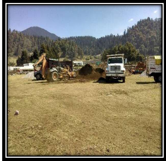
Figura V.12 y V.13 Despalme del terreno por medios mecánicos mediante una retroexcavadora y camiones de 7 m 3 para el retiro de material. Fuente: Propio
