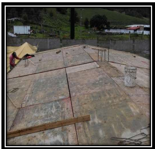
Figura V.40 Cimbra base de madera en elementos de trabes y losa.
