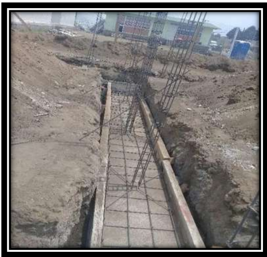
Figura V.23 Armado de zapata, cimbrado y colado con concreto hecho en obra. Fuente: Propia
