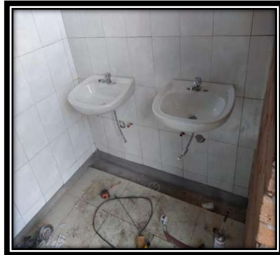
Figura V.66 colocación de lavabo ovalin. Fuente: Propia
