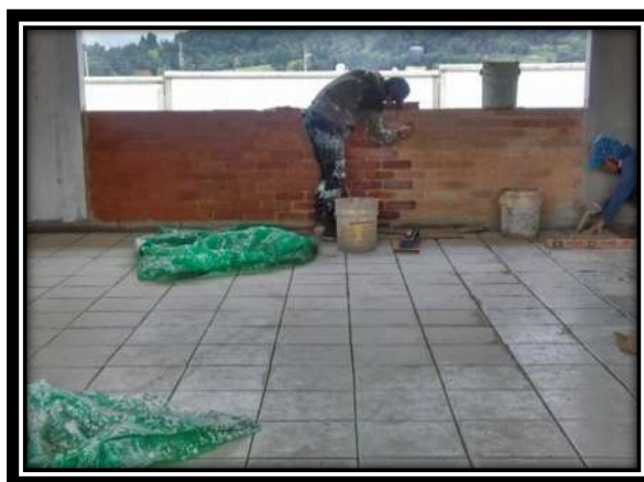
Figura V.94 Limpieza de muros de tabique aparente Fuente: Propia
