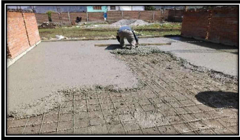
Figura V.35 Colado y reglado de firmes. Fuente: Propia
