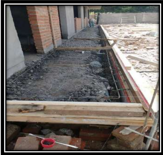
Figura V.32 Armado de la guarnición y cimbrado. Fuente: Propia
