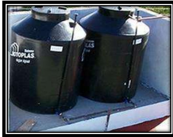
Figura V.75 interconexión y descarga de tinacos. Fuente: Propia
