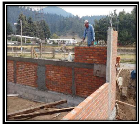
Figura V.31 Muros de tabique. Fuente: Propia
