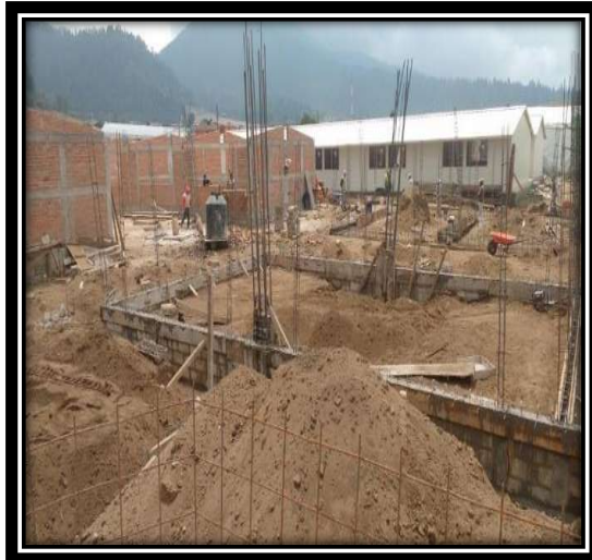
Figura V.26 Relleno con material producto de excavación y material inerte. Fuente: Propia
