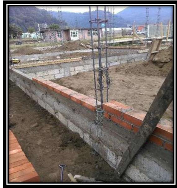
Figura V.30 Zoclo colado. Fuente: Propia
