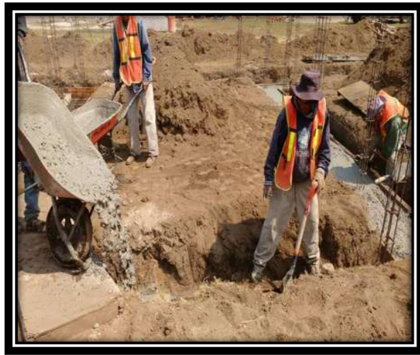
Figura V.23 Armado de zapata, cimbrado y colado con concreto hecho en obra. Fuente: Propia
