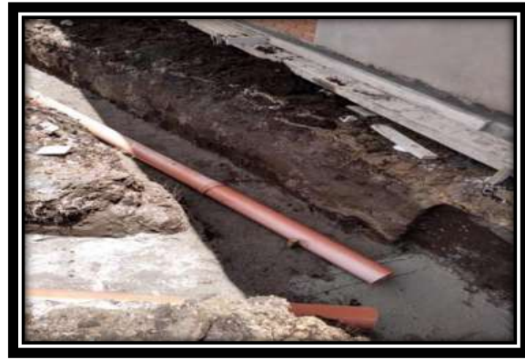
Figura V.60 tendido de tubería de PVC tipo anger reforzado para uso sanitario. Fuente: Propia
