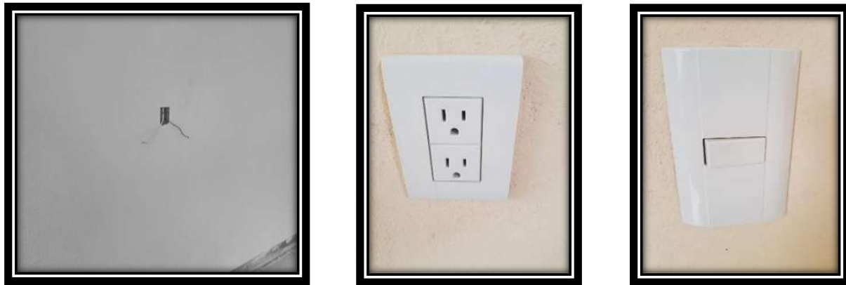
Figura V.56 Cableado e instalación de contacto e interruptor. Fuente: propia
