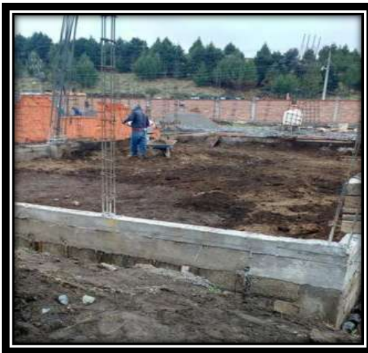
Figura V.26 Relleno con material producto de excavación y material inerte. Fuente: Propia
