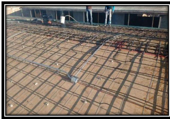
Figura V.52 instalación de salida eléctrica a base de tubo conduit tipo galvanizado y cableado. Fuente: propia
