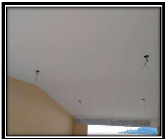
Figura V.55 Cableado y colocación de luminaria en aula. Fuente: propia
