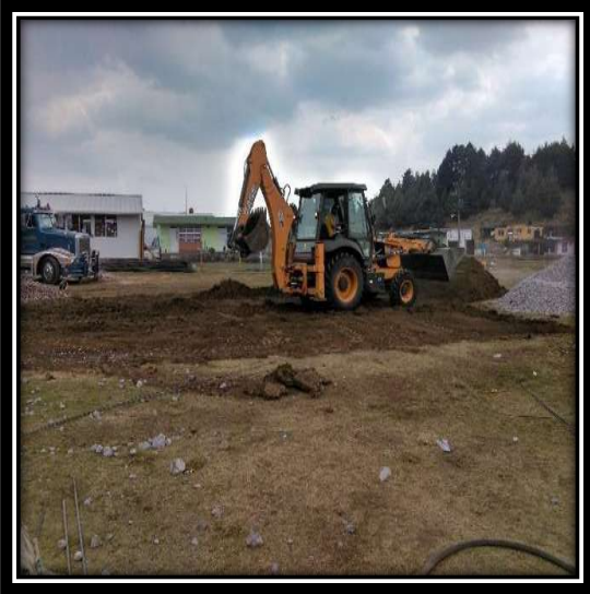
Figura V.12 y V.13 Despalme del terreno por medios mecánicos mediante una retroexcavadora y camiones de 7 m 3 para el retiro de material. Fuente: Propio
