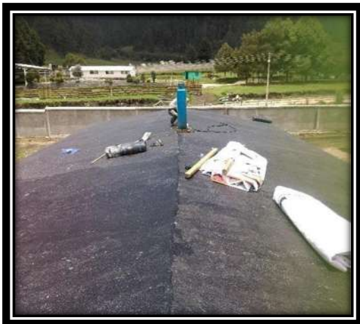
Figura V.83 preparación de fisuras con cemento asfáltico. Fuente: Propia
