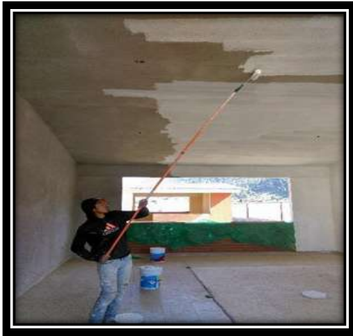
Figura V.81 pintura en plafones. Fuente: Propia
