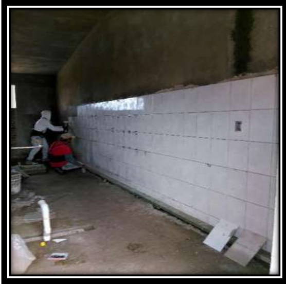
Figura: V.87 y V.88 colocación y limpieza de lambrín a base de azulejo. Fuente: Propia
