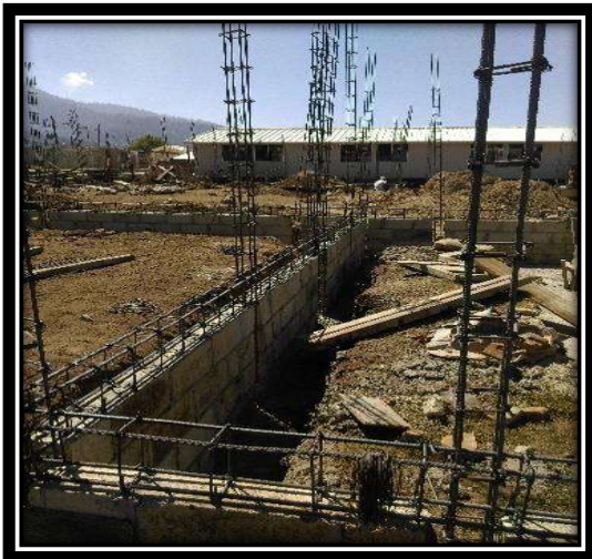
Figura V.25 Armado de contratrase, (se verifico la altura y el armado) cimbrado y colado de la misma. Fuente: Propia
