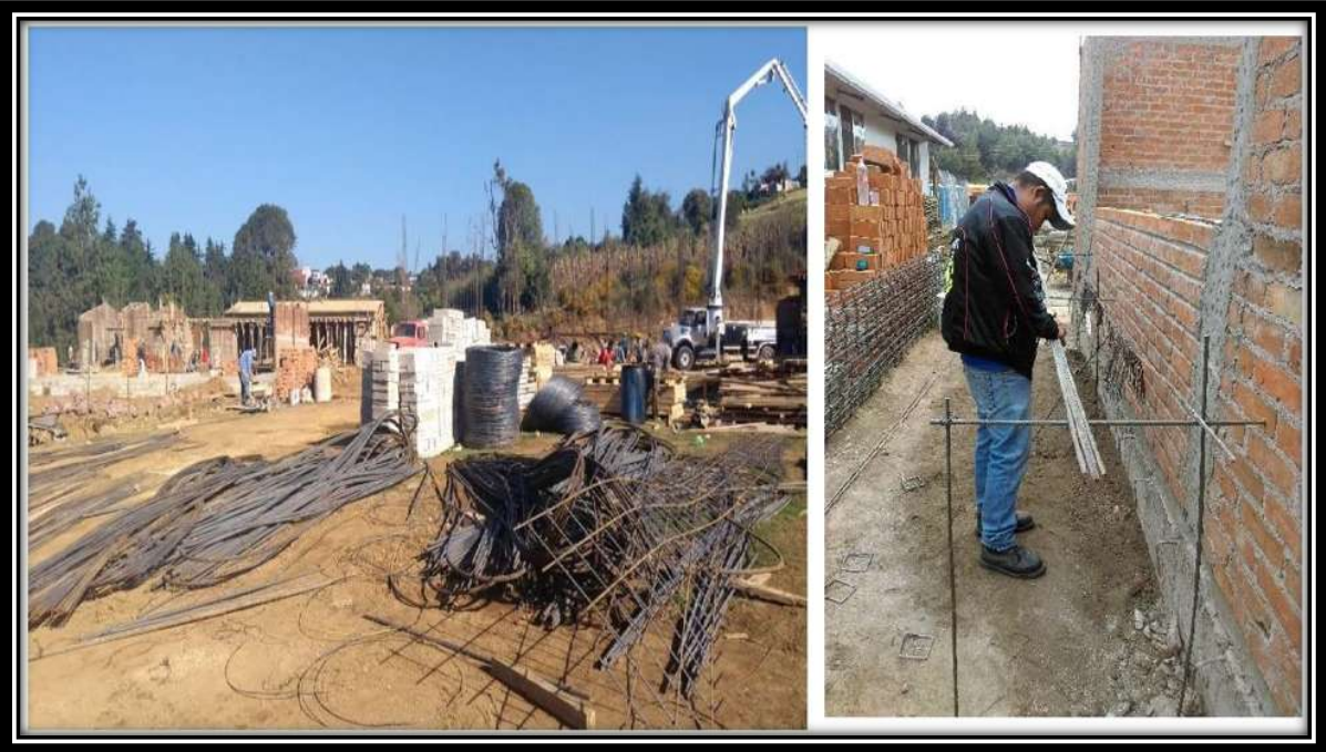
Figura V.38. Habilitado de acero de refuerzo. Fuente: propia
