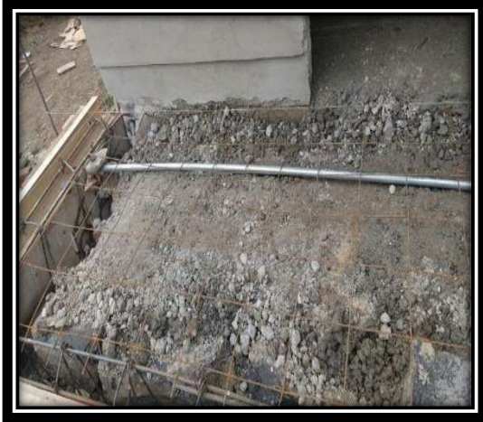
Figura V.50 y V.51 colocación de tuberías tipo conduit bajo banquetas y firme para el paso del cableado. Fuente: propia
