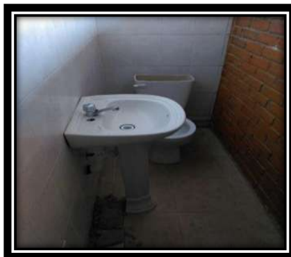
Figura V.67 colocación de taza tanque Propia
