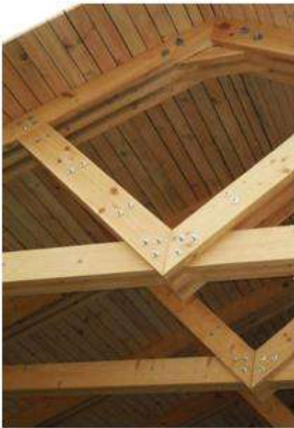
Imagen 58. Armadura tipo "A" con pernos
