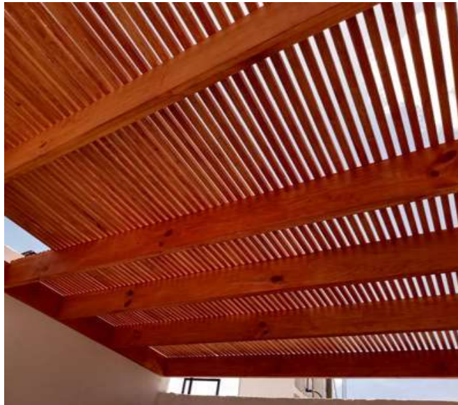
Imagen 87. Vista inferior de pérgola.
