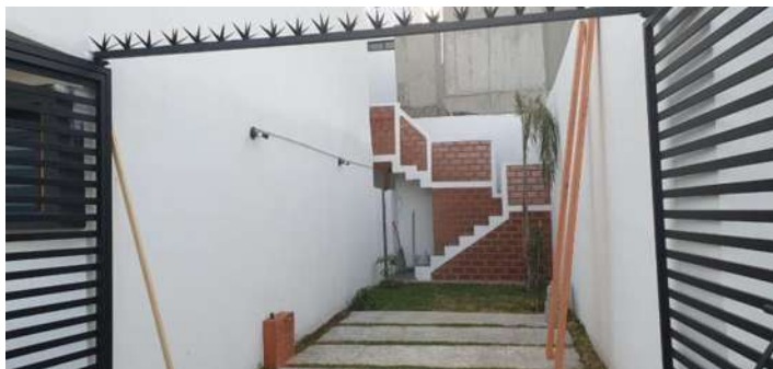
Imagen 93. Superficie de la pérgola.
