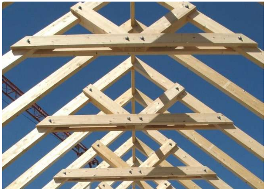
Imagen 59. Estructura de celosía.
