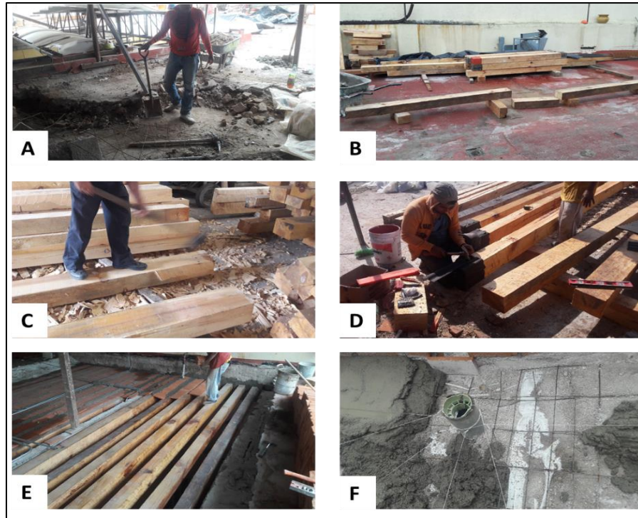
Figura 9. A) Retiro de escombros y liberación de vigas de madera, B) Selección de vigas de madera, C) Hachuelado de viga, D) Cubierta de viga en los extremos, E) Colocación de vigas y tapa de ladrillo rojo F) Tendido de terrado
