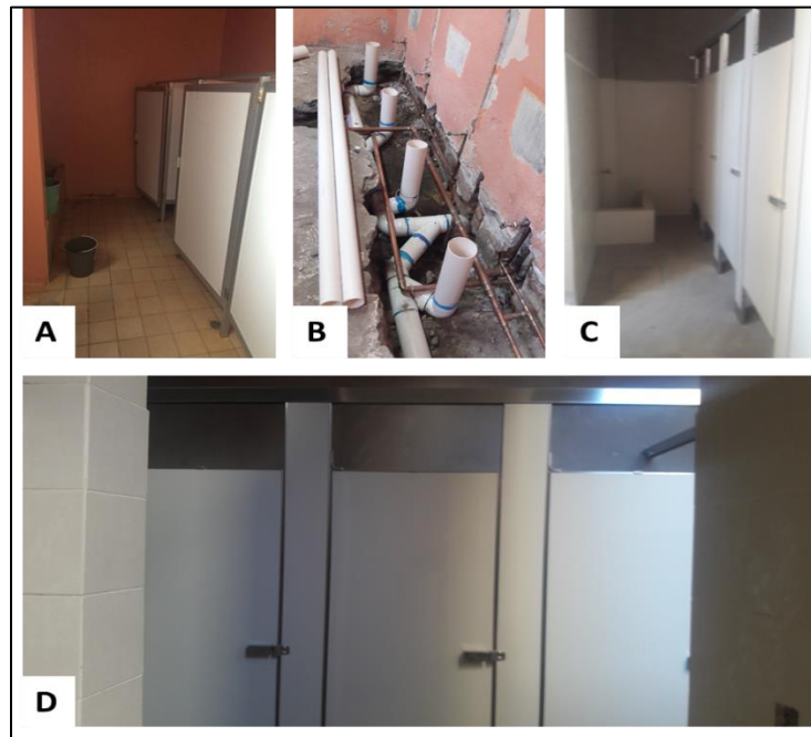
Figura 11. A) Sanitario antes de restauración, B) instalación sanitaria e hidráulica C):D) colocación de pisos y mamparas
