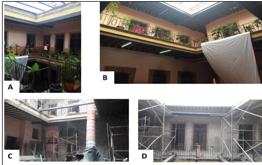
Figura 18. A) y B) Fachada interior en mal estado C) y D) proceso de restauración
