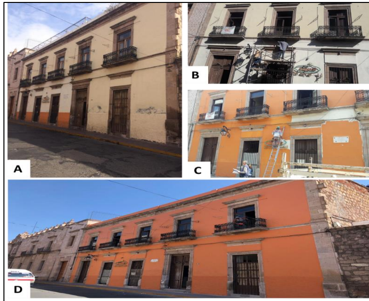
Figura 20. A) y B) Fachada principal antes de entrar en remodelación; C) Proceso de ejecución; D) Fachada pintada terminada
