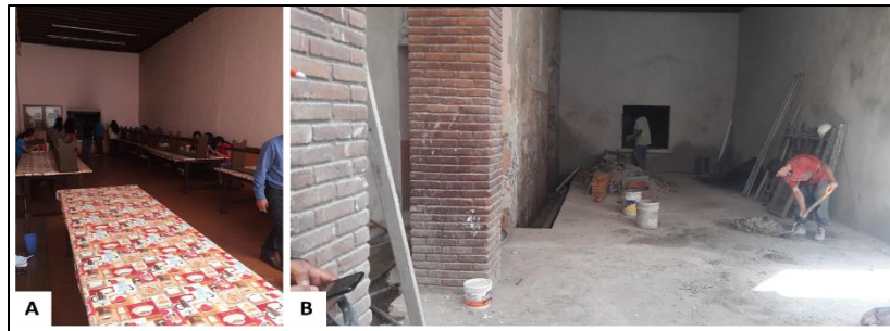
Figura 16.- A) Antes de demolición, B) Proceso de restauración
