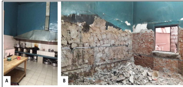
Figura 12. A) Cocina antes de remodelación, B) Retiro de aplanados en mal estado a base de cincel y marro
