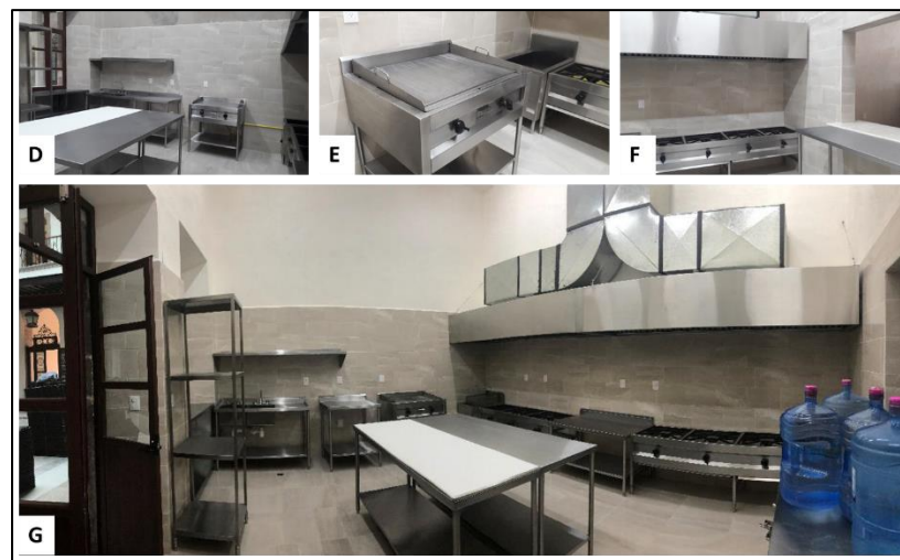
Figura 14. Colocación de mobiliarias, piso y acabados
