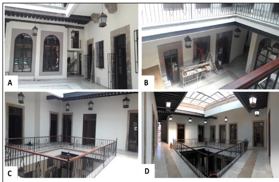
Figura 19. A) y B) Fachada interior restaurado planta baja C y D Fachada interior restaurado planta alta
