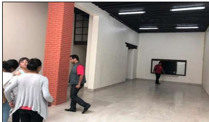
Figura 17. Cocina completamente restaurada
