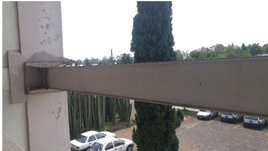
Figura 12. Viga de acero colocada para rehabilitación del edificio
