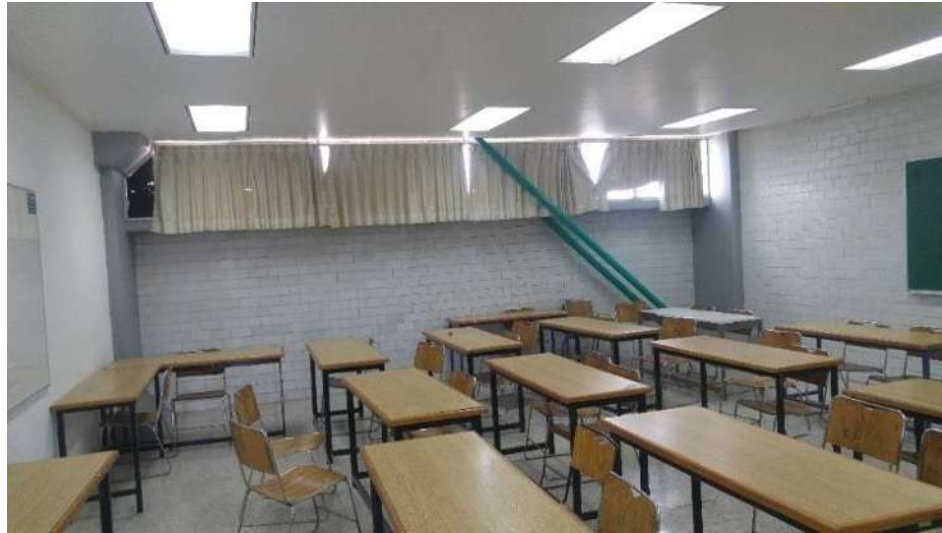
Figura 10. Vista de los cables de refuerzo desde el interior de una de las aulas, se puede observar que se usan tubos para proteger los cables de daños.
