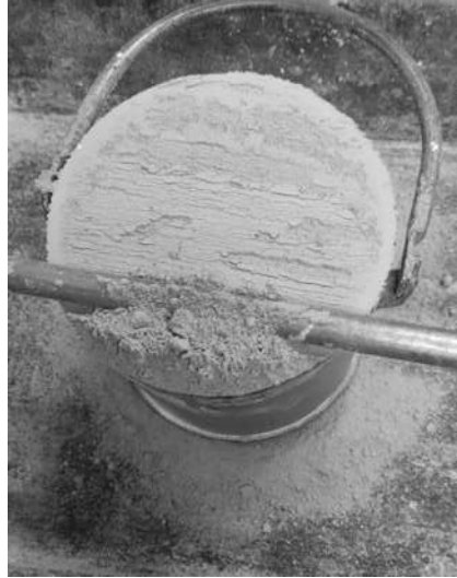
Ilustración 35. Enrasado de mortero para la MVSS. (Fuente: Elaboración Propia)
