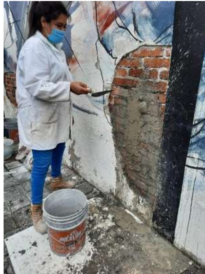
Ilustración 48. Prueba de adherencia en muro del Laboratorio de Materiales. (Fuente: Elaboración Propia.)
