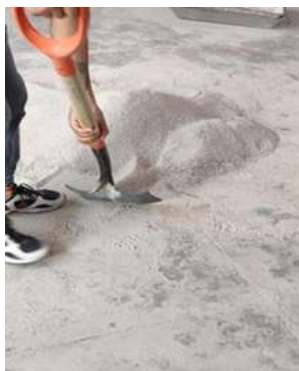
Ilustración 9. Movimiento del material con ayuda de la pala. (Fuente: Elaboración Propia)
