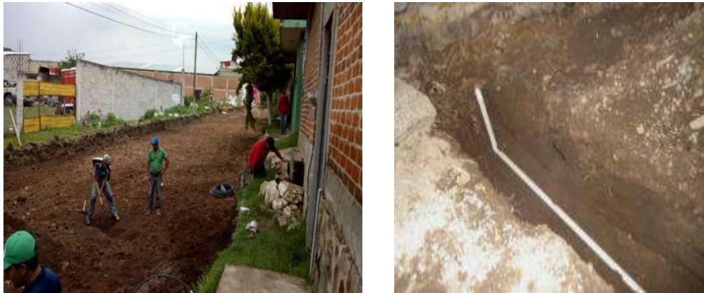
Fig. N°28.- Instalación de tubería de agua potable y sanitario.
