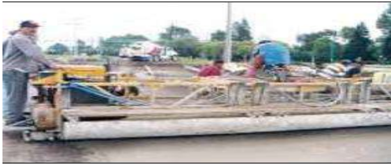
Fig. N°38.- Rodillos compactadores para concreto.
