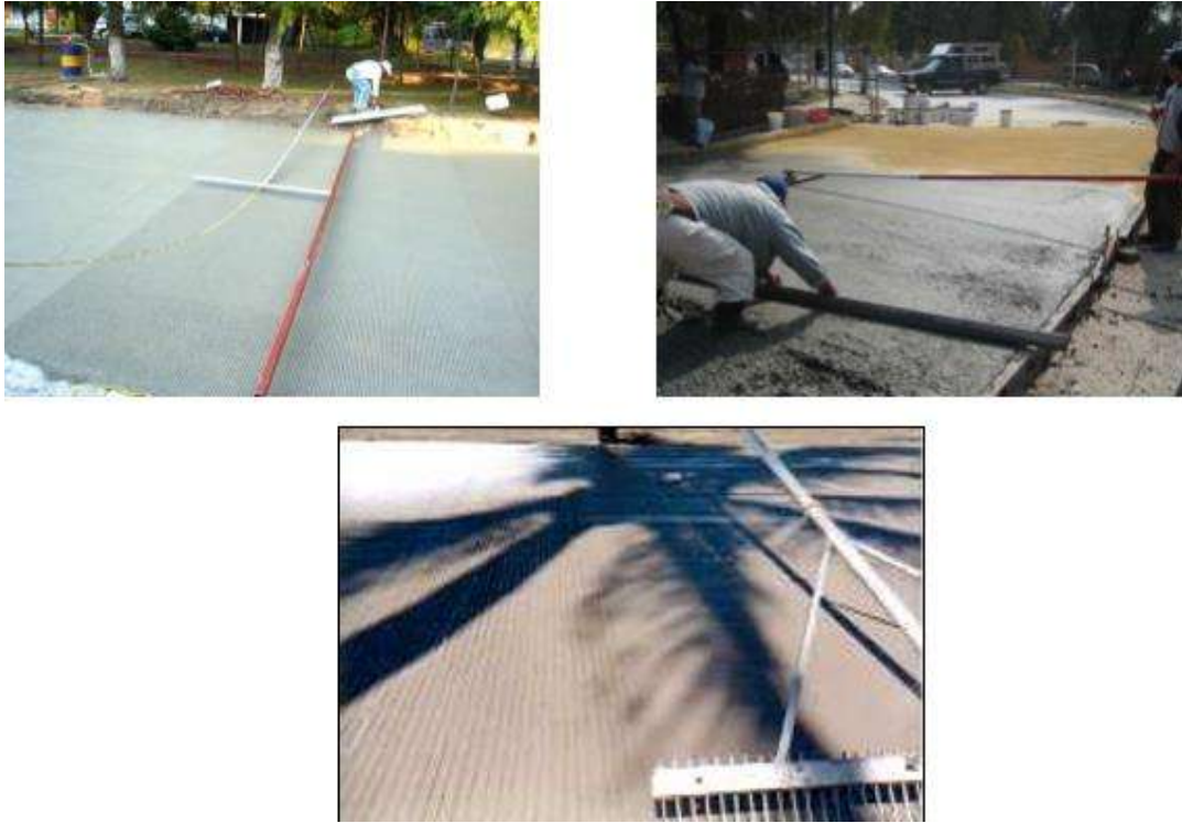
Fig. N°49.- Peine con dientes metálicos para texturizado transversal manual.
