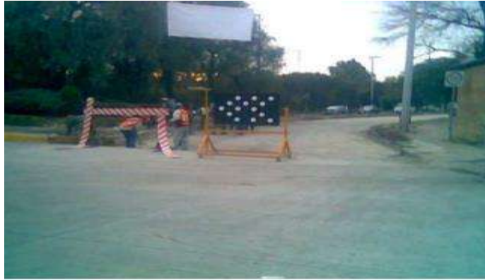
Fig. N°31.- Colocación de señalamientos.
