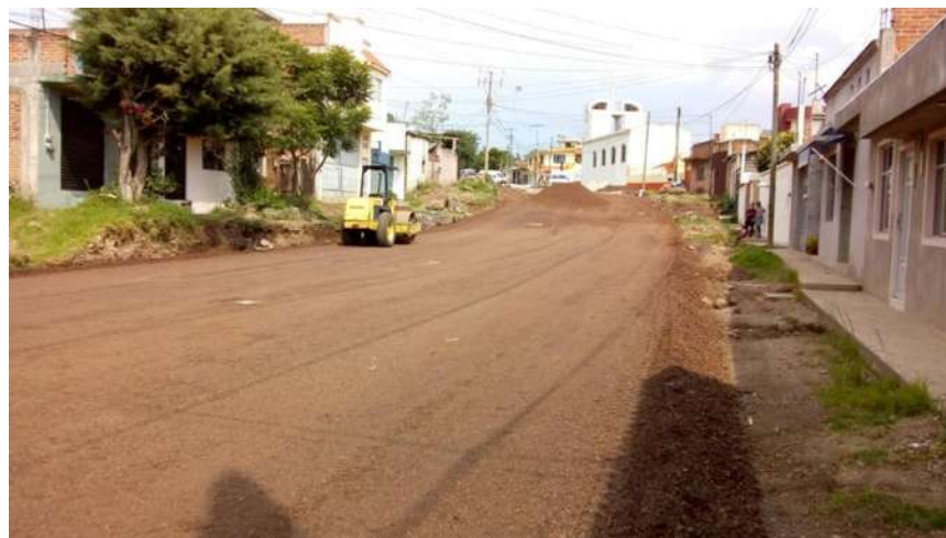
Fig. N°37.- Compactación del material de cierta capa.
