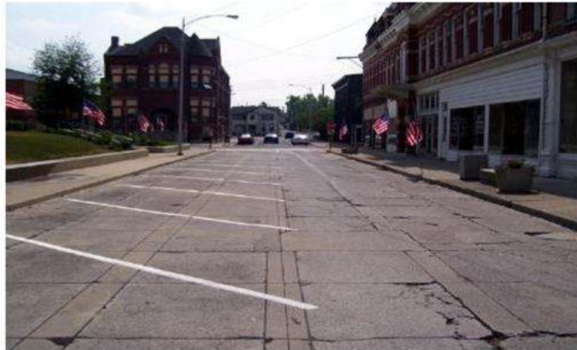
Fig. N°1.- Pavimento en Bellfountain (1891)
