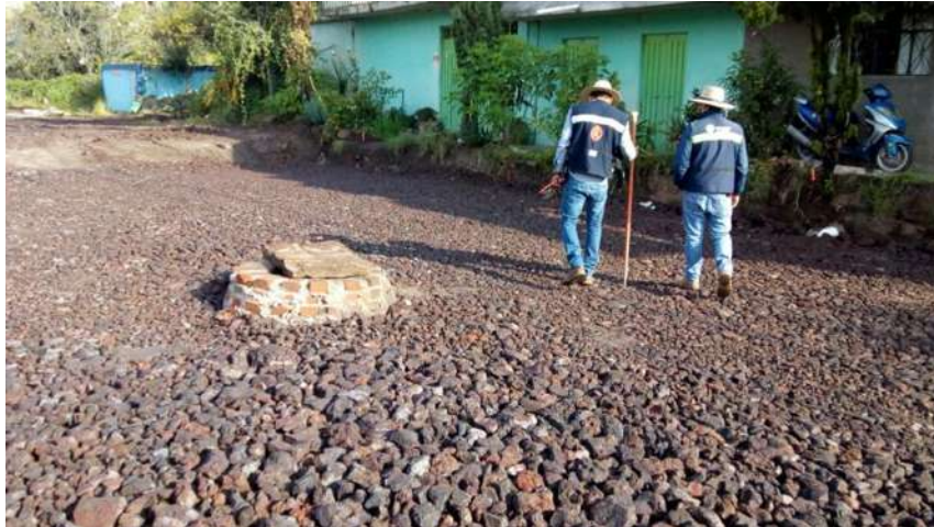
Fig. N°8.- Supervisión de capa de filtro.
