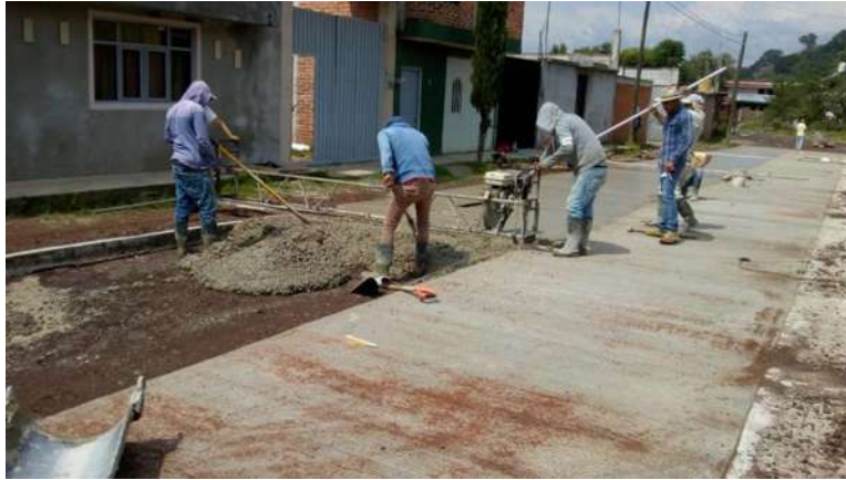
Fig. N°40.- Tramo de concreto hidraulico colado con cimbra metalica fija y regla vibratoria de concreto.
