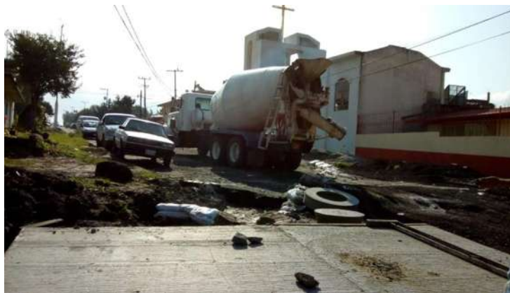
Fig. N° 16: Muestreo del concreto hidráulico.
