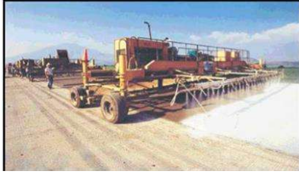
Fig. N°52.- La texturizadora - curadora aplicando la membrana de curado al pavimento.
