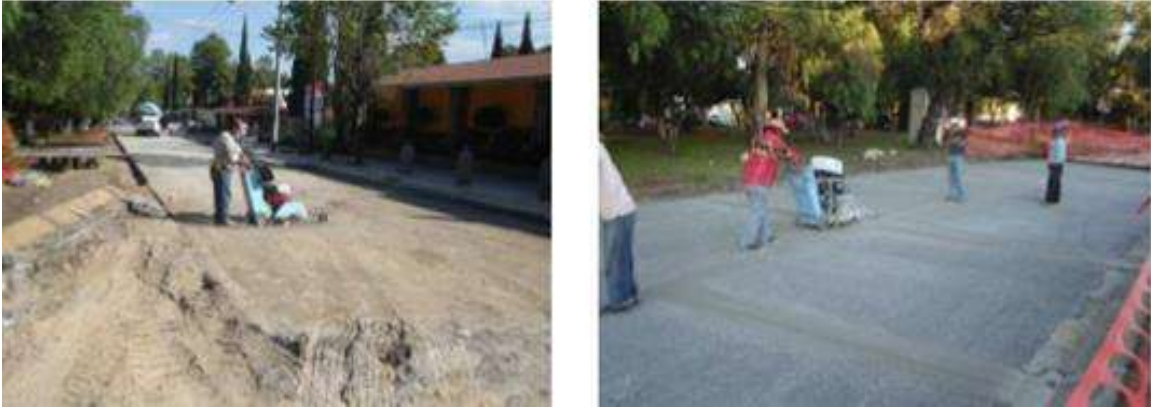
Fig. N°53.- Cortadoras con disco de diamante para realizar el aserrado del concreto.
