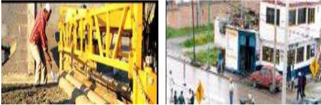
Fig. N°42.- Rodillos compactadores de concreto sobre cimbra fija
