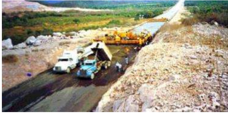
Fig. N°41.- Pavimento de una carretera con equipo de cimbra deslizante.
