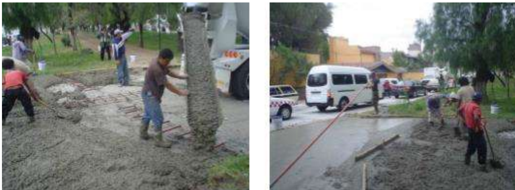
Fig. N°43.- Colocación manual de concreto
