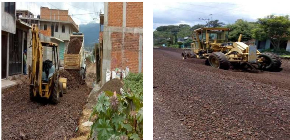
Fig. N°29.- Tendido de material.
