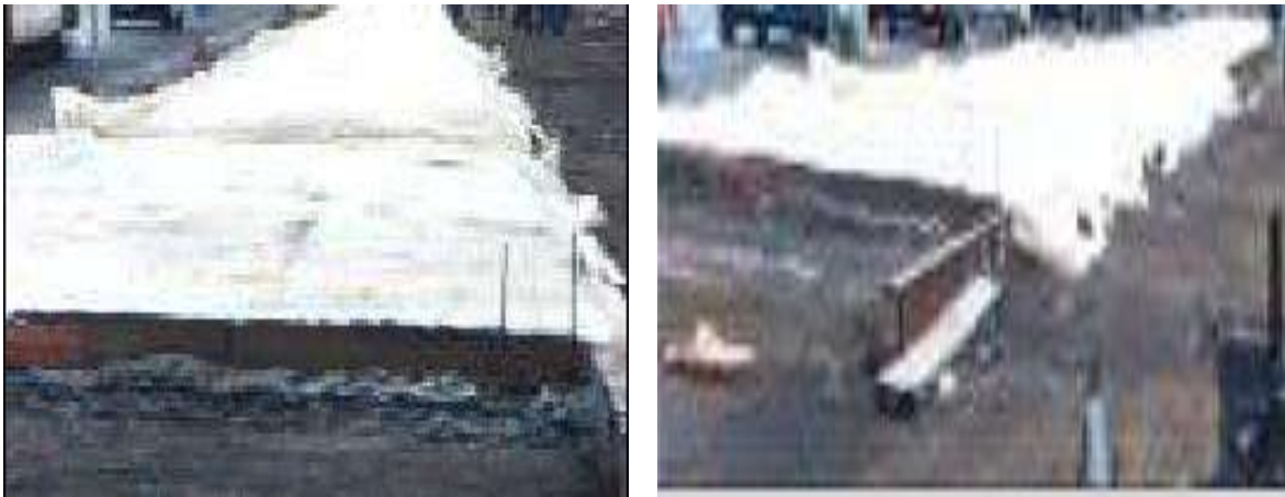
Fig. N°33.- Colocación de cubiertas protectoras en casos de lluvia.
