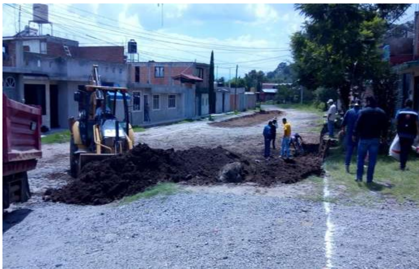
Fig. N°27.- Retiro de material de desperdicio.
