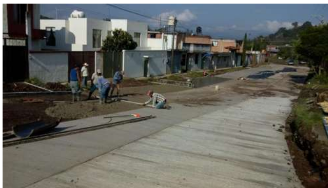
Fig. N°39.- Utilizacion de regla vibratoria.
