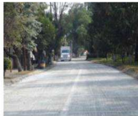
Fig. N°55.- Vehículos y equipo de construcción circulando después de 7 días de colado el pavimento.
