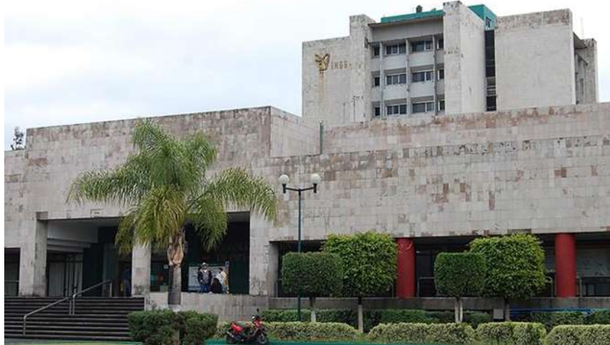
Ilustración 11. Torre del IMSS de donde se obtuvo el agregado reciclado producto de su demolición. (Jiménez, La Voz de Michoacán, 2020)
