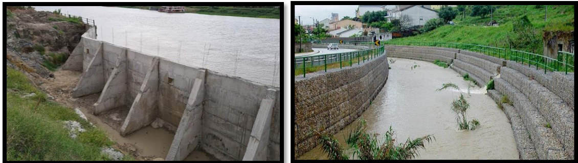
Figura 10 Ejemplos de diques y muros de contención para proteger zonas aledañas a cauces de un fenómeno excedente
