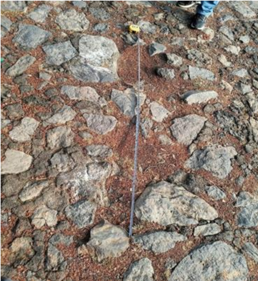
Ilustración 49. Empedrado en Seco.
