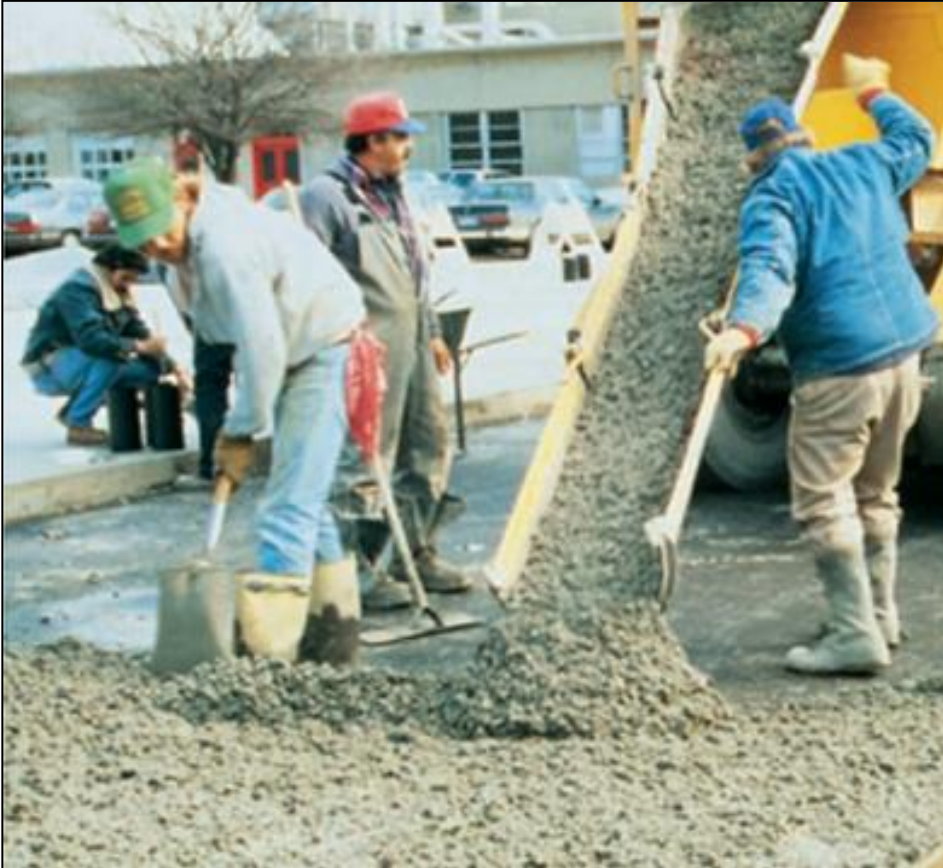
Ilustración 25. Pavimento de concreto hidráulico.
