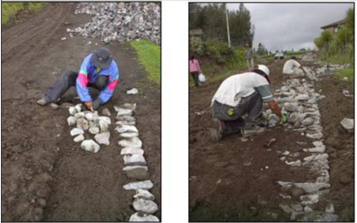
Ilustración 27. Sistema constructivo del Empedrado en seco
