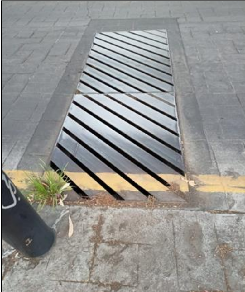
Ilustración 20. Alcantarilla en Calzada Juárez, Morelia.
