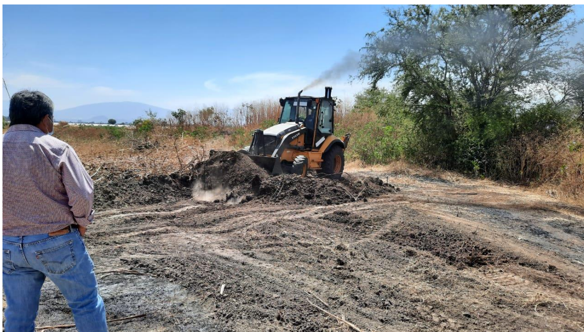
Figura 14. Trabajo de campo: Despalme de terreno, Elaboración propia , 2021.
