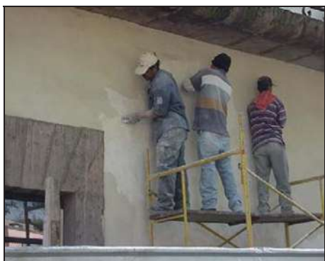
Figura 62. Limpieza de la fachada poniente.
