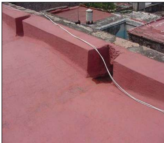
Figura 68. Instalación eléctrica en la azotea.
