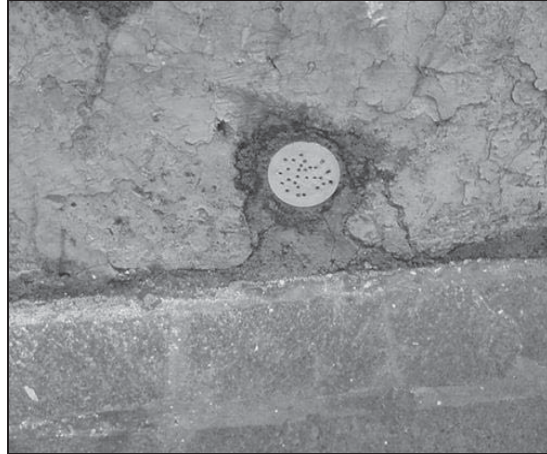
Figura 67. Sistema de aerodren.
