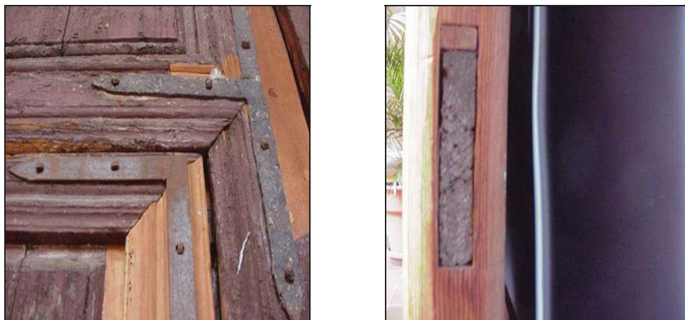
Figura 46. Puerta original de su Casa Anexa y detalle del ensamble.
