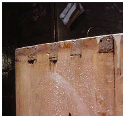
Figura 22. Cajón con ensamble de cola de milano
