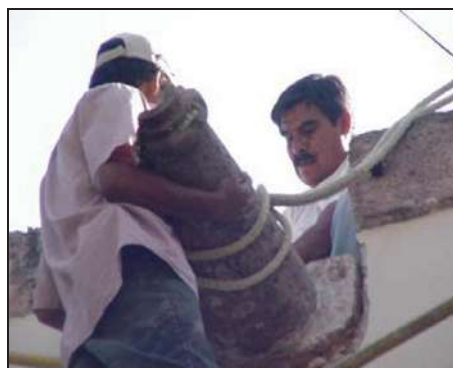
Figura 63. Reposición de gárgolas de cantera.
