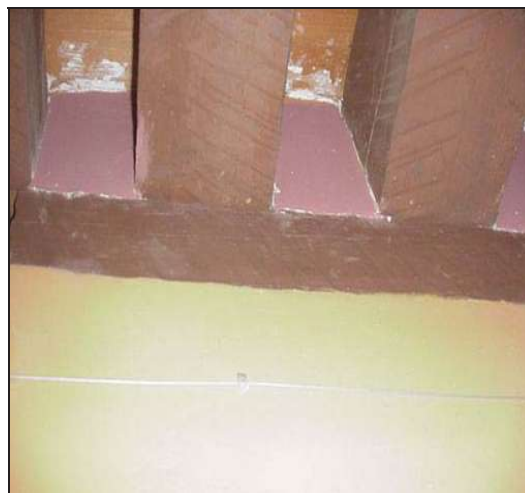
Figura 43. Vigas de cerramiento.
