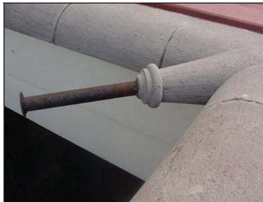
Figura 57. Gárgola en buen estado Casa Anexa.
