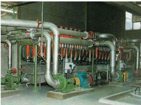
Figura 45.- Limpiadores o depuradores ciclónicos y detalle del depurador ciclónico.
