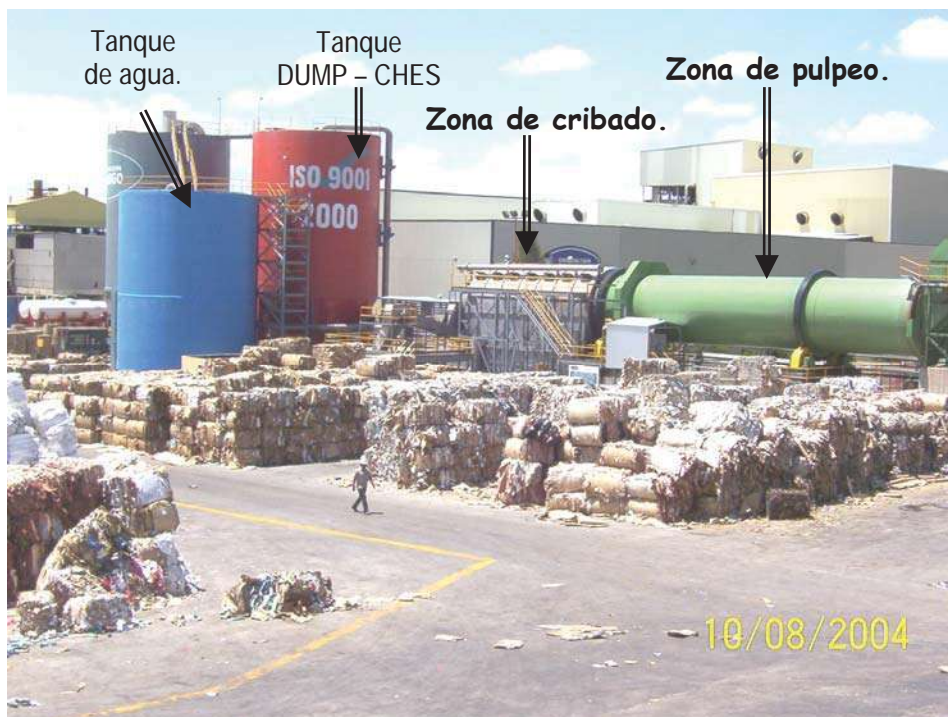
Figura 27.- Almacenamiento de la pasta en el tanque DUMP – CHES.
