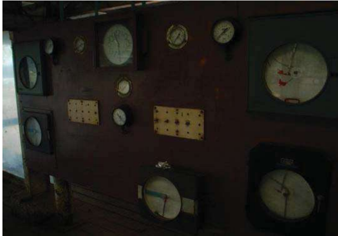
FIGURA No. 7 Aparatos de medición que indican el progreso del tratamiento: termómetros, manómetros, vacuómetros y gráficos presión-tiempo. Impregnadora el color campo, campo, ic.
