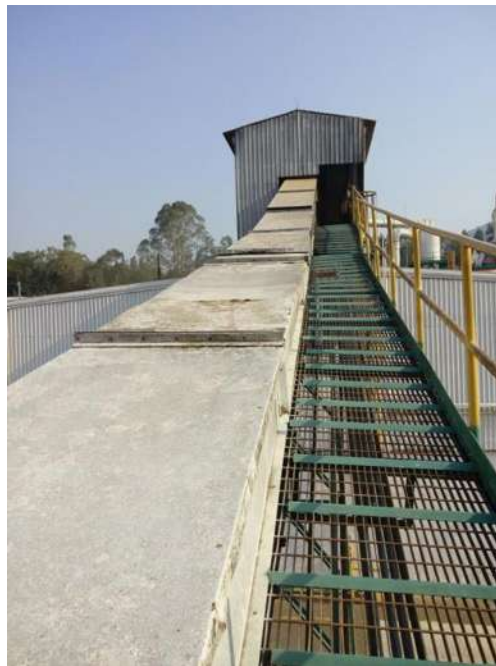
Figura 9. Banda transportadora hacia el cobertizo.
