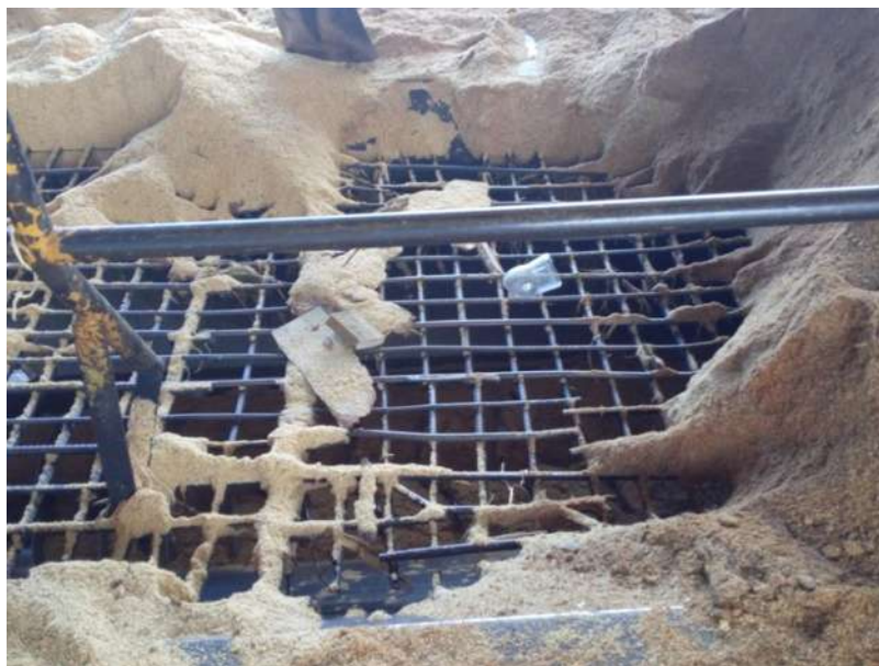
Figura 45. Tolva en donde es depositado el aserrín.
