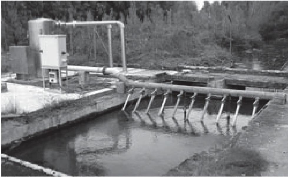
**Figura 2.11. Tanque para desinfección.**
