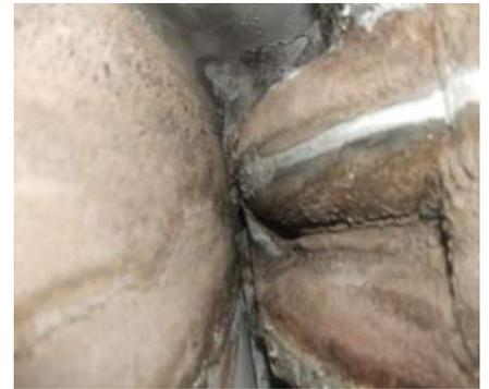
La concentración de SO<sub>3</sub> cuando el Bióxido de Azufre y Oxígeno se incrementan, al ocurrir esto convierten el flujo de gases altamente corrosivos, este tipo de corrosión es frecuentemente encontrada en la salida de los Economizadores de una Caldera de Recuperación que es donde la temperatura de Gases es menor y la entrada de aire frío es mayor, igualmente en el Precipitador, el Inspector deberá de tomar en cuenta esta condición.
