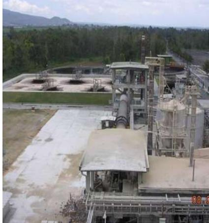
El proceso consiste en alimentar el licor verde a un clarificador donde por sedimentación se separan los materiales inertes, mientras que la solución se envía al apagador de cal en donde se agrega el óxido de calcio ( $\text{CaO}$ ) el cual al contacto con el agua del licor verde se Hidroliza; la reacción de Caustificación se lleva a cabo en tres tanques conectados en serie llamados Caustificadores.
