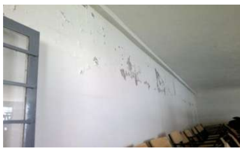
Figura 21. Daños a causa de la Humedad.
