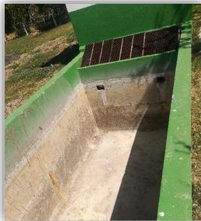
**Imagen 23.** Ilustración del Tanque de Filtrado 1, PTAR de la localidad Dr. Miguel Silva.
