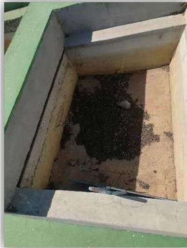
**Imagen 16.** Ilustración de Caja de entrada al proceso, PTAR de la localidad Cuaracurio.
