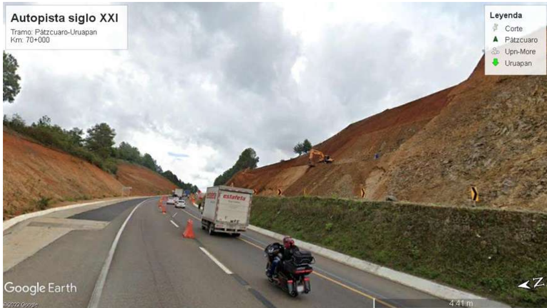
Figura 4: Autopista siglo XXI, km 70+000
