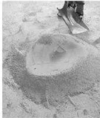
Ilustración 12. Con ayuda de la pala se aplana la parte superior. Fuente: (Durán Ramos, 2021).
