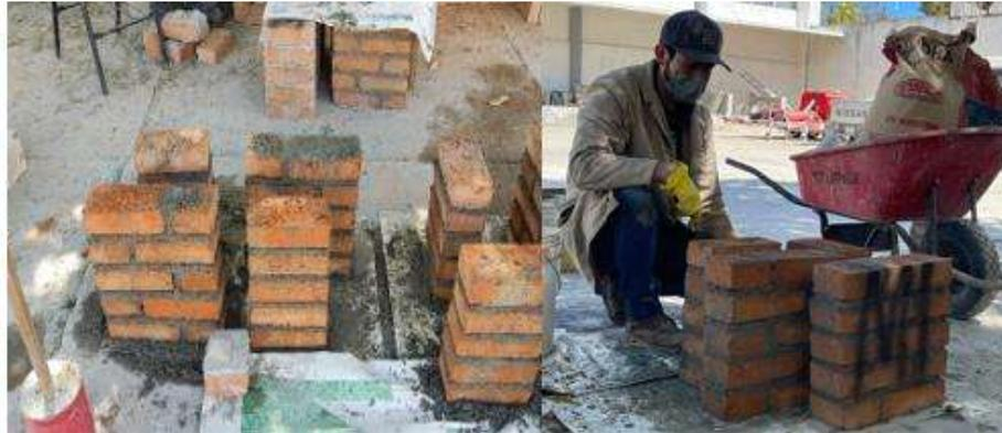
*Ilustración 67. Elaboración de pilas y muretes para pruebas a 28 días. Fuente: Propia.*
