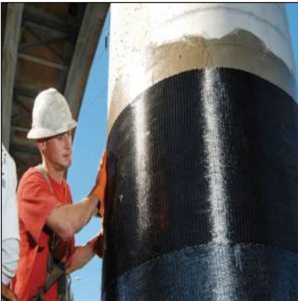
Figura 30.- Rehabilitación de estructura de concreto, utilizando fibra de carbono.
