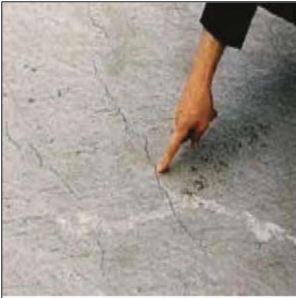
Figura 34.- Fisura en el concreto debido a la pérdida de agua en la superficie.
