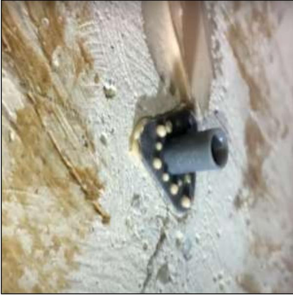
Figura 24.- Puerto de inyección colocado con mortero epóxico. (27/Marzo/2022)
