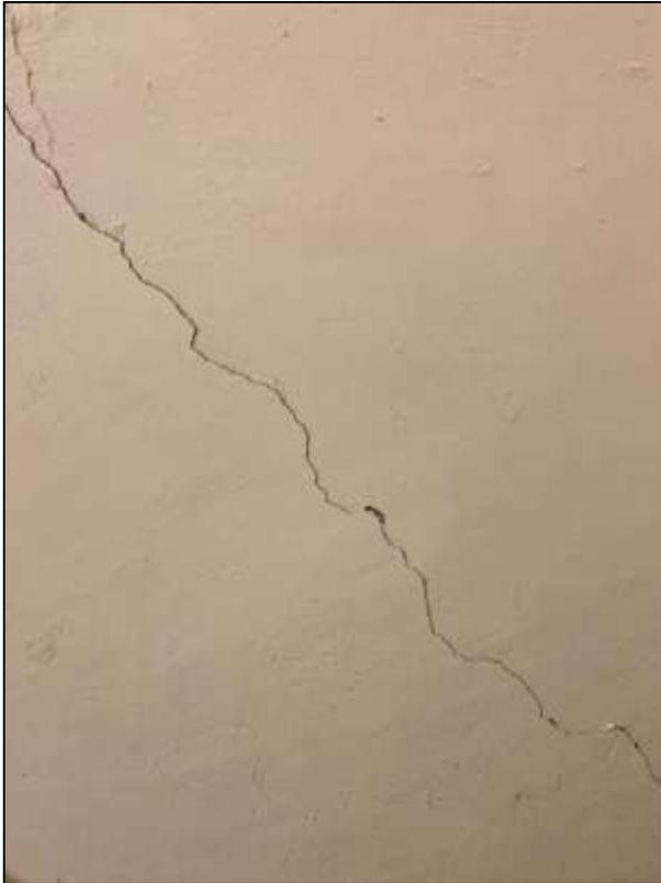
Figura 21.- Fisura en muro producida por el sismo de marzo 2017. (26/Marzo/2022)
