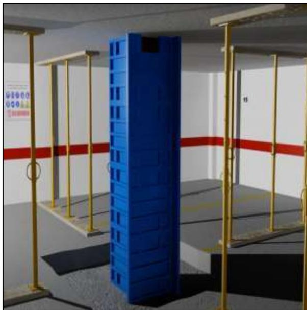
*Figura 19.-Encofrado de columna.*
