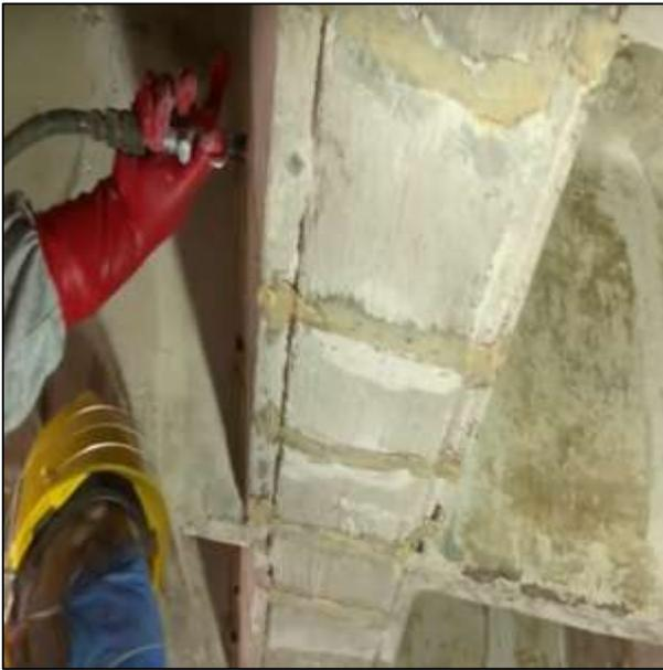
Figura 25.- Limpieza de grieta con aire comprimido.
