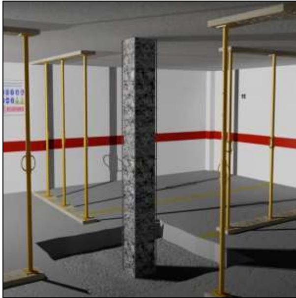
*Figura 18.- Columna con refuerzo expuesto, para proceso de reforzamiento. (19/Marzo/2022)*
