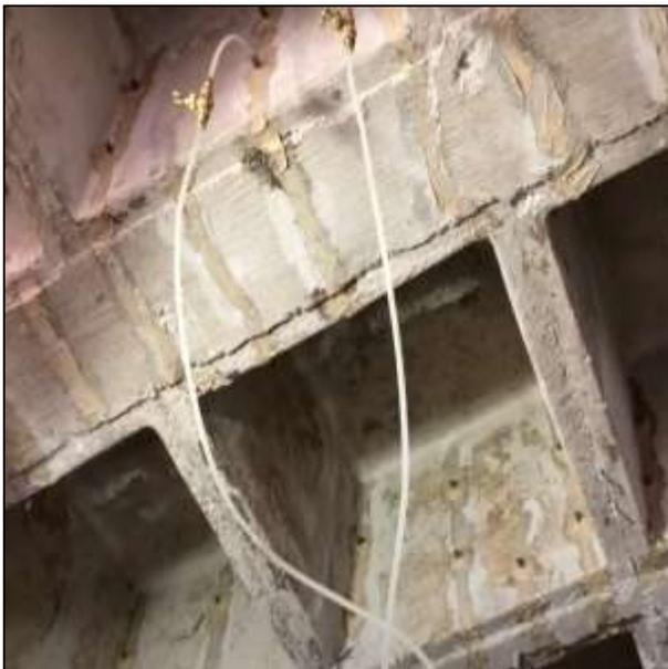
*Figura 26.- Inyección de resina epóxica.*
