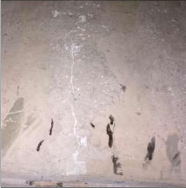
Figura 28.- Grieta sellada con resina epóxica.
