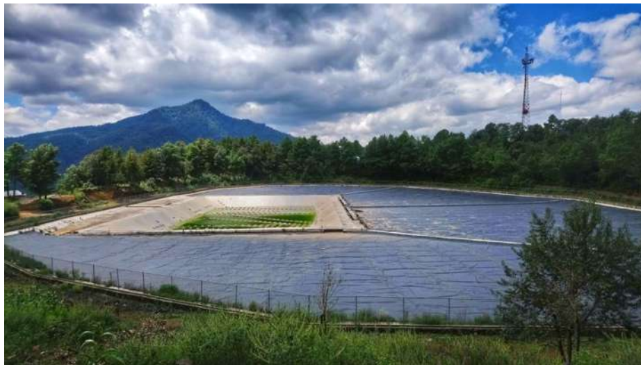
Figura 3.- Captador de agua pluvial más grande de América latina, ubicado en la cima del cerro "kukundikata" en el municipio de Cherán, Michoacán, México.
