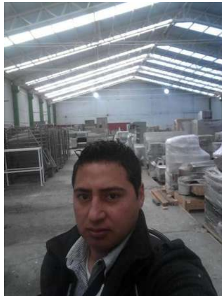
Figura 42: Para tener un horario más largo de operación, se instalaron lámparas en toda la bodega
