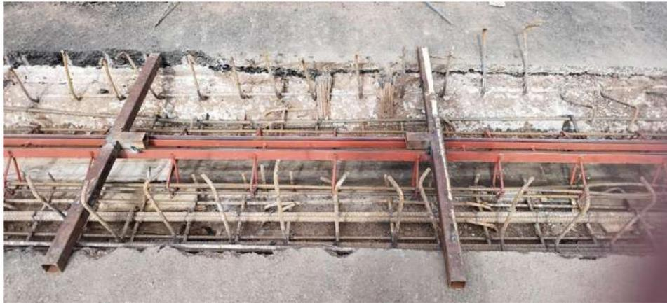
Figura 47. Construcción de la junta de expansión
