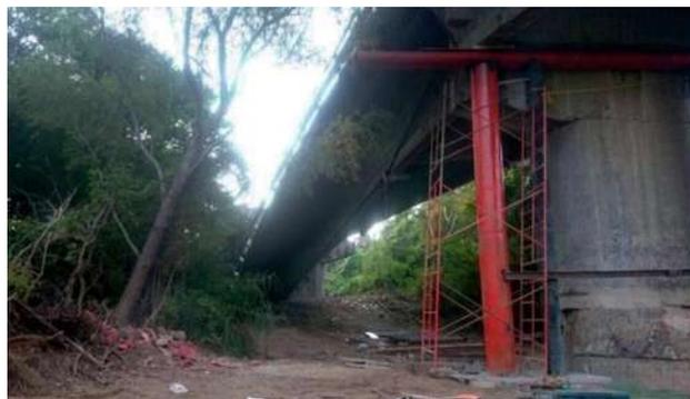
Figura 12. Daño Ocasionado por el sismo en pila (Gobierno de Oaxaca,2017)
