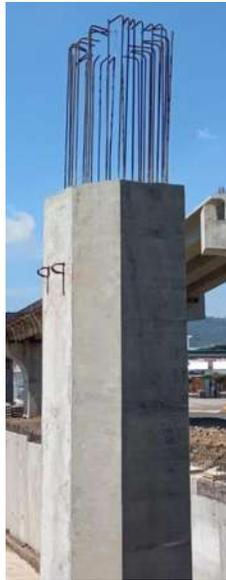
*Figura 55. Montaje de pila columna (elemento prefabricado)*
