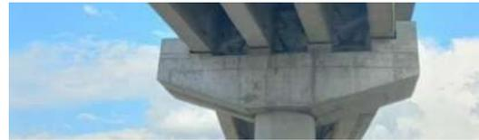
*Figura 50. Cabezal montado sobre la pila y sobre esta apoyados las vigas longitudinales (AASHTO tipo IV)*
