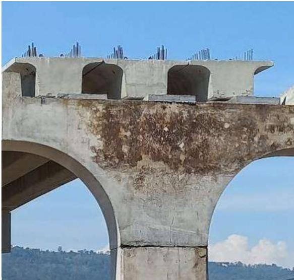
Figura 42. Viga cajón
