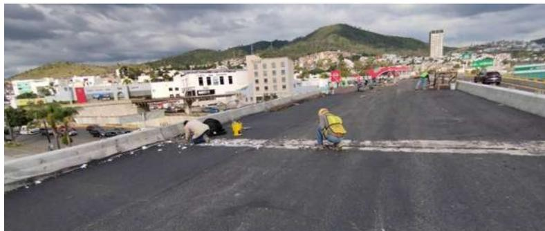
Figura 48. Colocación de la junta de expansión
