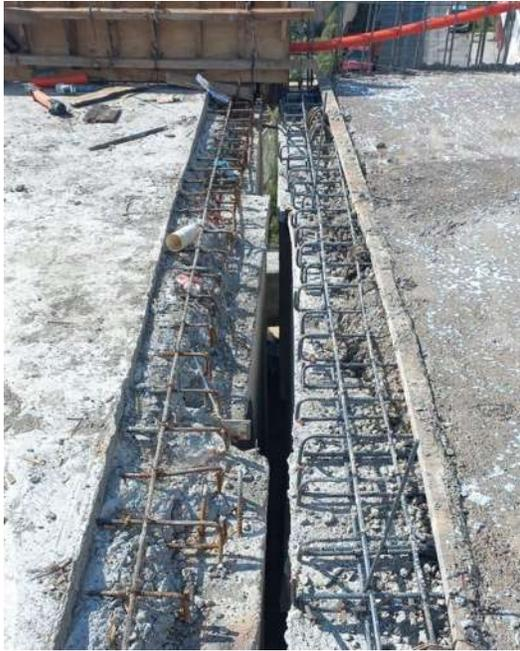
Figura 45. Construcción de la junta de expansión
