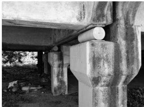
Figura 57. Apoyo tipo rodillo (R&B Construction, 2016)
