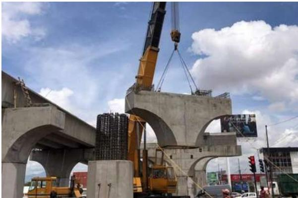
*Figura 49. Montaje de cabezal sobre la pila (elemento prefabricado)*
